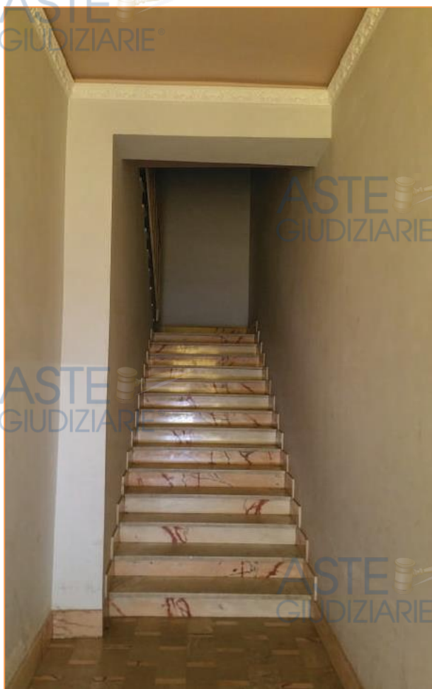
Foto 2 - Vista Sul vano scala
