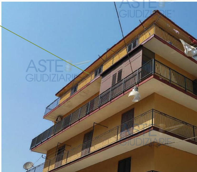
Foto 1 - Vista Complesso Edilizio - lato Sud
