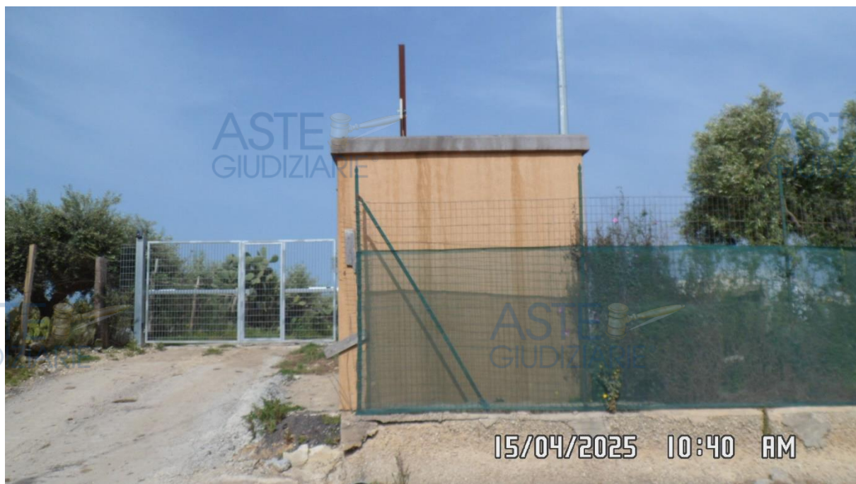
Foto 1 – Veduta della cabina elettrica da Est
