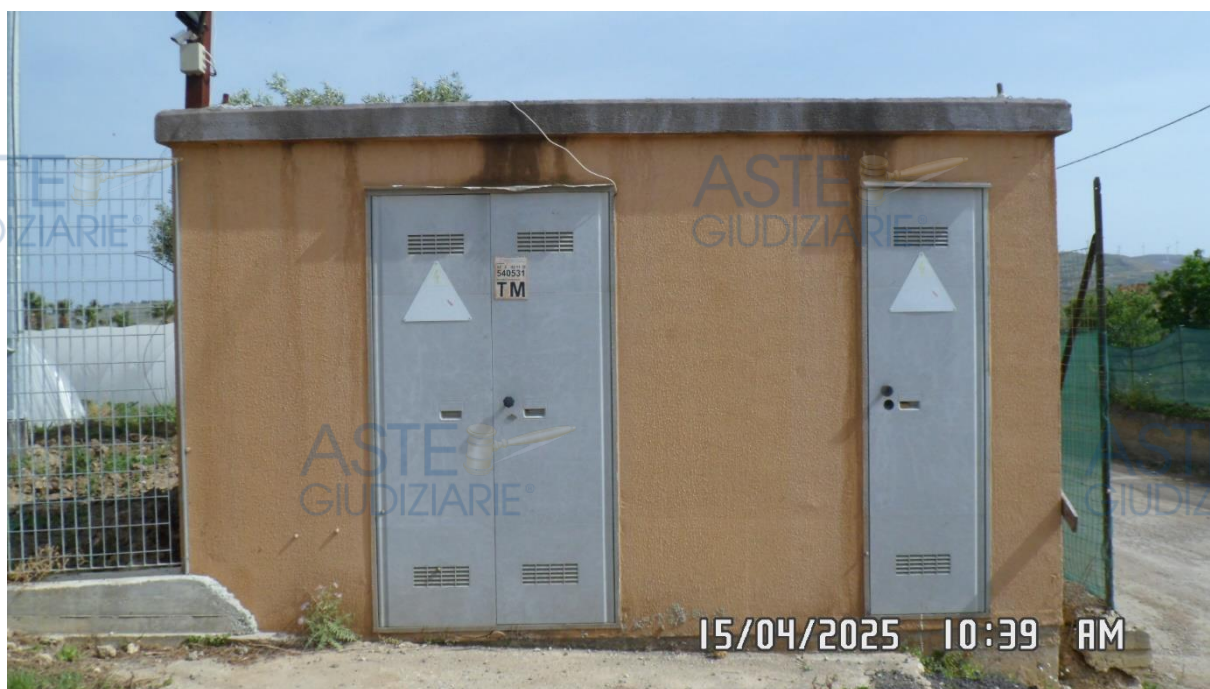
Foto 4 – Veduta della cabina elettrica da sud
