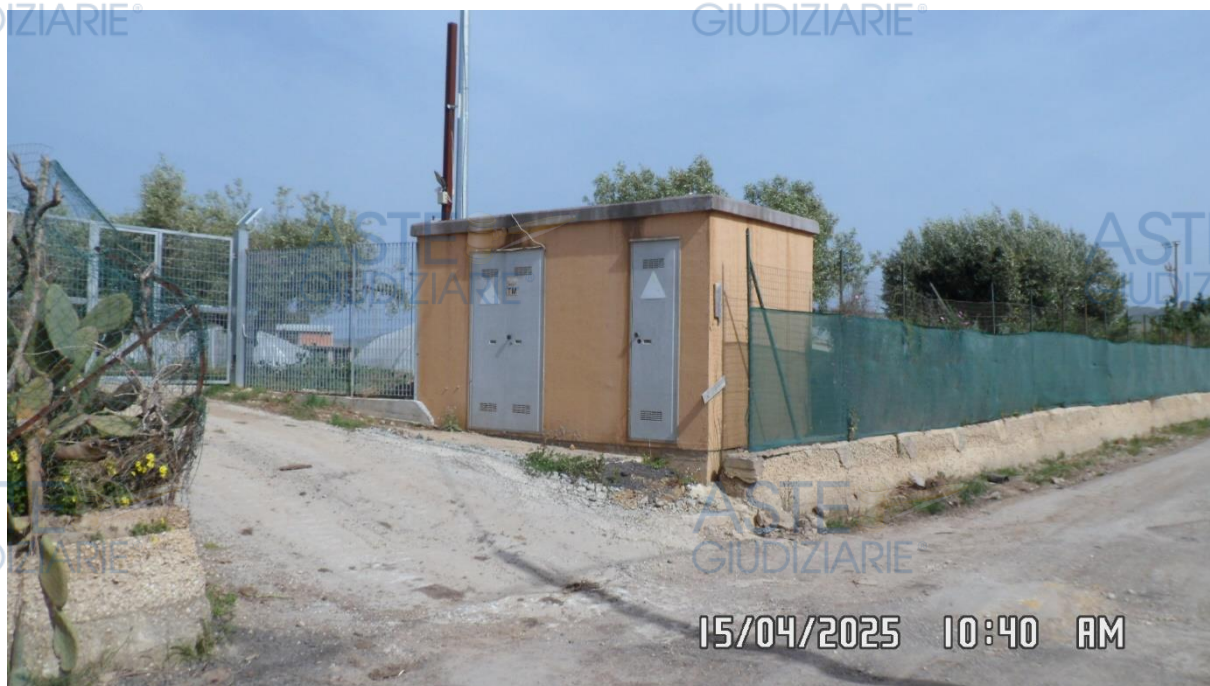
Foto 5 – Veduta della cabina elettrica da Sud Est
