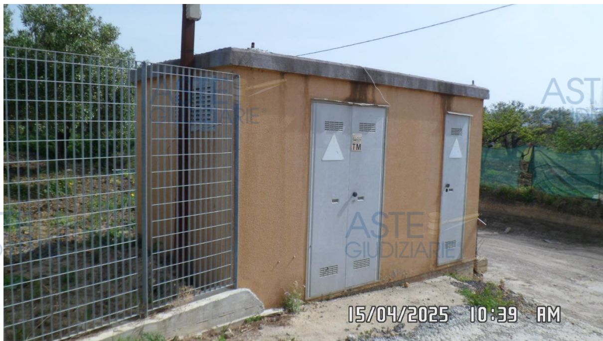
Foto 3 – Veduta della cabina elettrica dalla stradella
