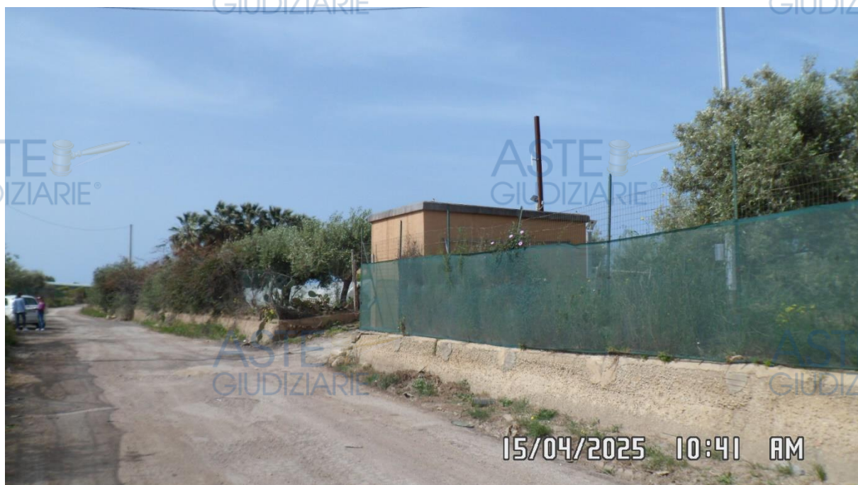
Foto 6 – Veduta della cabina elettrica da Nord
