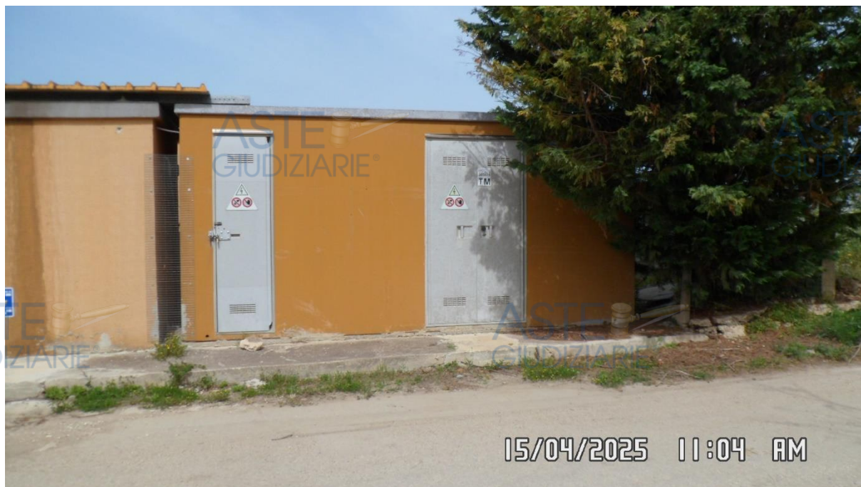
Foto 3 – Veduta della cabina elettrica da viale Punta Bianca
