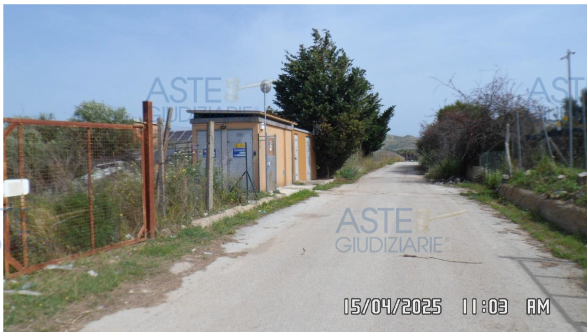
Foto 1 – Veduta della cabina elettrica da Sud
