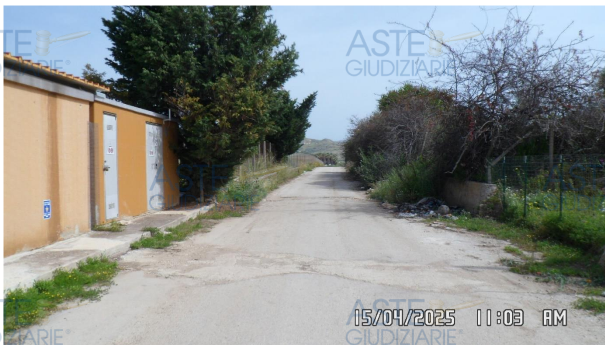
Foto 2 – Veduta del lato est della cabina elettrica
