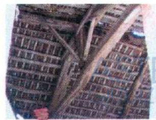
Ad oggi si presenta in discrete condizioni per quanto riguarda la struttura, mentre il tetto versa in condizioni pessime con piccole porzioni crollate e parti pericolanti.
