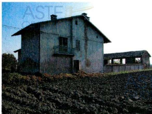
Il fabbricato è a schiera doppia, realizzato con struttura portante in muratura, solai in putrelle e voltini di laterizi, murature di tamponamento perimetrale piene e prive di isolamento.
