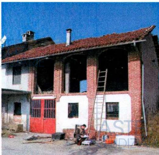
Il fabbricato, aggiunto in un secondo tempo all'impianto originale, era un tempo adibito a stalla con soprastante fienile. E' stato realizzato con muratura portante in mattoni, solaio in voltini di laterizi e putrelle in ferro. Il tetto è a due falde inclinate con orditura in legno, capriate alla Piemontese e passafuori a vista in legno. La soprastante copertura è in coppi e la lattoneria in lamiera.
