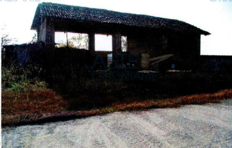
Trattasi di una tettoia a nudo tetto, realizzata con pilastri e murature di mattoni pieni, divisa in due parti tramite muro di blocchetti in c.a.
