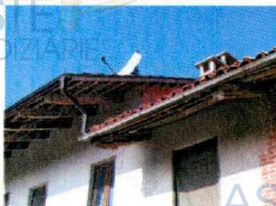
Il tetto è a falde inclinate con tipologia "a capanna" costituito da copertura in tegole tipo "Portoghesi" su orditura in legno con passafuori a vista, con aggetto di 1 metro circa.
