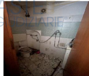
Figura 26: Vista del WC
