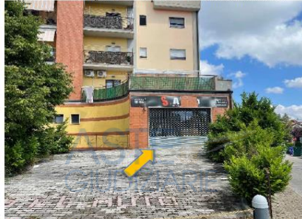
Figura 7: Vista accesso locale staggito da Via Morra
