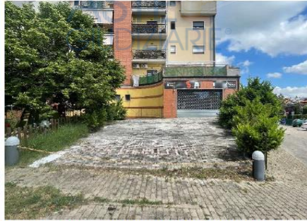
Figura 5: Vista fabbricato da Via Isabella Morra
