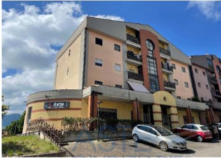
Figura 4: Vista fabbricato da Via Antonio De Curtis
