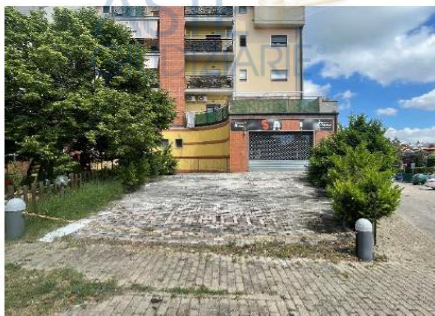
Figura 5: Vista fabbricato da Via Isabella Morra
