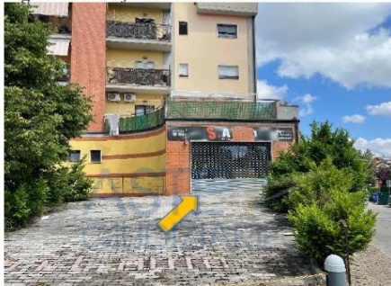
Figura 7: Vista accesso locale staggito da Via Morra
