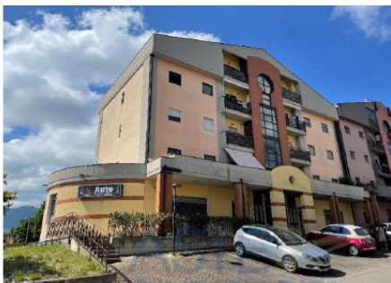
Figura 4: Vista fabbricato da Via Antonio De Curtis
