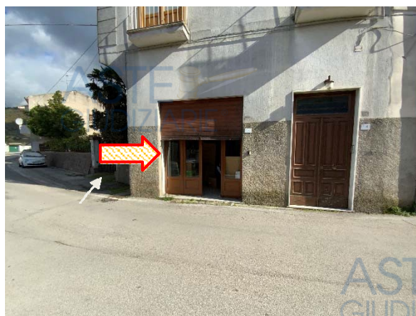
Accesso al deposito dal civ. 6 di Via Insteia
