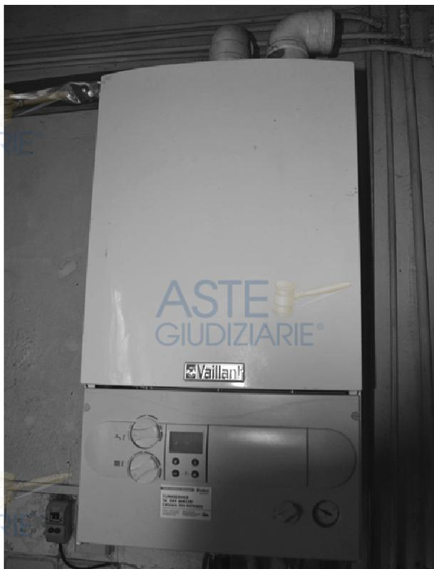
**foto 27** - m.n. 63 - sub 3 (secchiaio) - Caldaia murale a camera stagna, a tiraggio forzato e a condensazione, marca VAILLANT, mod. VMW 242, pot. ut. 24 kW, cod. Circe 201900158395. Responsabile dell'impianto è il locatario. Lo scarico a filo muro (alto sx) viola la Legge 90/2013 (art. 17bis).
