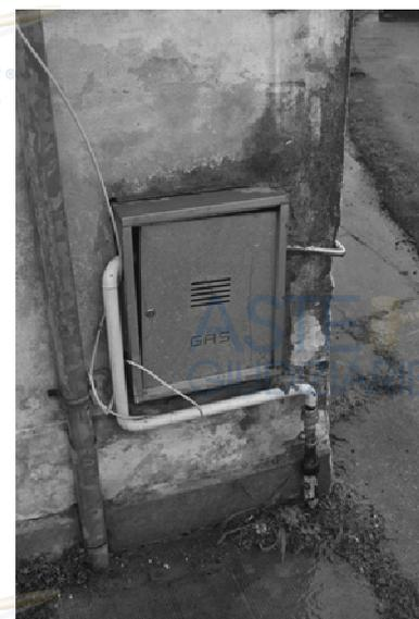
**foto 12** - sub 3 (spigolo est) - L'immobile è allacciato alla rete gas. L'adduzione è sprovvista di valvola d'intercettazione.
