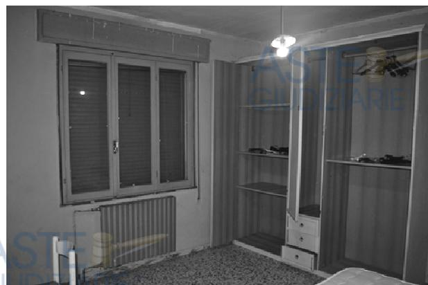
**foto 19** - sub 3 (letto 3) - I corpi scaldanti, di tutta evidenza installati in epoca successiva alla prima costruzione del fabbricato, non alloggiano mai in nicchie sottodavanzale. La finestra dà sul pogggiolo e, pertanto, sulla via maestra.
