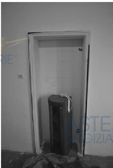
**foto 5** - sub 3 (ingresso) - La porta verso il secchiaio è chiusa da un pannello fissato al muro.
