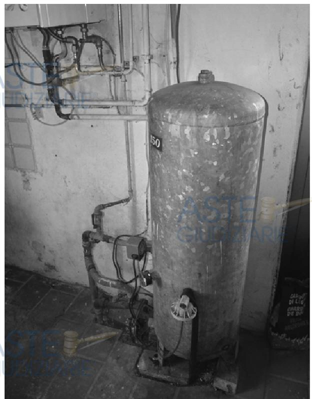
**foto 28** - m.n. 63 - sub 3 (secchiaio) - L'accumulo, non coibentato, raccoglie l'acqua corrente prelevata in falda. La capienza del serbatoio è di 150 lt. La rumorosità e il rimbombo dell'autoclave, con ogni probabilità, sono nitidamente udibili fino al primo piano (cioè fino alla zona notte).
