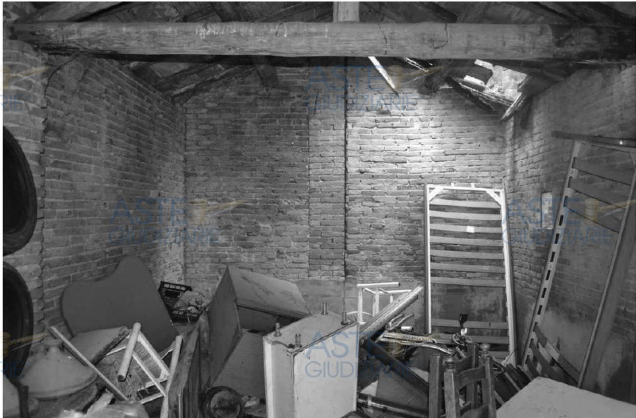
**foto 29** - m.n. 64 ("legnaia" o, più propriamente, annesso accessorio) - l'involucro murario, costituito da pannelli a una testa, ha delle sporgenze in raddoppiamento di spessore dove l'architrave d'ingresso scarica sulle maestà e agli appoggi della capriata intermedia. Per quanto l'indice di qualità dell'apparecchiatura si attesti su un livello medio, il ridotto spessore del grosso dei muri riduce quasi al minimo l'area d'impronta.
