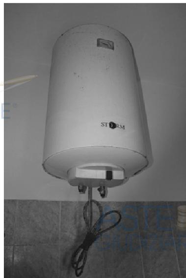
**foto 25** - sub 3 (bagno) - Il bollitore elettrico installato nel wc al piano terra è fuori uso da tempo non meglio specificato.
