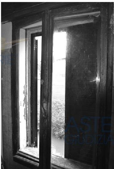
**foto 13** - sub 3 (secchiaio) - Qui la qualità degli infissi, in particolare quanto alla prestazione termica, è particolarmente scadente.
