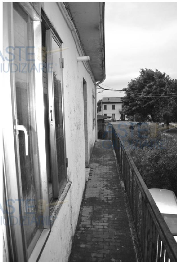
**foto 5** - m.n. 63 sub 3 (poggiolo) – La pavimentazione dell'aggetto è annerita di muschio. La linea di gronda è sprovvista di lattoneria rompigoocia.
