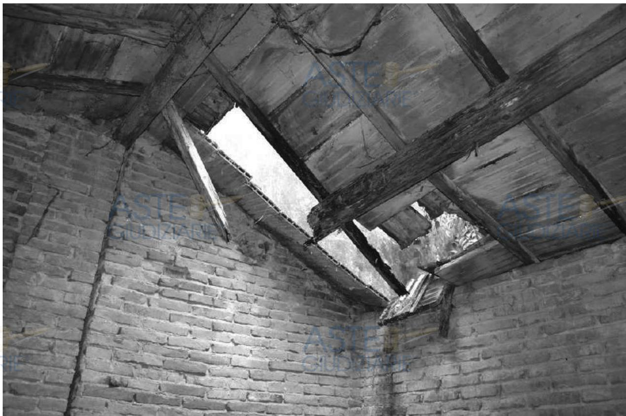
foto 30 – m.n. 64 (“legnaia” o, più propriamente, annesso accessorio) – L’ordito secondario di copertura è costituito da tavelle su conventini. La falda, in corrispondenza dell’angolo sudovest, è sfondata sopra un arcareccio primario spezzato – con tutta la struttura costantemente aggredita dalle intemperie.
