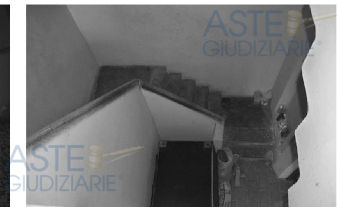
**foto 12** - sub 3 (scala) - Se escludiamo la gradinata di collegamento col bagno al primo piano, la scala interna consta di n. 14 pedate, n. 2 mezzanini e n. 17 alzate da apx 19,5cm ognuna.
