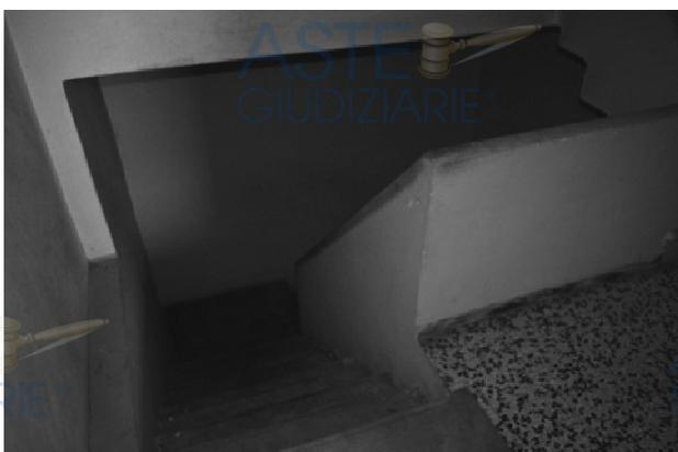
**foto 11** - sub 3 (scala) - La rampa di sbarco, verso il muro in comune con la u.i.u. contermine, forma una risega abbastanza vistosa e catastalmente non rappresentata.
