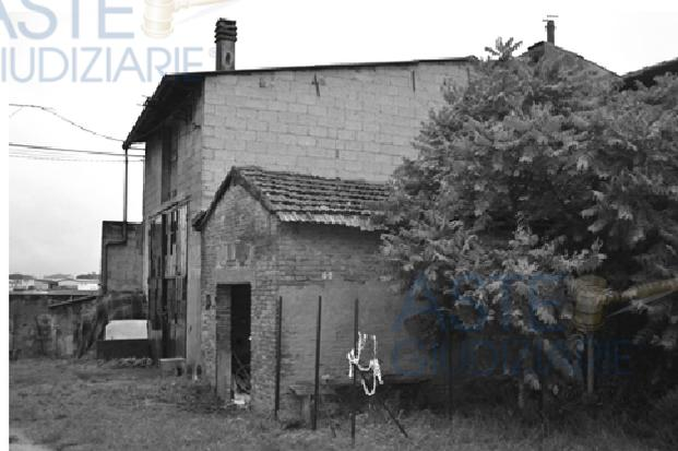
**foto 8** - m.n. 64 (visto da ovest) - Dove la falda del tetto è nascosta dalla chioma dell'albero, la copertura è sfondata a cielo aperto. Il costo delle riparazioni, sommato a quello della sanatoria, in pratica azzerava il valore venale del bene. Il portale d'ingresso, che misura 170x195 cm, non è attraversabile da normali automezzi.
