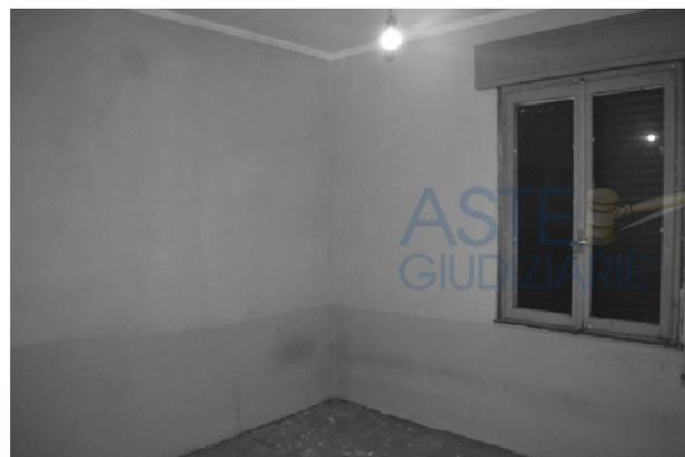
**foto 17** - sub 3 (letto 1) - Aloni di umidità sui muri. Infisso in legno (interno) e in alluminio (esterno), col sistema a doppio vetro che si riscontra quasi ovunque altrove. Tapparelle con avvolgimento in cassonetto non coibentato.
