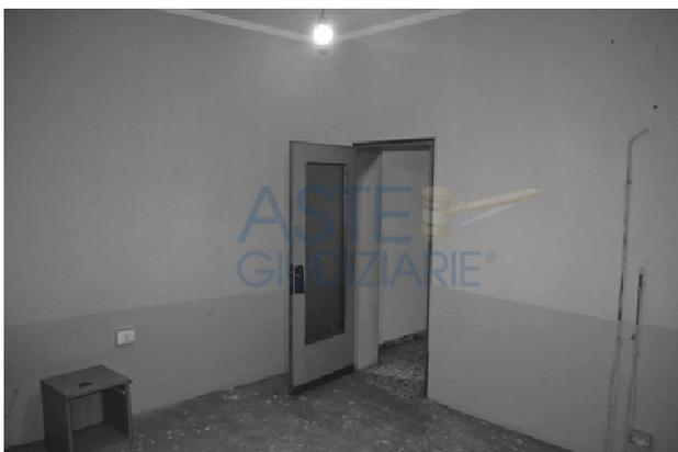
**foto 16** - sub 3 (letto 1) - Qui come ovunque altrove al primo piano le finiture sono invece da far risulire almeno al trentennio. Ancora porta interna in vetro stampato. Cablaggi elettrici fuori traccia.
