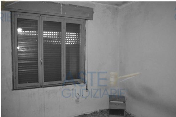
**foto 22** - sub 3 (letto 2) - Estese infiorescenze, all'incirca sempre dalla quota del davanzale finestra in giù, si osservano anche sul muro fronte strada e sul divisorio. Non è chiaro se la ritinteggiatura in corso al pianterreno voglia spingersi fino al primo piano.
