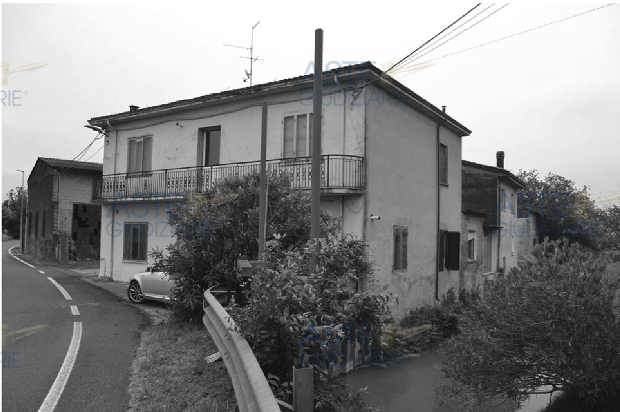
**foto 3** – m.n. 63 sub 3 (visto da nord) – Tutto il fianco nordovest del compendio è lambito dallo scolo *Tregonn*, che peraltro passa sotto il ponticello che dà nome alla via maestra. L'abitazione pignorata funge da punto d'appoggio per cavi in bassa tensione e/o telefonici. In foto si vede bene che l'imbibizione dei muri a ridosso del corso d'acqua si spinge praticamente fino al primo corso di davanzali.
