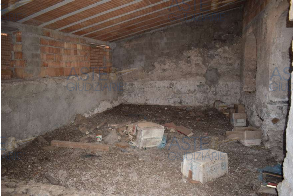
Foto n.13 – Abitazione al piano secondo (sottotetto).
