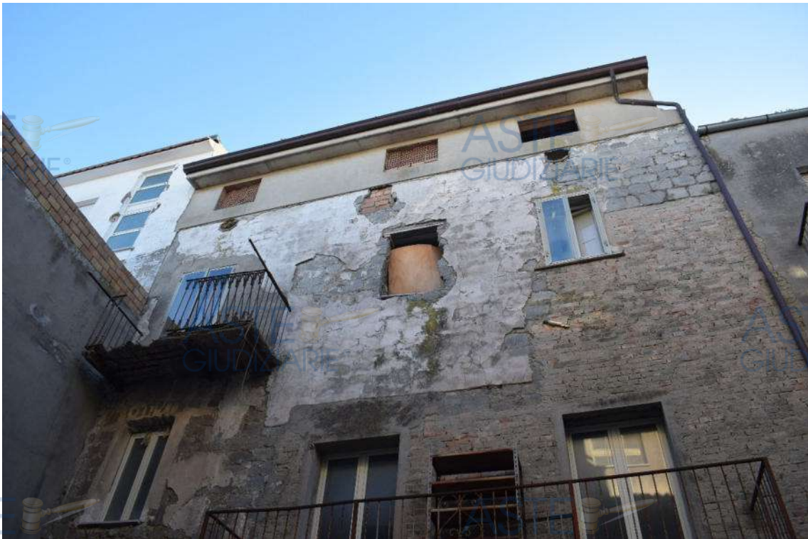
Foto n.4 – Prospetto nord-ovest, prospiciente cla corte di pertinenza..
