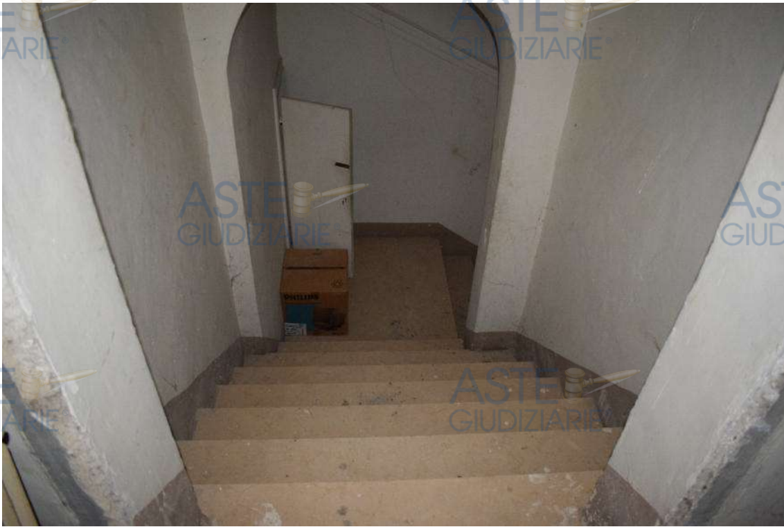
Foto n.15 – Scale di collegamento tra i piani terra e primo.
