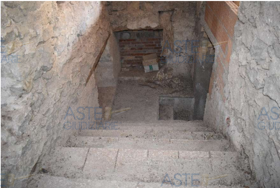
Foto n.14 – Scale di collegamento tra i piani primo e secondo.
