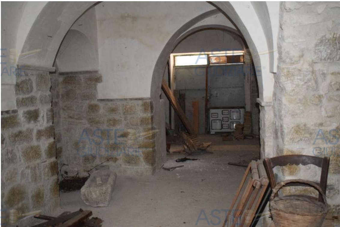
Foto n.18 – locali cantina al piano seminterrato.
