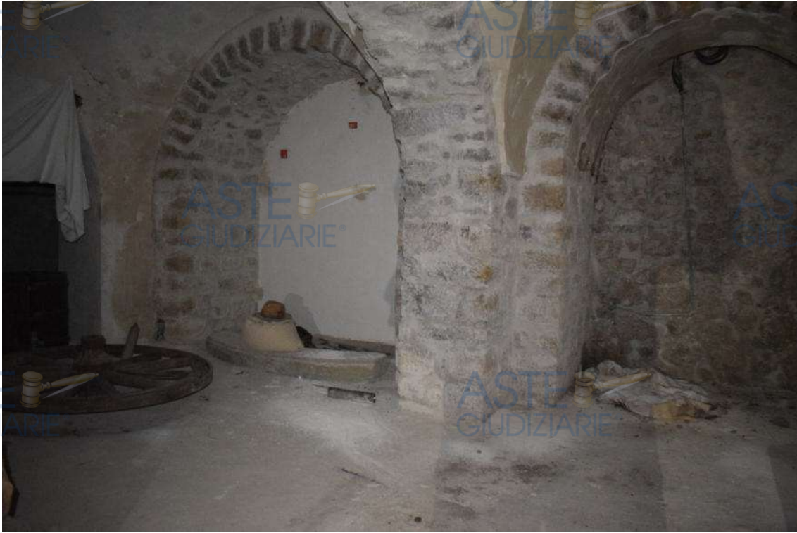
Foto n.17 – locali cantina al piano seminterrato.
