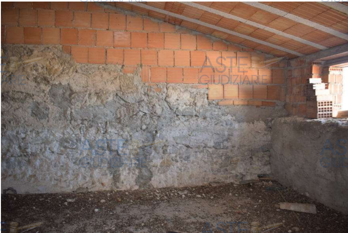
Foto n.12 – Abitazione al piano secondo (sottotetto).
