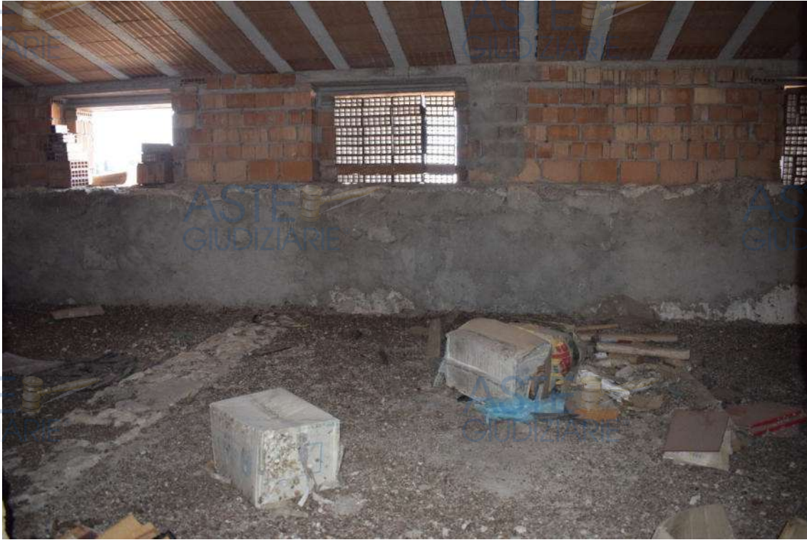
Foto n.11 – Abitazione al piano secondo (sottotetto).
