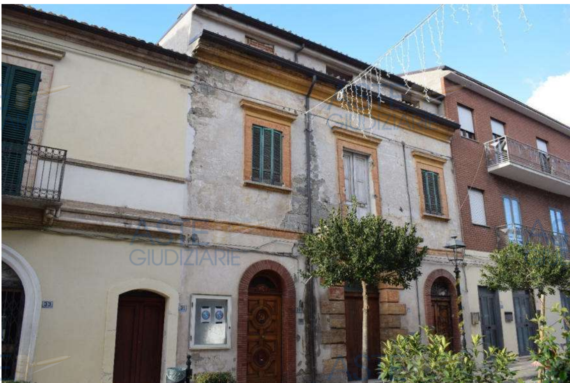
Foto n.2 – Prospetto sud-est, prospiciente corso Remo Gaspari.
