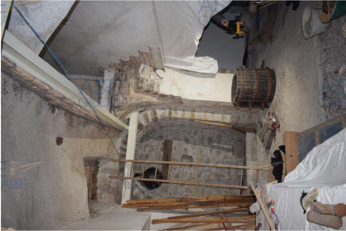
Foto n.19 – locali cantina al piano seminterrato (foro predisposizione vano scala).
