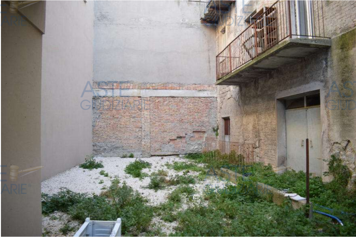
Foto n.3 – Prospetto nord-ovest, prospiciente cla corte di pertinenza..
