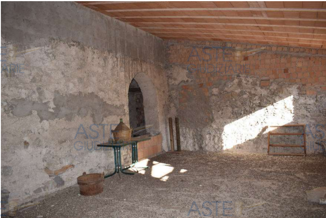
Foto n.14 – Abitazione al piano secondo (sottotetto).
