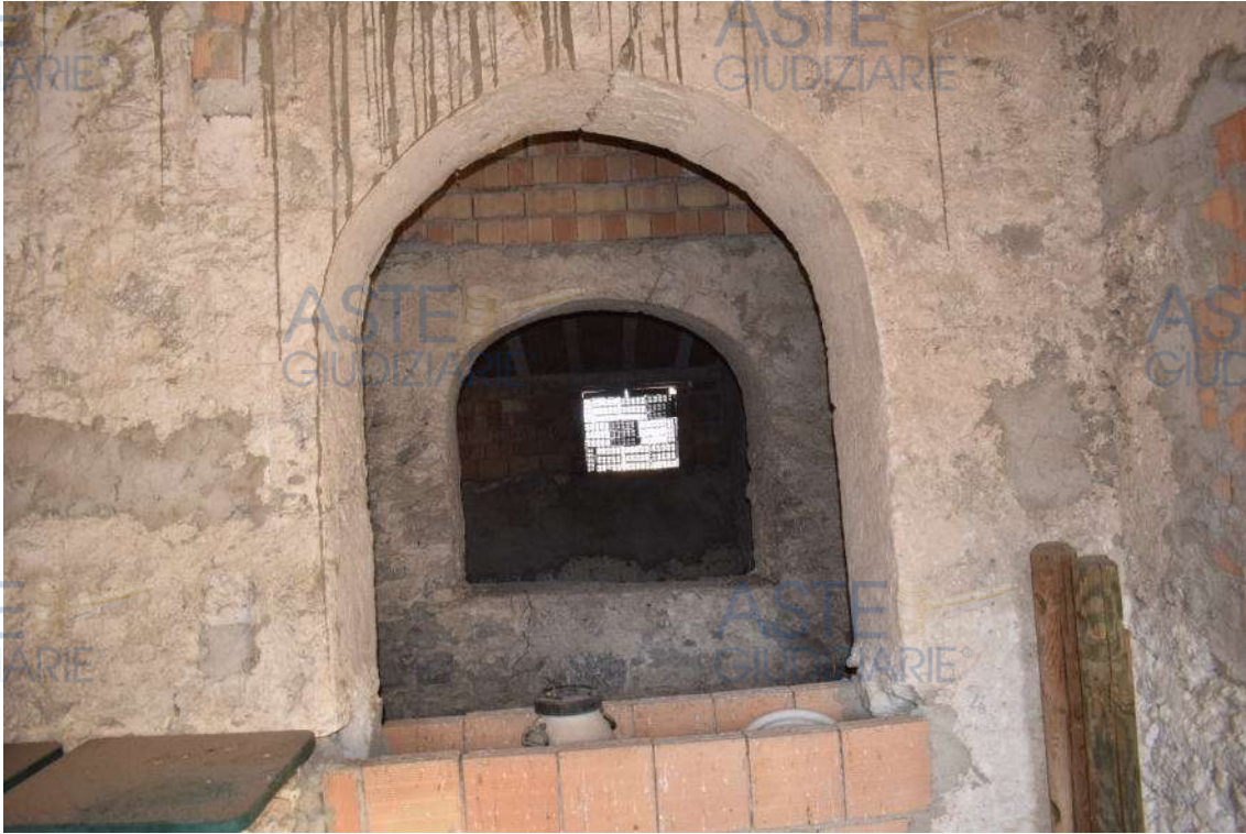
Foto n.13 – Abitazione al piano secondo (sottotetto).
