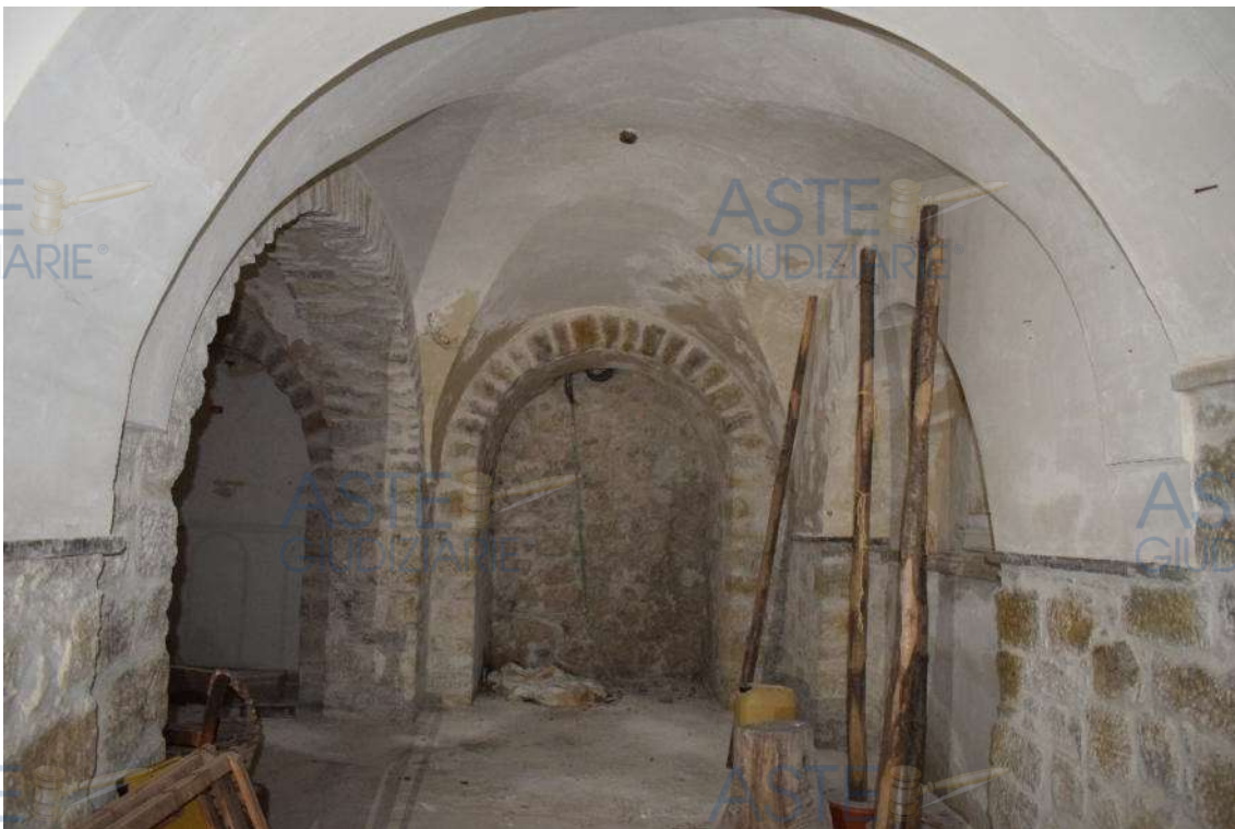
Foto n.16 – locali cantina al piano seminterrato.
