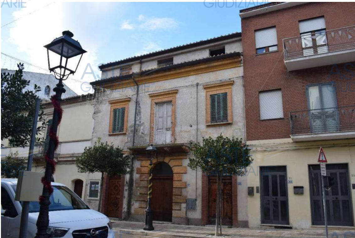
Foto n.1 – Prospetto sud-est, prospiciente corso Remo Gaspari.
