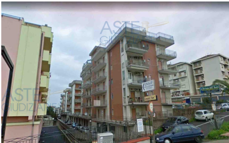
Foto 1 – Via del Mare, 58/D – Carlentini - Appartamento piano terra
