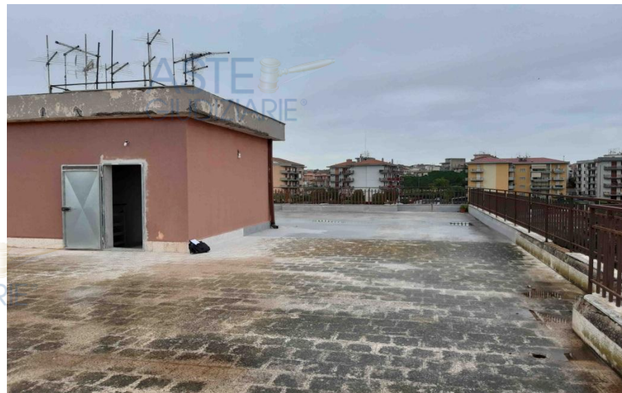
Foto 26 – Terrazza di copertura
