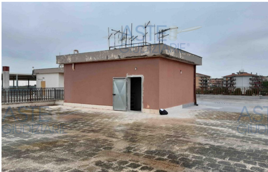
Foto 25 – Terrazza di copertura
