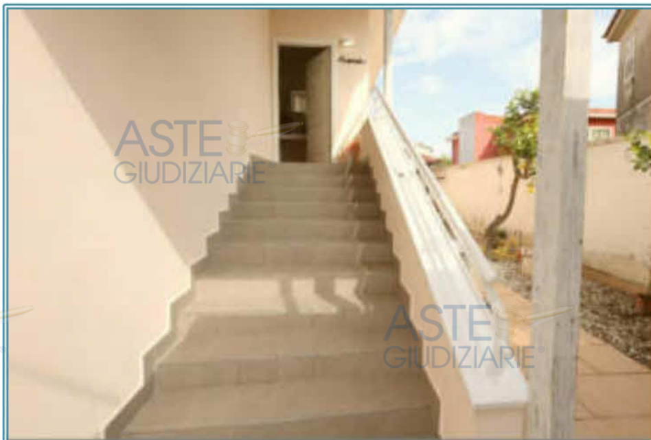
FOTO 29 - Scala di accesso all'appartamento
