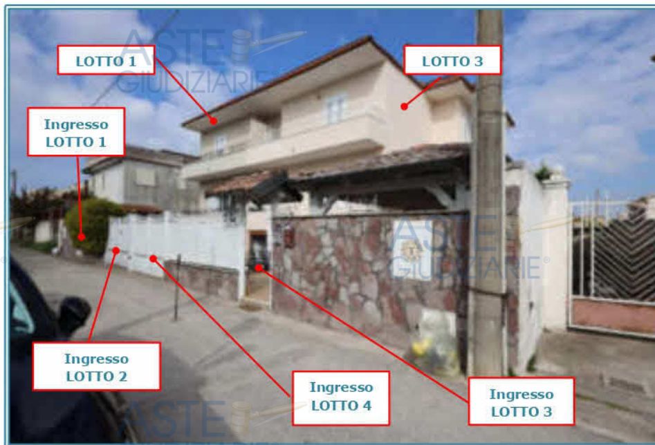
FOTO 1 - Ingressi al fabbricato da Via Perugia
