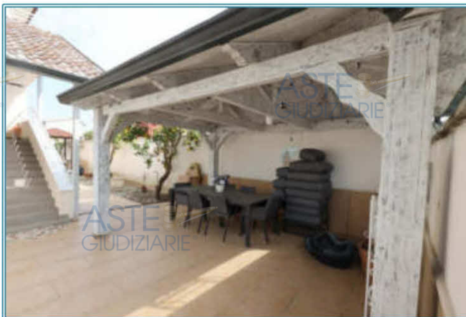
FOTO 28 - Tettoia realizzata sul cortile esterno (sub. 2)
