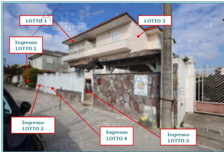
FOTO 1 - Ingressi al fabbricato da Via Perugia
