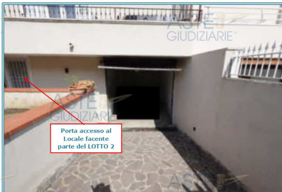
FOTO 20 - Rampa accesso al box
