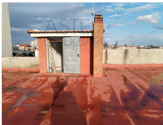
Foto n°16- Vista del terrazzo di copertura
