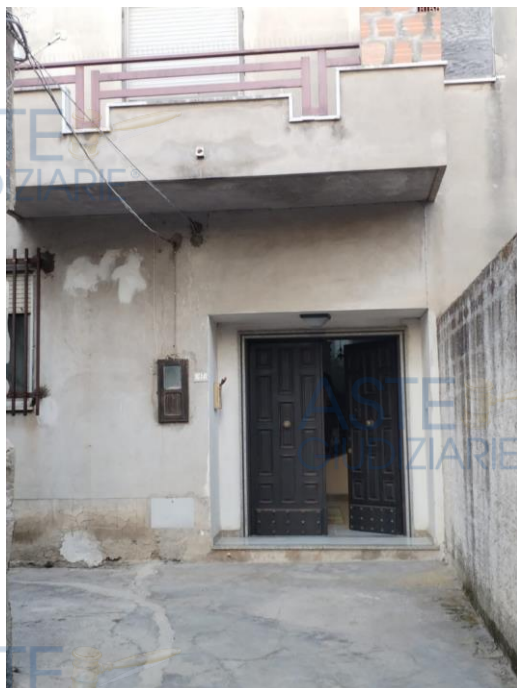
Foto n°1- Vista dell'ingresso pedonale del fabbricato
