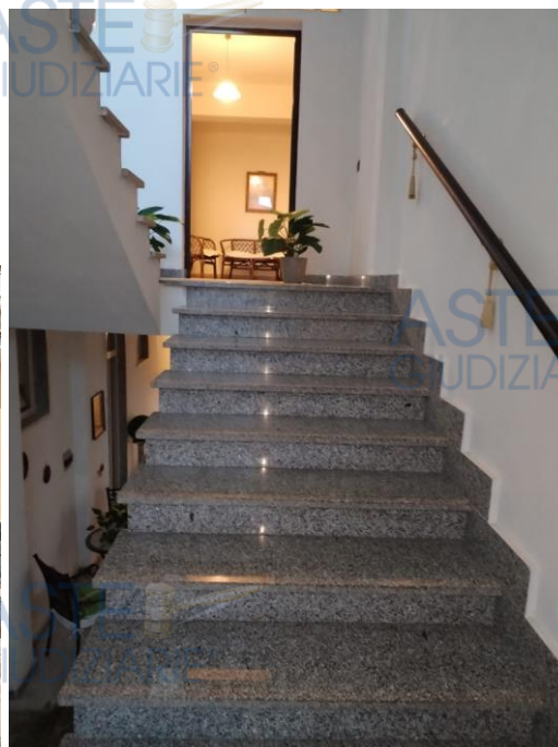
Foto n°10- Vista della scala di accesso al P.1
