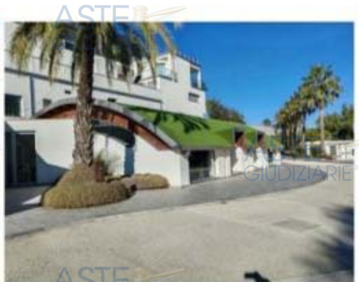
Foto n. 18 - Vista area esterna e prospetti fabbricato principale
