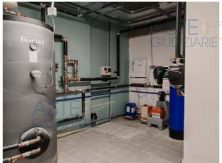
Foto n. 274 – Sala eventi "Pavillon" - Fg. 53 part. 449 sub 1 - piano interrato
