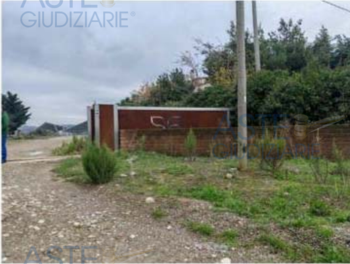
Foto n. 371 – Fg. 54 part. 881 sub 1 – impianto fotovoltaico – accesso
