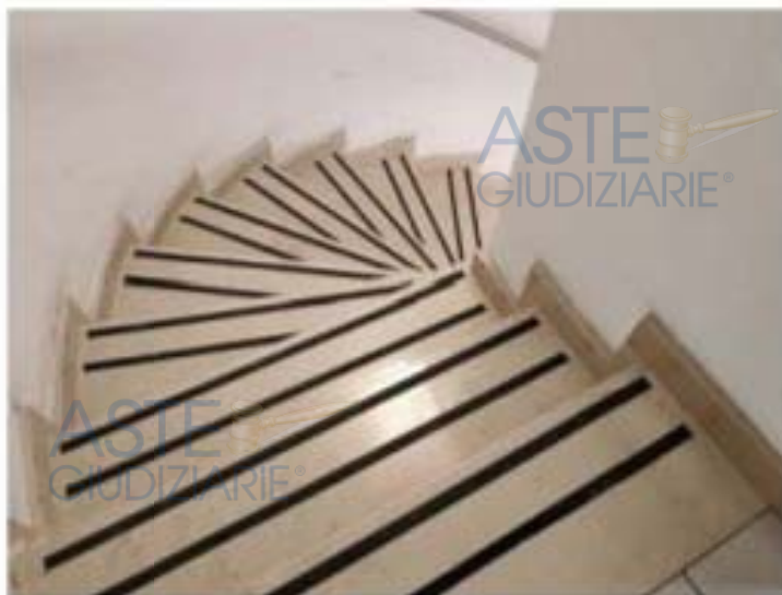
Foto n. 21 - Fg. 63 part. 1 sub 4 - piano secondo interrato
