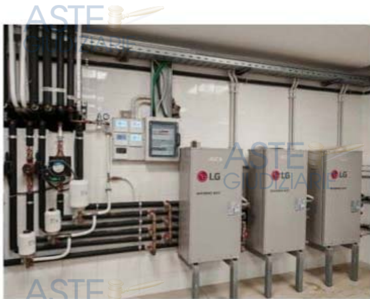
Foto n. 293 – Fabbricato "Club House" - Fg. 53 part. 443-444 sub 1 - piano interrato
