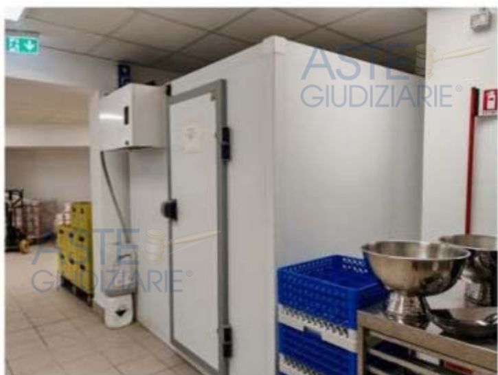
Foto n. 297 – Fabbricato "Club House" - Fg. 53 part. 443-444 sub 1 - piano interrato
