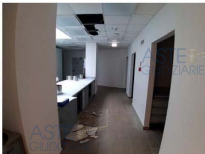
Foto n. 260 – Sala eventi "Pavillon" - Fg. 53 part. 449 sub 1 - piano interrato
