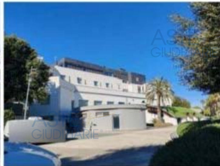
Foto n. 16 - Vista area esterna e prospetti fabbricato principale
