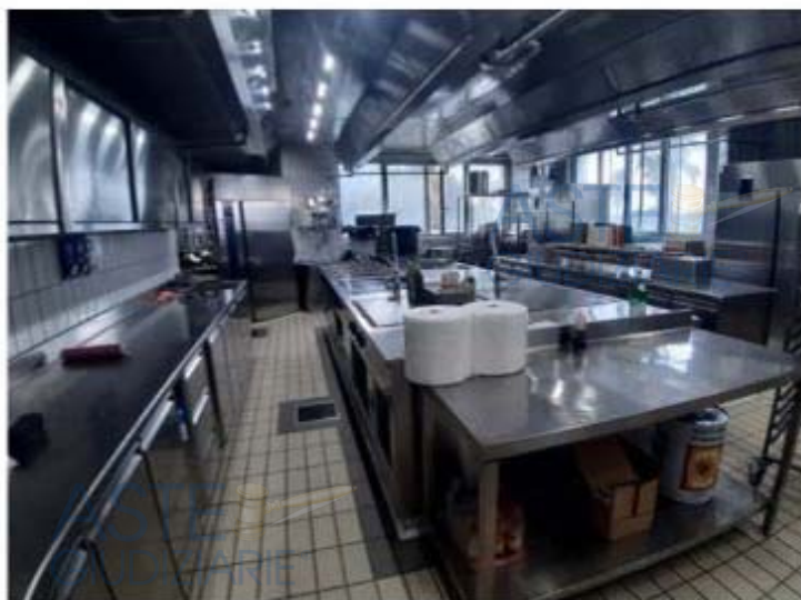
Foto n. 85 – Fg. 53 part. 1 sub 4 - piano terra
