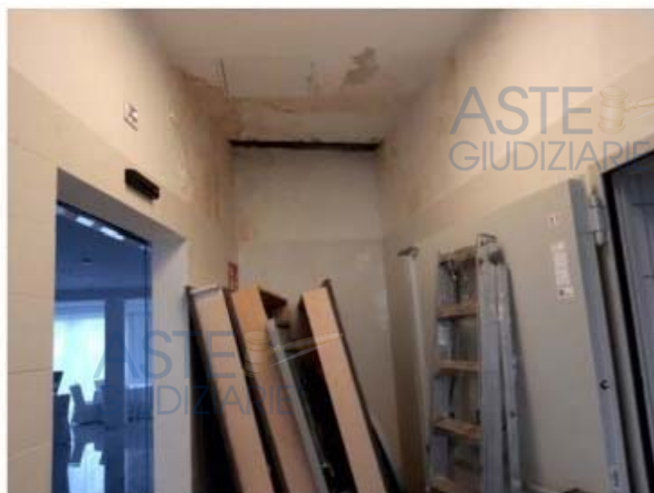
Foto n. 94 - Fg. 53 part. 1 sub 4 - piano terra
