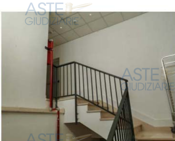
Foto n. 258 – Sala eventi "Pavillon" - Fg. 53 part. 449 sub 1 - piano interrato
