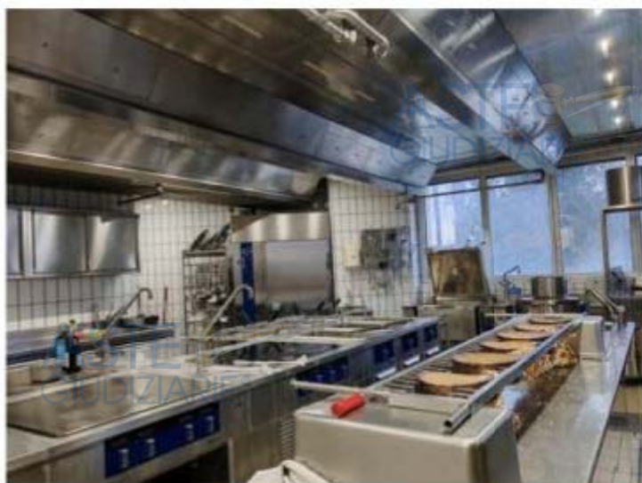
Foto n. 87 – Fg. 53 part. 1 sub 4 - piano terra
