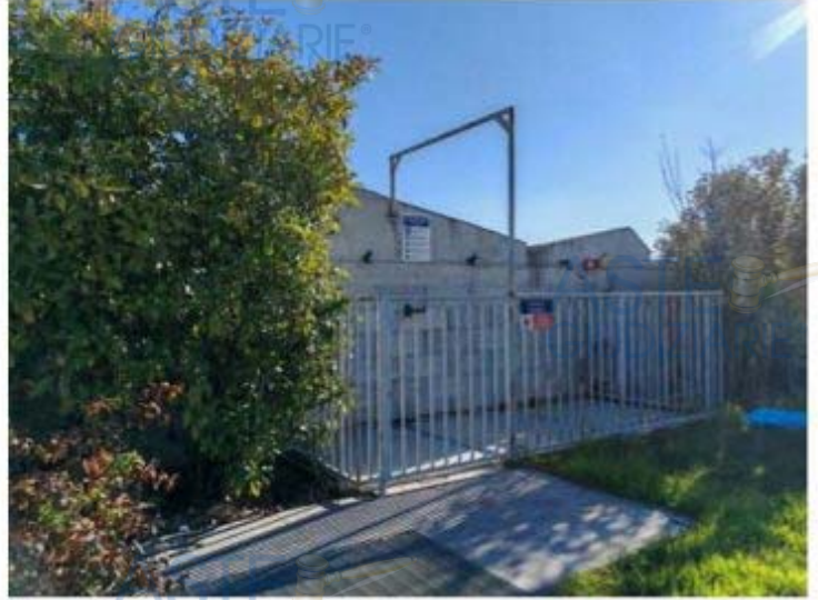
Foto n. 216 – Fg. 53 part. 1 sub 4 – piscina – locale impianti
