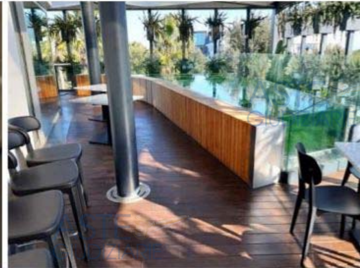
Foto n. 350 – Fabbricato "Club House" - Fg. 53 part. 443-444 sub 1 - piano secondo
