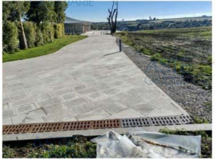
Foto n. 234 – Vista area esterna e prospetti fabbricato "Pavillon"
