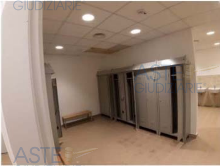
Foto n. 269 – Sala eventi "Pavillon" - Fg. 53 part. 449 sub 1 - piano interrato
