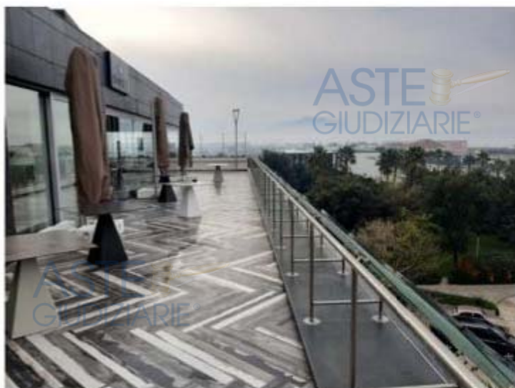
Foto n. 201 – Fg. 53 part. 1 sub 4 – terzo piano
