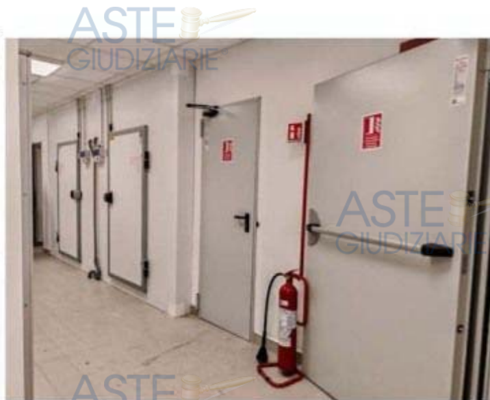
Foto n. 264 – Sala eventi "Pavillon" - Fg. 53 part. 449 sub 1 - piano interrato
