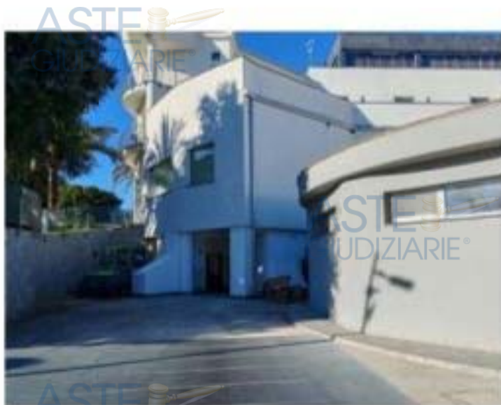
Foto n. 17 - Vista area esterna e prospetti fabbricato principale
