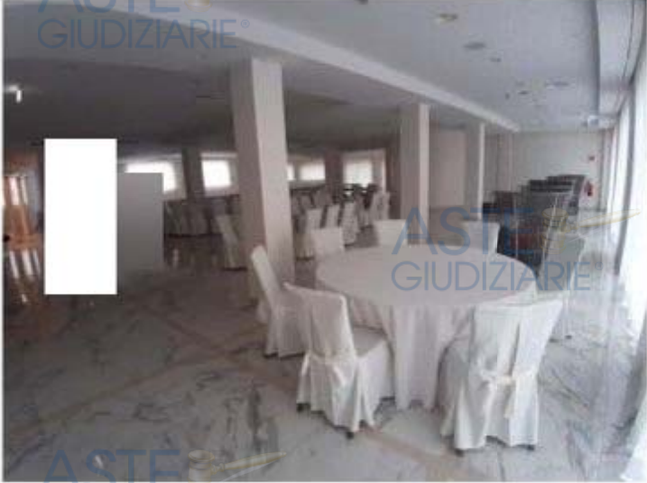
Foto n. 77 - Fg. 53 part. 1 sub 4 - piano terra
