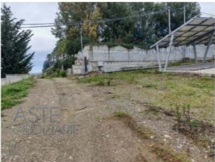
Foto n. 375 – Fg. 54 part. 881 sub 1 – impianto fotovoltaico
