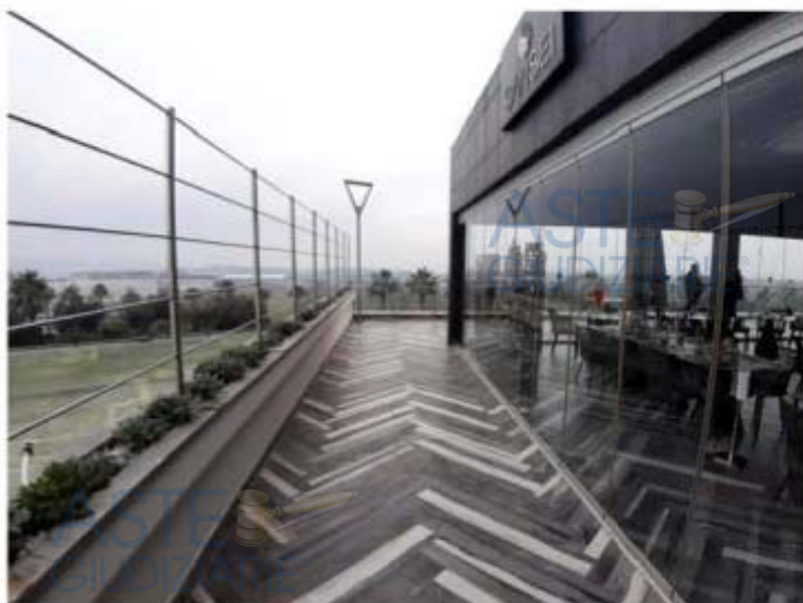
Foto n. 199 – Fg. 53 part. 1 sub 4 – terzo piano
