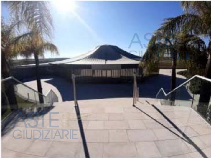
Foto n. 235 – Vista area esterna e prospetti fabbricato "Pavillon"
