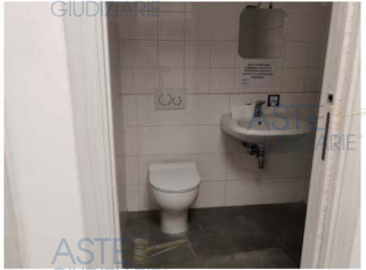
Foto n. 300 – Fabbricato "Club House" - Fg. 53 part. 443-444 sub 1 - piano interrato
