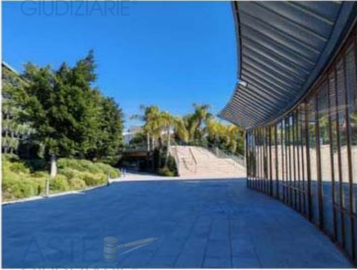
Foto n. 239 – Vista area esterna e prospetti fabbricato "Pavillon"
