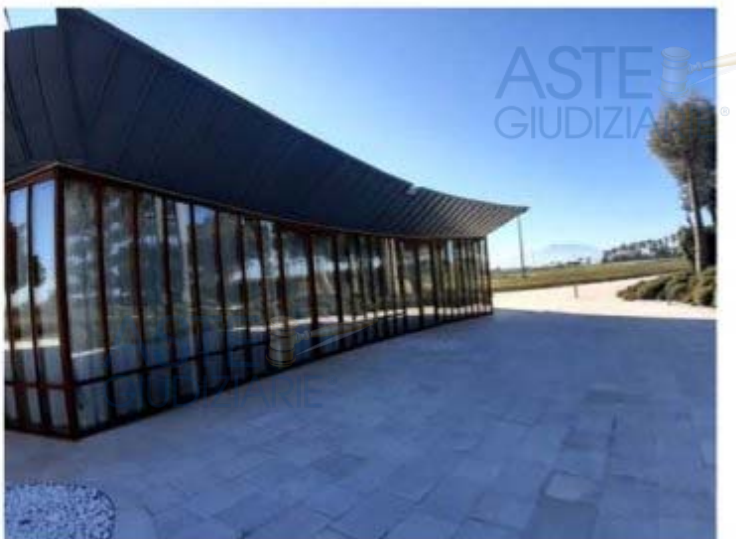
Foto n. 238 – Vista area esterna e prospetti fabbricato "Pavillon"
