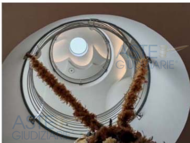
Foto n. 73 - Fg. 53 part. 1 sub 4 - piano terra
