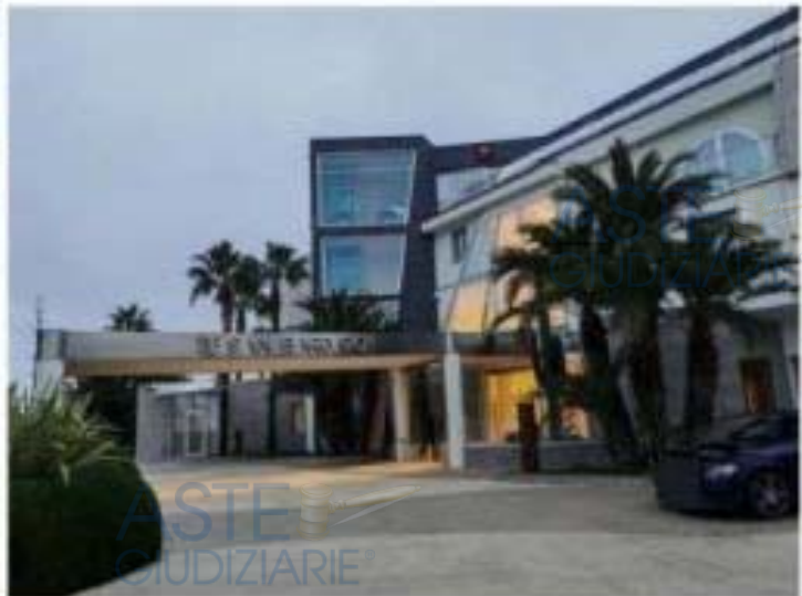
Foto n. 14 - Vista area esterna e prospetti fabbricato principale
