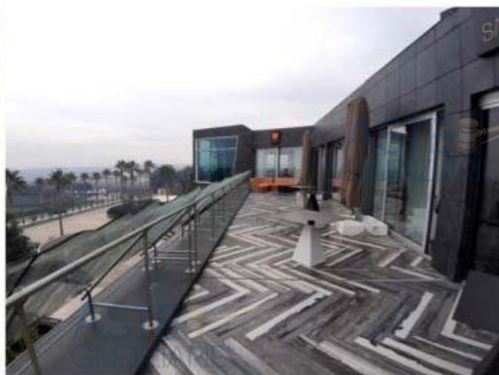
Foto n. 200 – Fg. 53 part. 1 sub 4 – terzo piano
