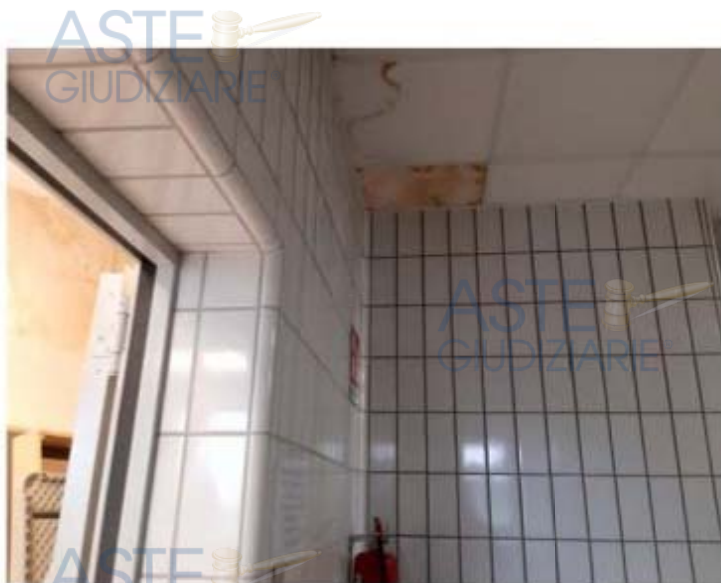
Foto n. 95 - Fg. 53 part. 1 sub 4 - piano terra
