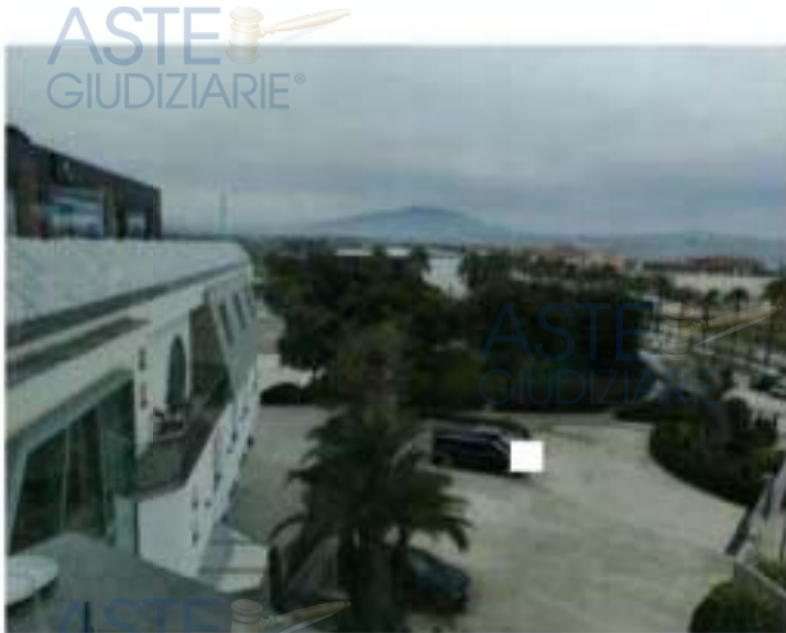
Foto n. 11 - Vista area esterna e prospetti fabbricato principale
