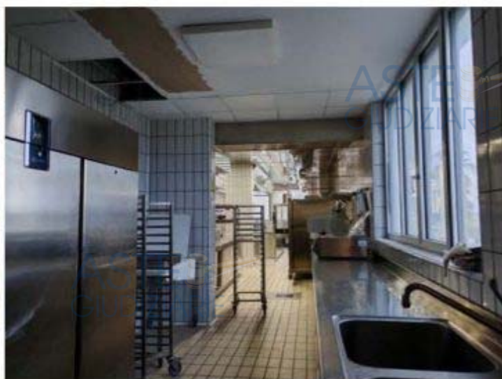
Foto n. 88 – Fg. 53 part. 1 sub 4 - piano terra
