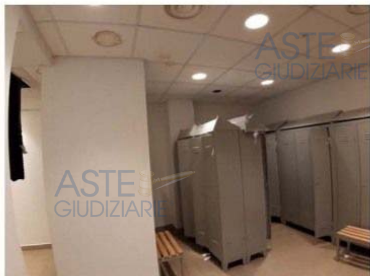
Foto n. 268 – Sala eventi "Pavillon" - Fg. 53 part. 449 sub 1 - piano interrato
