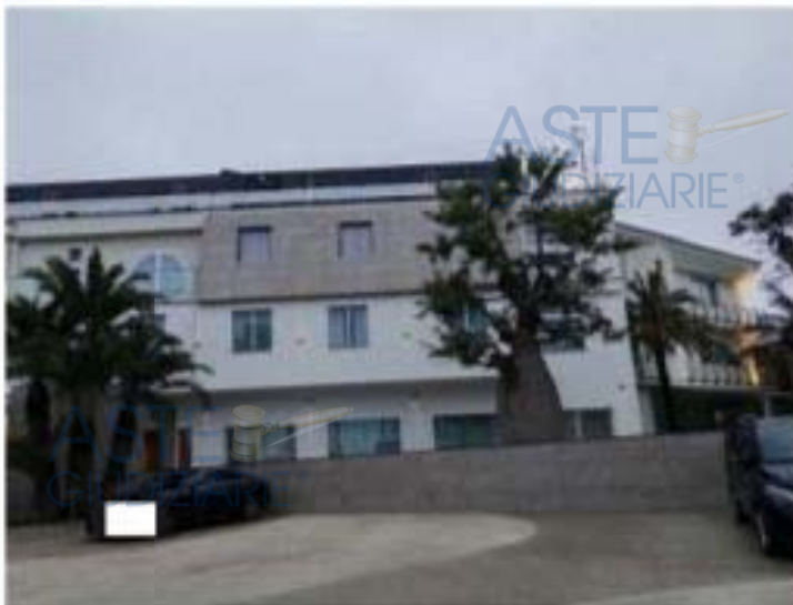
Foto n. 15 - Vista area esterna e prospetti fabbricato principale
