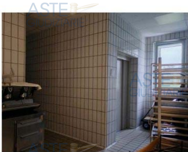
Foto n. 84 – Fg. 53 part. 1 sub 4 - piano terra
