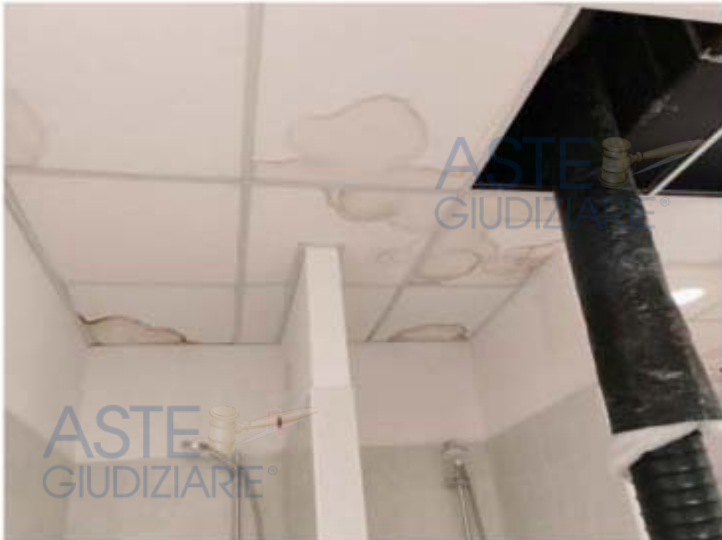
Foto n. 271 – Sala eventi "Pavillon" - Fg. 53 part. 449 sub 1 - piano interrato
