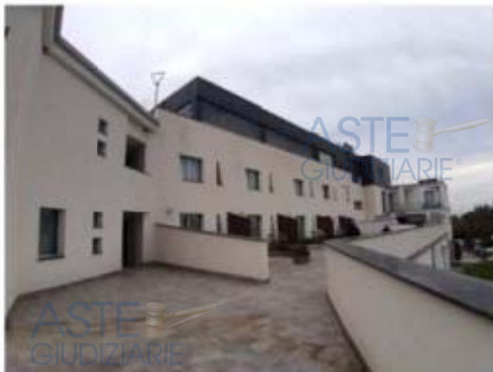
Foto n. 19 - Vista prospetti fabbricato principale
