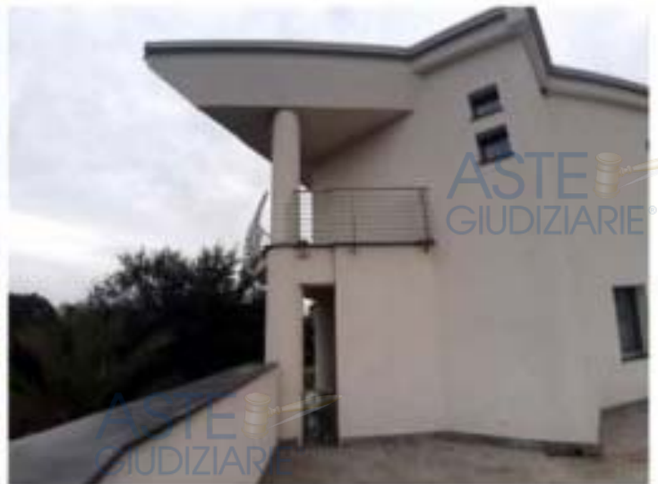
Foto n. 20 - Vista prospetti fabbricato principale
