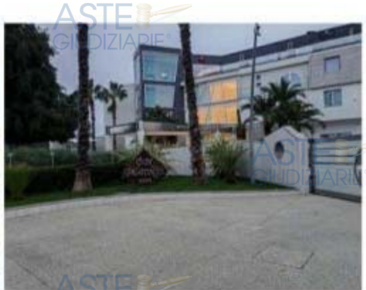
Foto n. 12 - Vista area esterna e prospetti fabbricato principale
