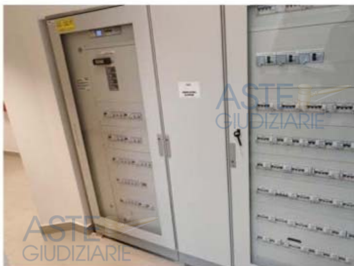
Foto n. 259 – F Sala eventi "Pavillon" - Fg. 53 part. 449 sub 1 - piano interrato
