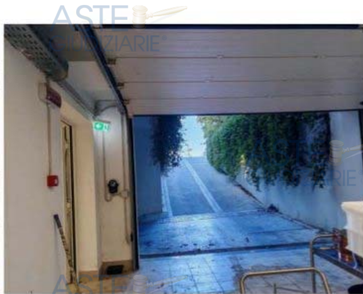
Foto n. 294 – Fabbricato "Club House" - Fg. 53 part. 443-444 sub 1 - piano interrato
