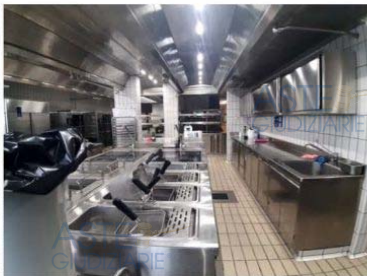
Foto n. 86 – Fg. 53 part. 1 sub 4 - piano terra
