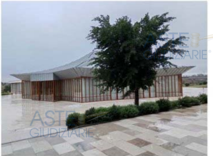
Foto n. 236 – Vista area esterna e prospetti fabbricato "Pavillon"
