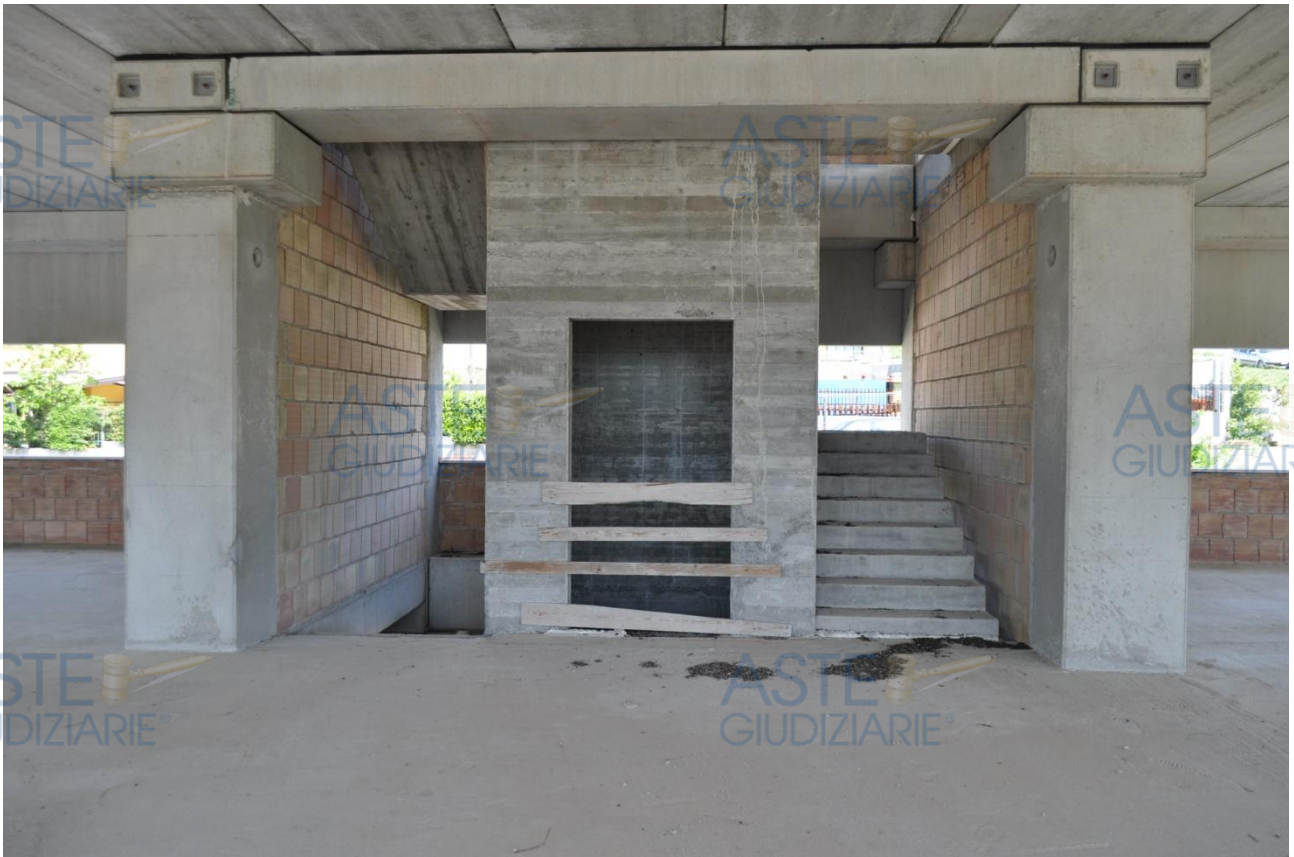
Livello piano terra; scale e vano ascensore
