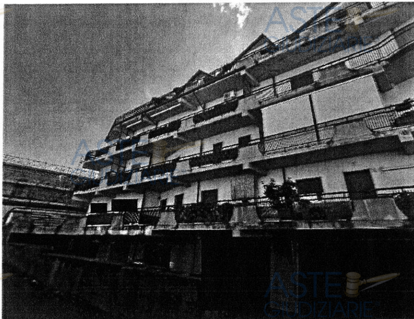
FOTO N.1: prospetto nord-est fabbricato condominiale
