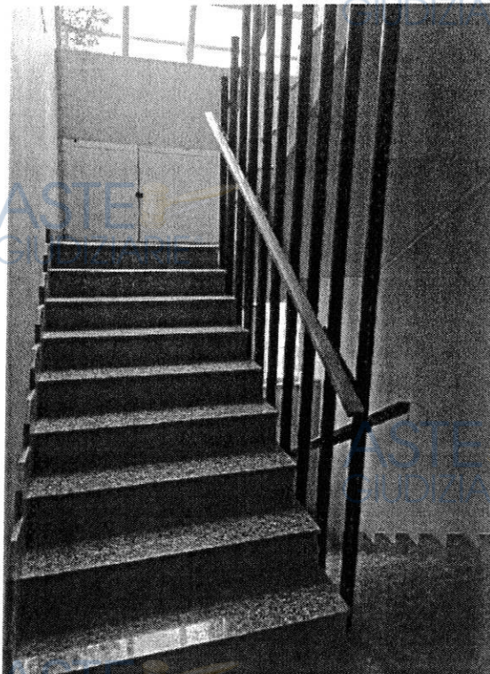
FOTO N.4: vano scala condominiale piano 3
