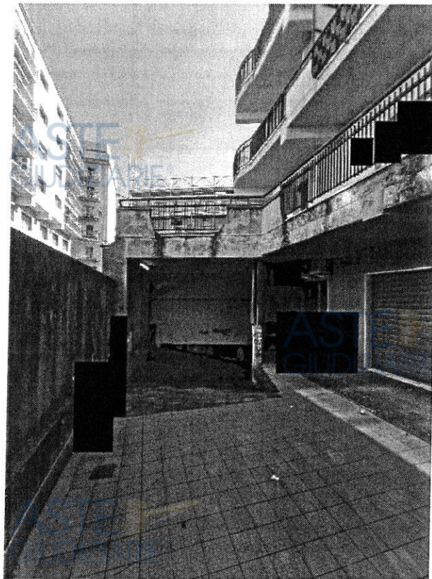
FOTO N.2: rampa accesso piano s1 locali
