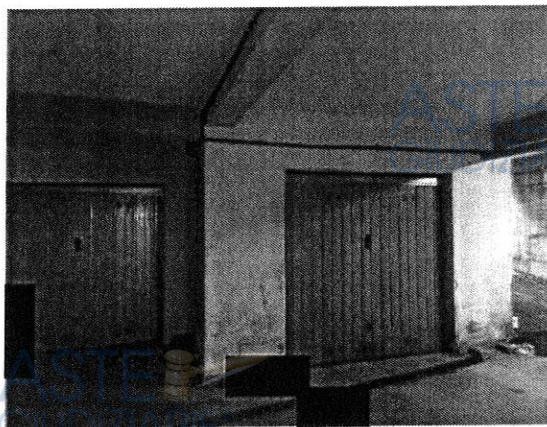
FOTO N.13: porta locale deposito piano s1
