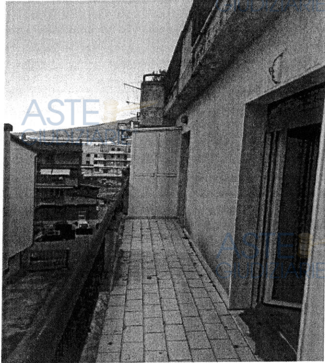
FOTO N.12: balcone prospetto sud-ovest appartamento piano 3
