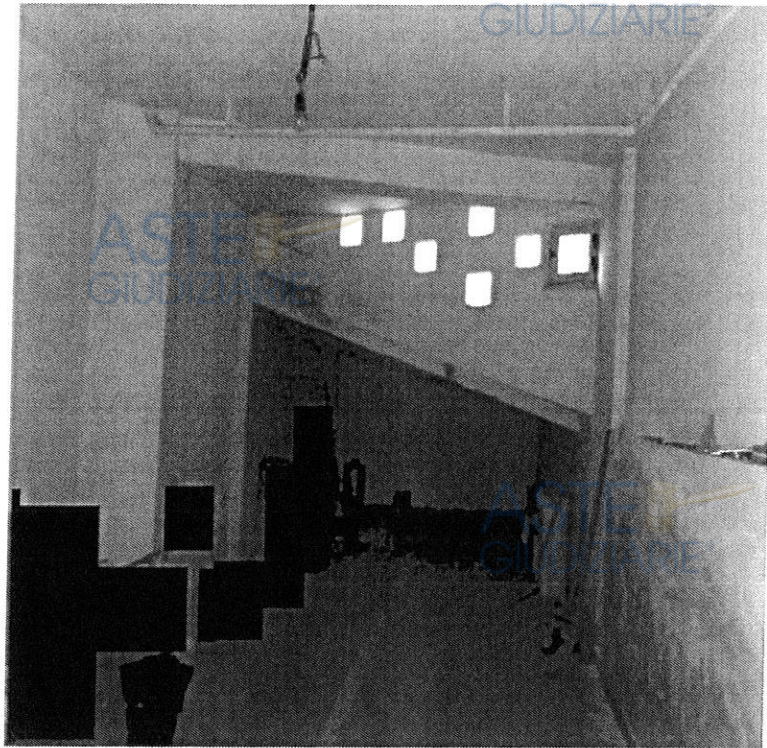
FOTO N.14: interno locale deposito piano s1
