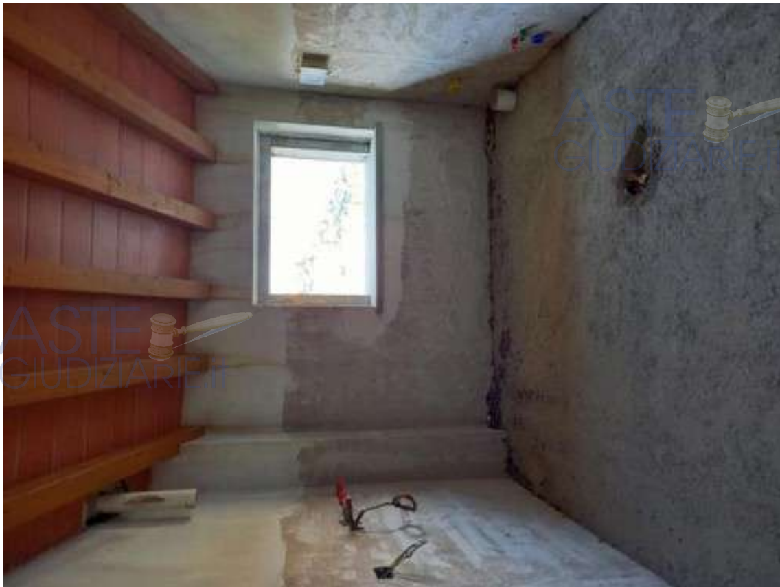
Foto 19 – apertura a tetto locale piano primo
