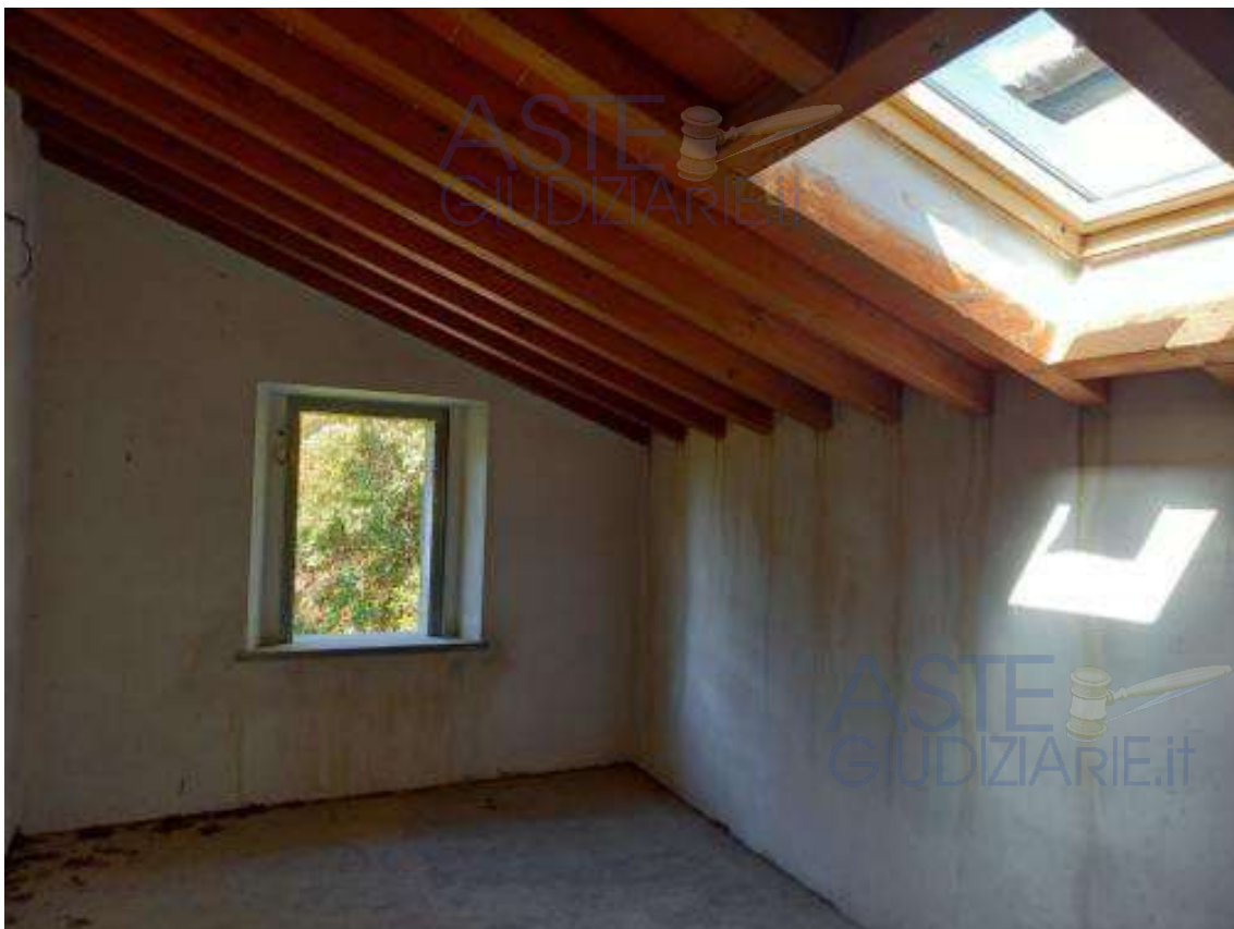
Foto 18 – locale piano primo
