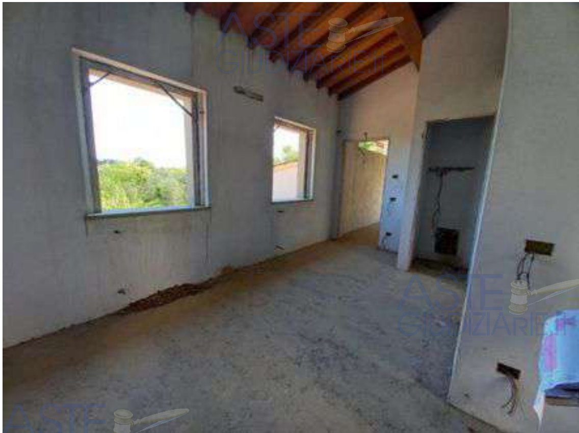
Foto 8 – locali piano primo
