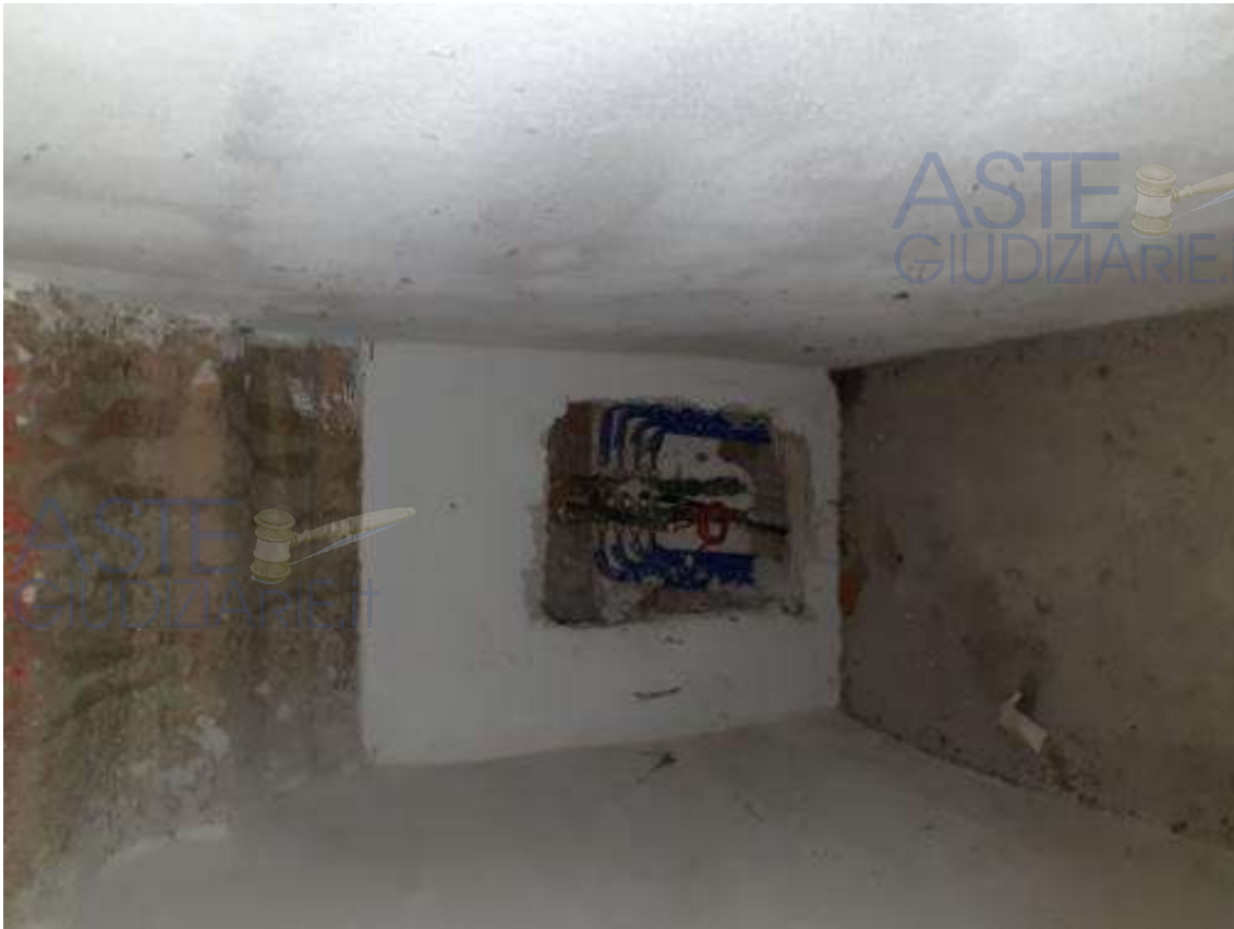
Foto 3- sottoscala piano seminterrato
