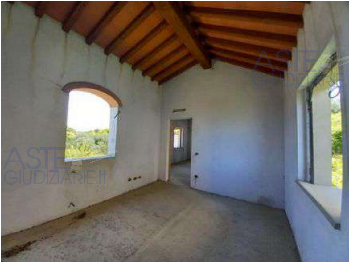
Foto 13 – locale piano primo
