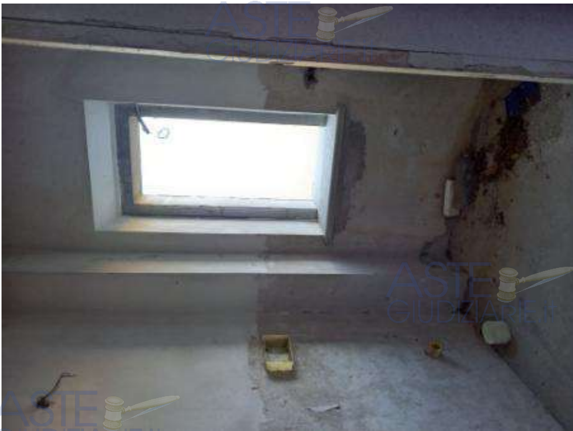
Foto 10 – locale con attacchi wc piano terra
