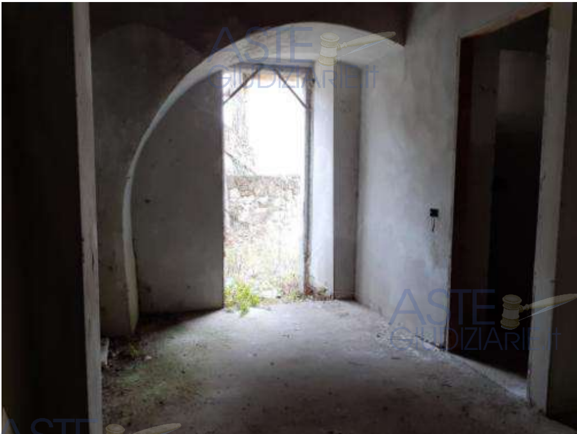
Foto 6 - accesso locale piano seminterrato
