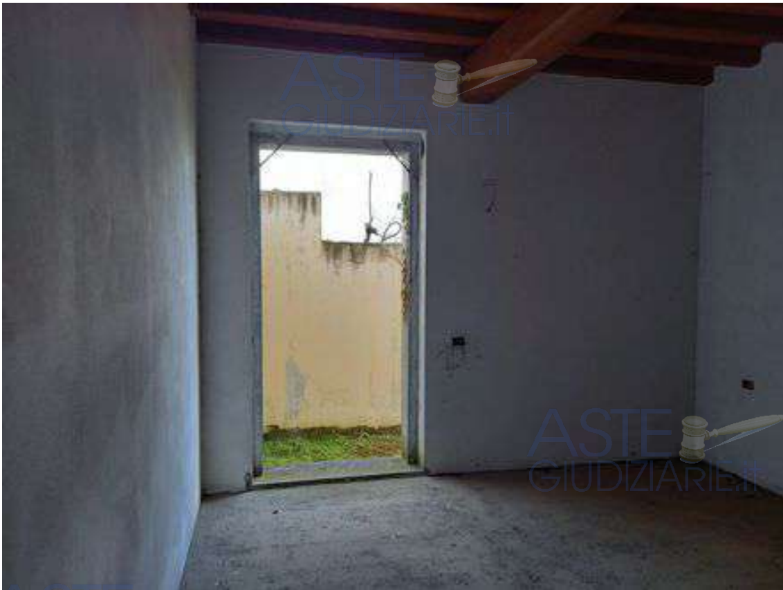
Foto 6 – locale con accesso alla resede esterna piano terra
