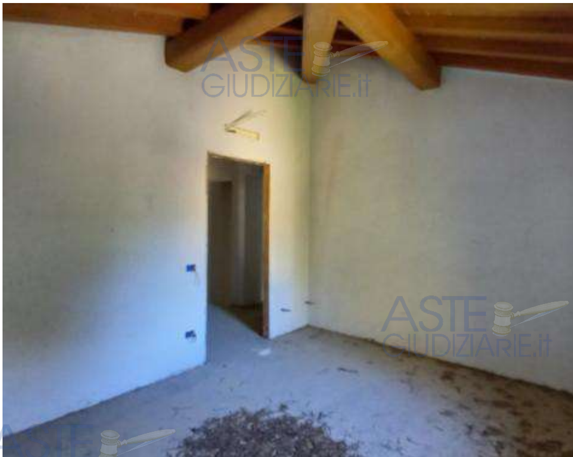
Foto 20 – locale piano primo
