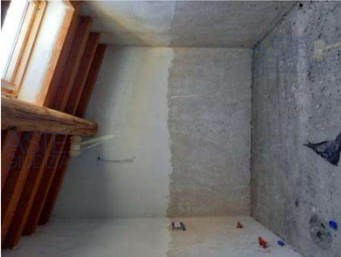
Foto 19 – locale posto al piano primo dotato di attacchi wc e finestra a tetto
