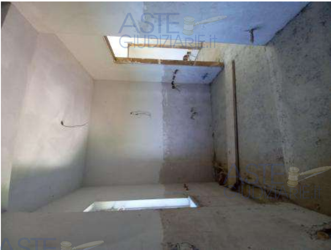
Foto 14 – locale posto al piano primo dotato di attacchi wc
