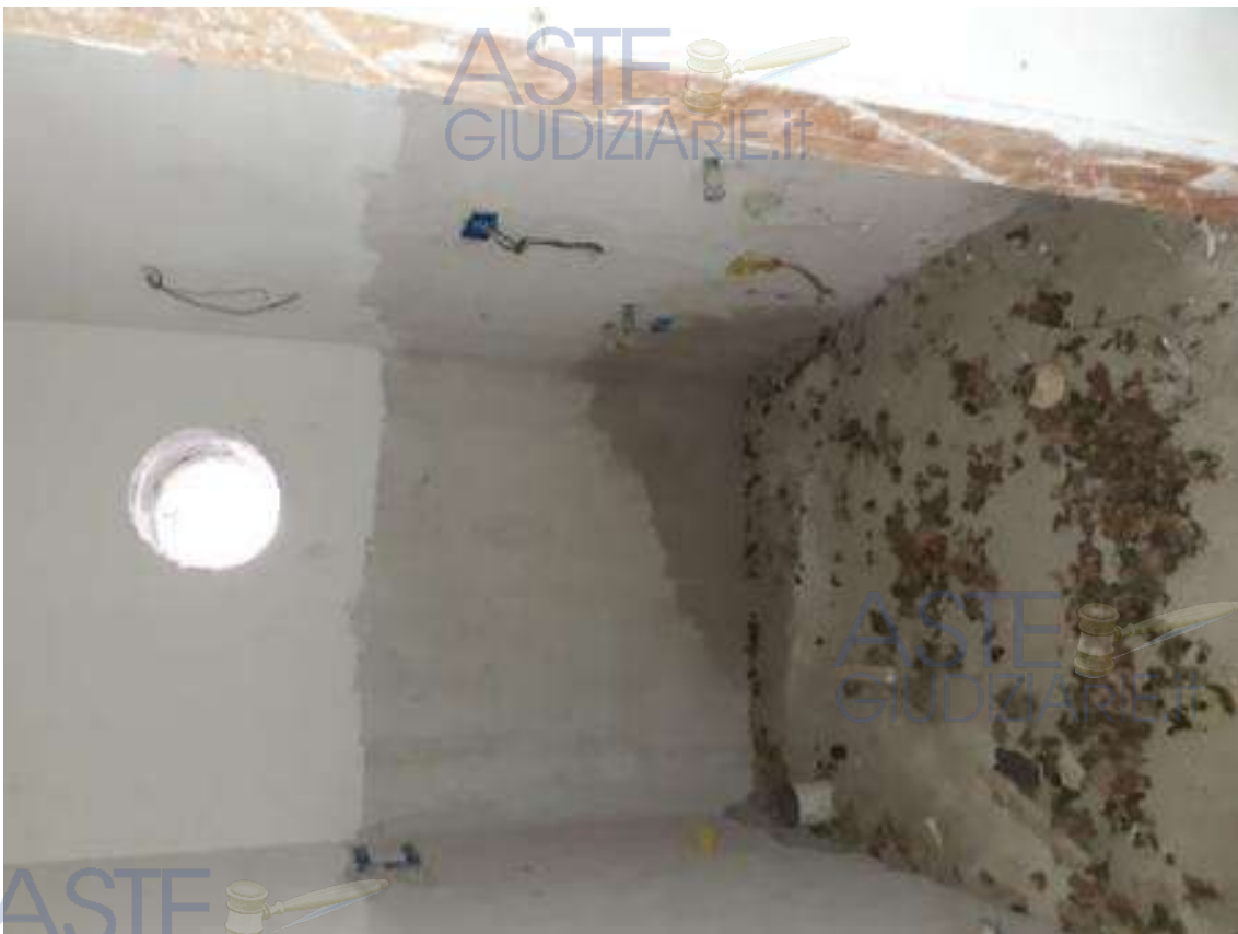
Foto 4 – locale con attacchi wc piano seminterrato
