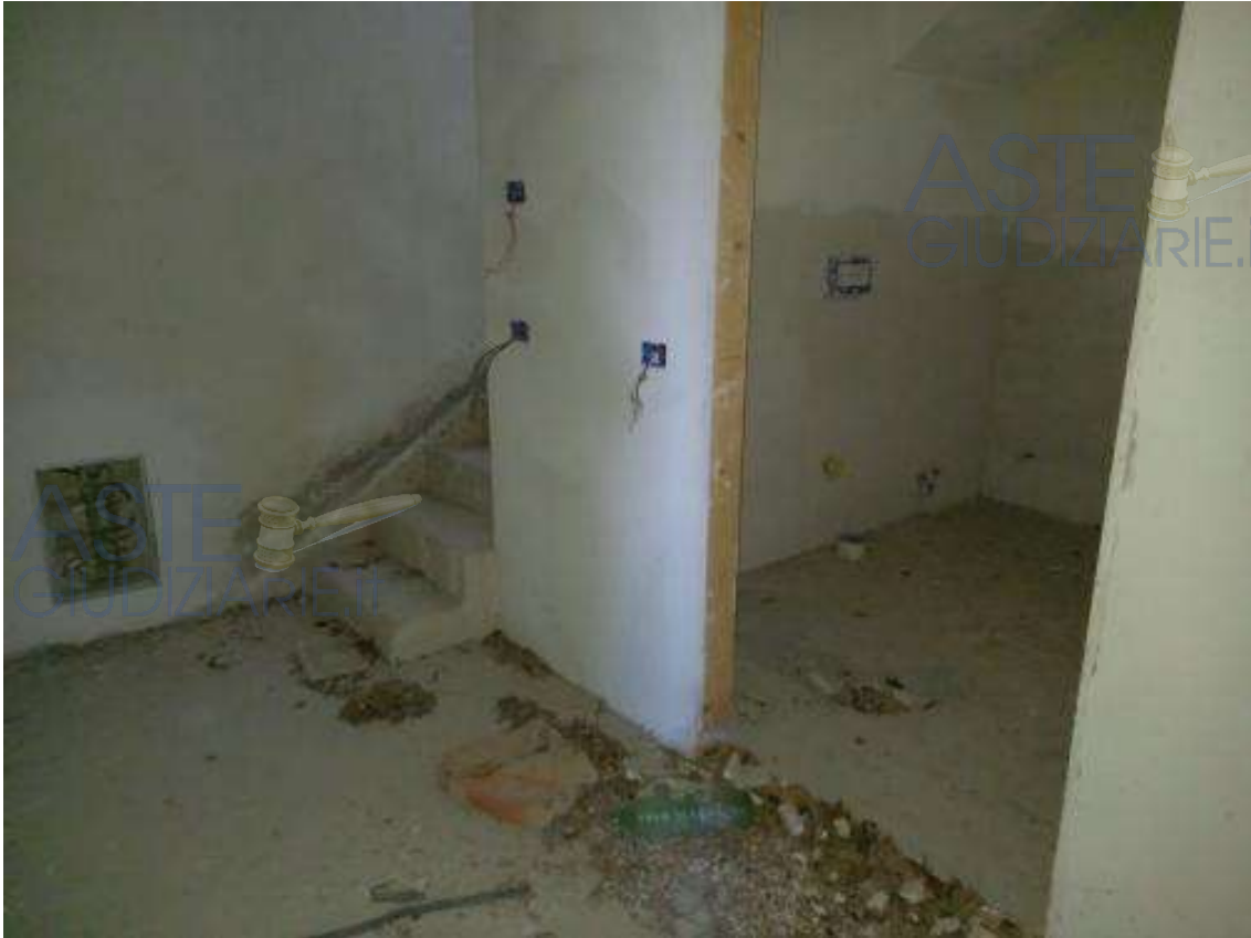
Foto 5 – locale con attacchi wc piano seminterrato
