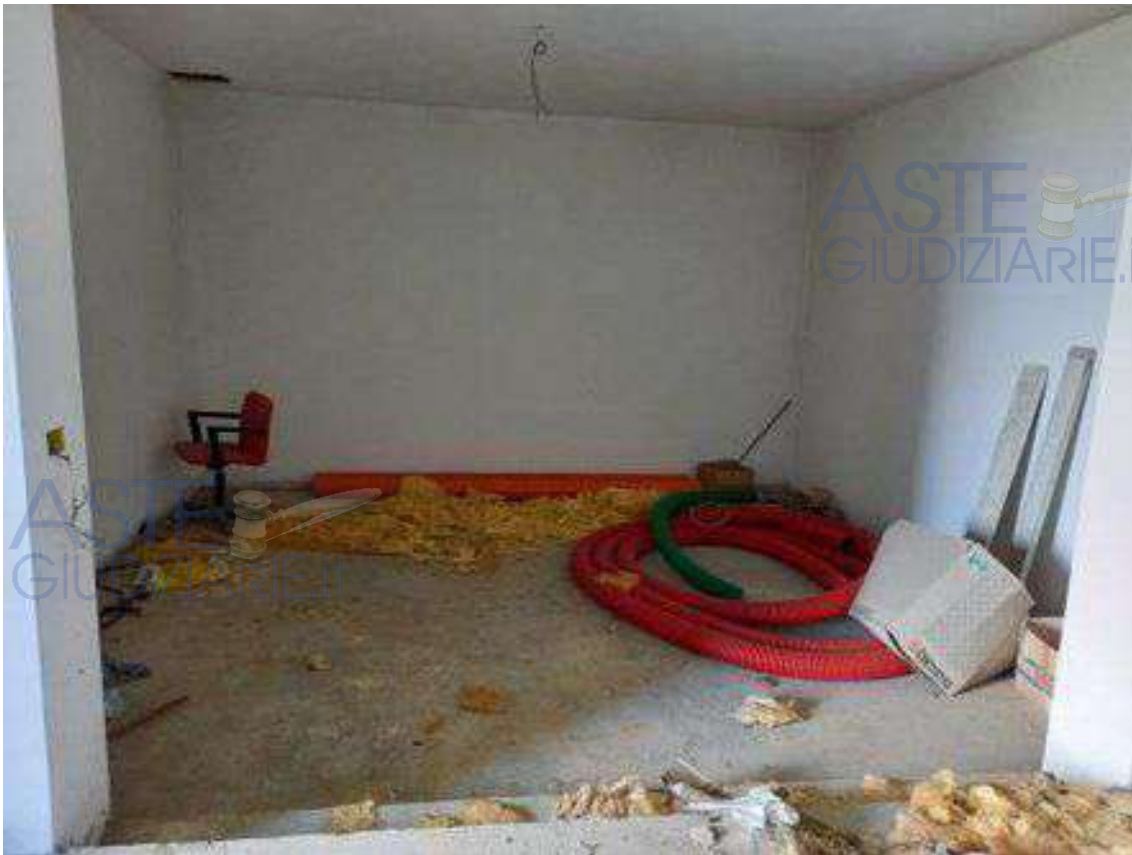
Foto 3- ampliamento piano terreno
