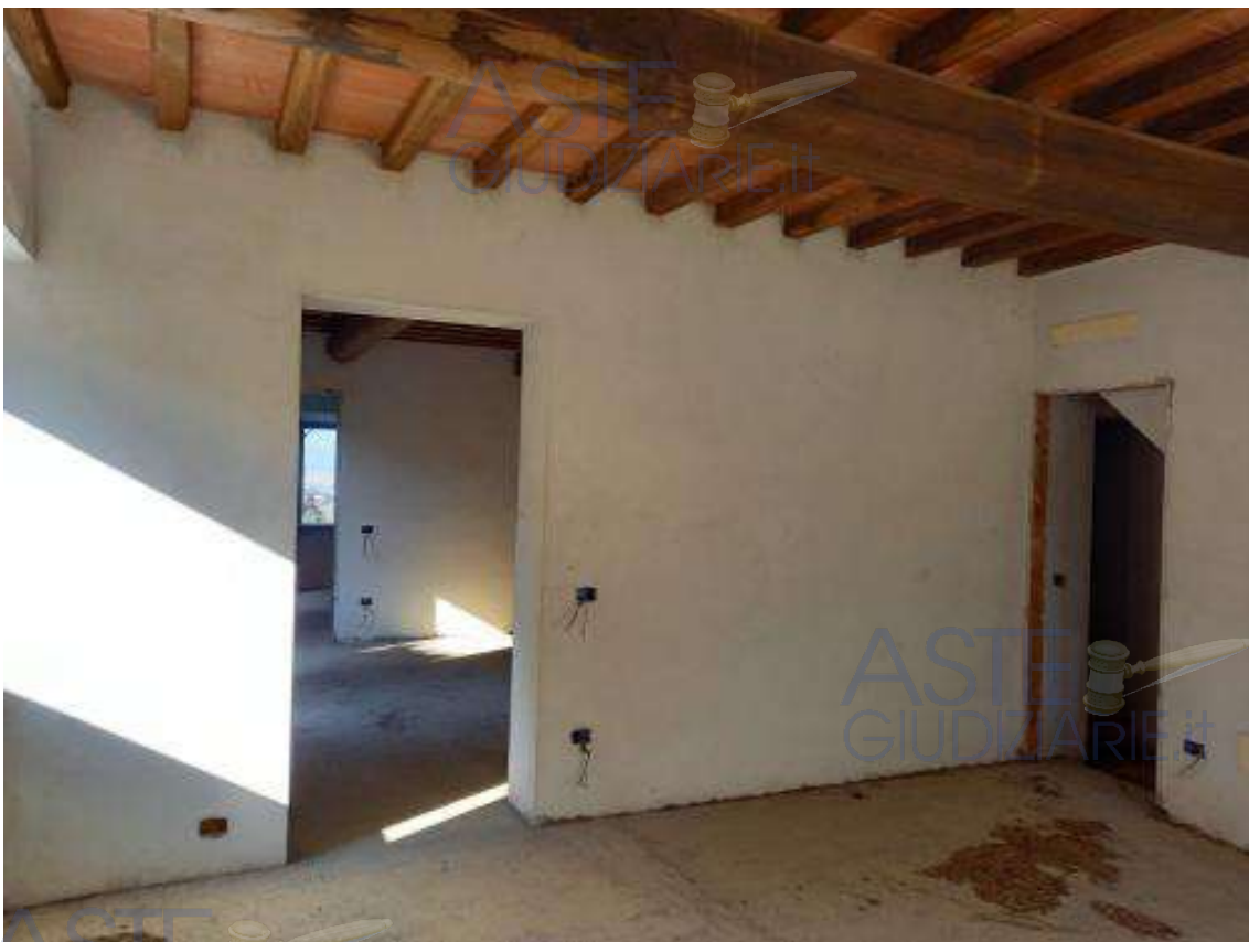
Foto 8 – locali interni piano terra
