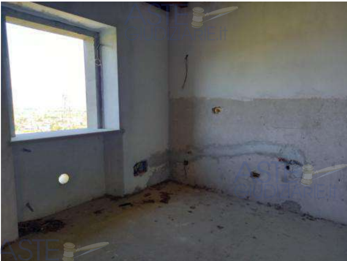
Foto 8 – locale con attacchi cucina piano terra
