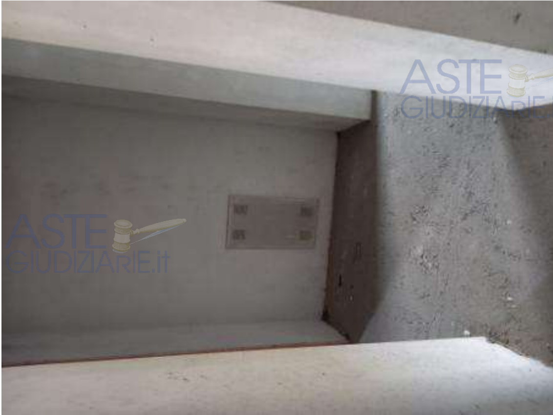
Foto 15 – suddivisione interna piano primo
