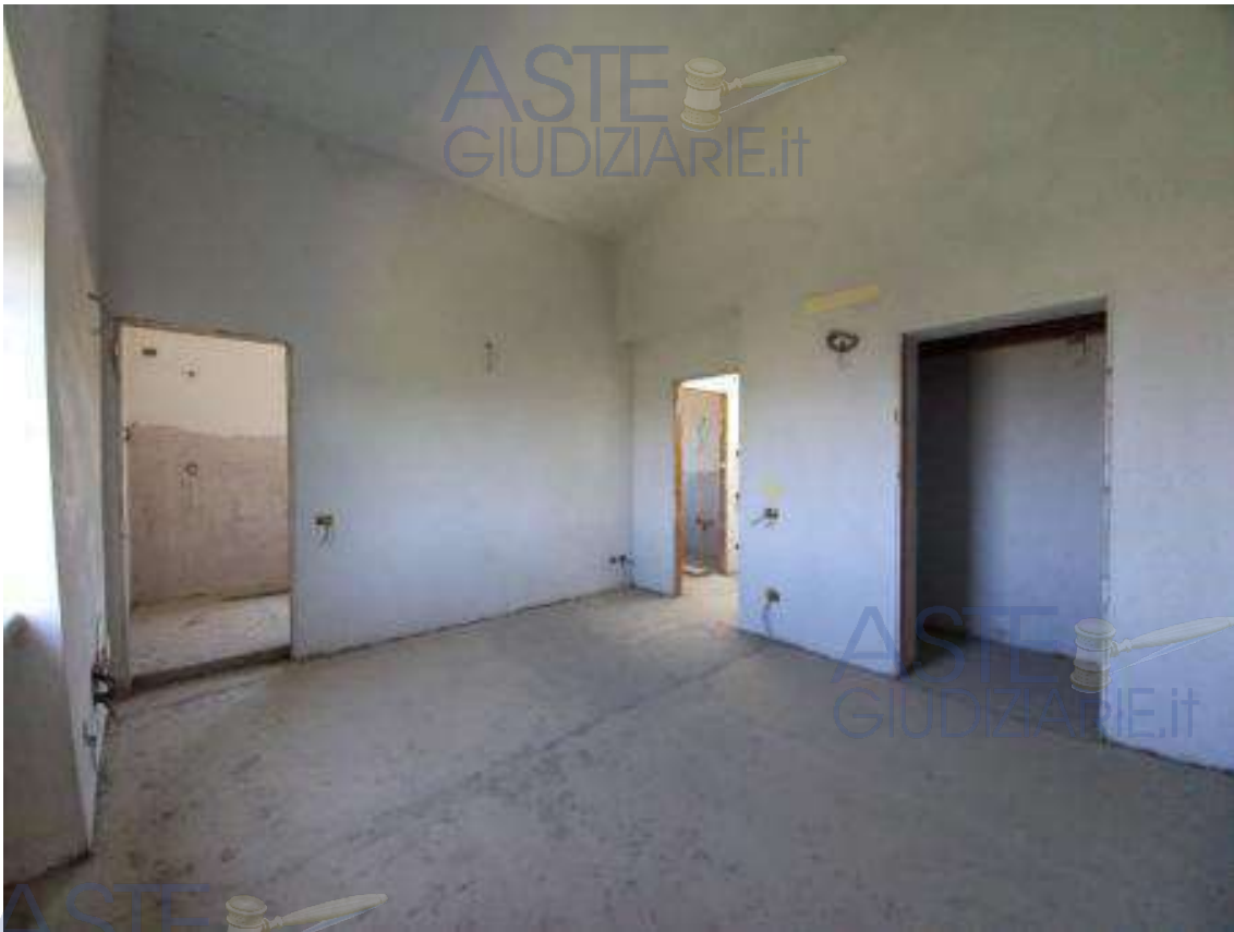
Foto 16 – locali piano primo
