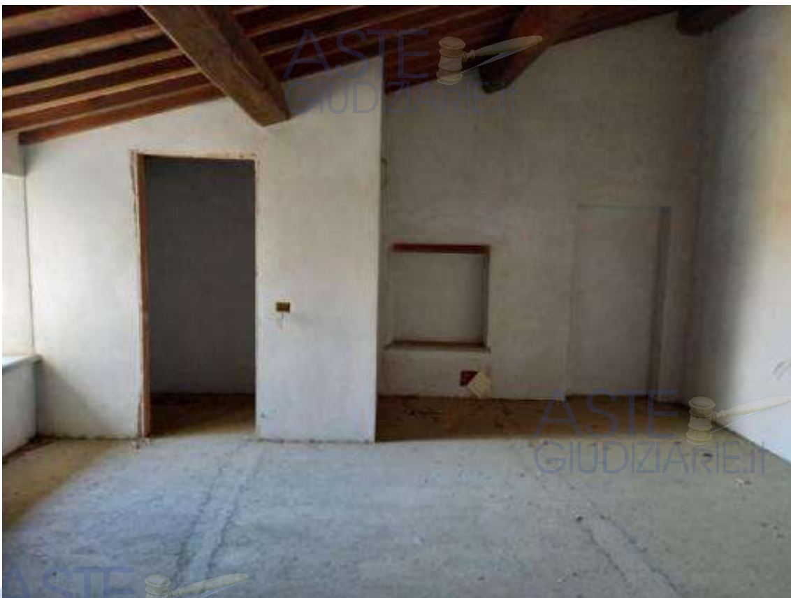
Foto 16 - suddivisione interna piano primo
