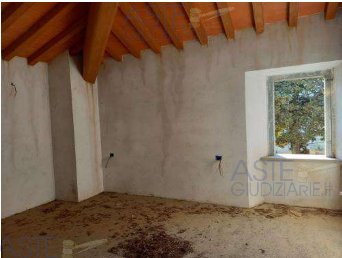
Foto 14 – locali piano primo
