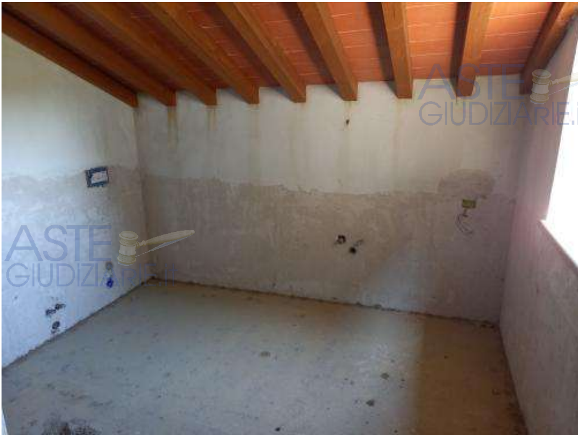
Foto17 – locale con attacchi wc piano primo
