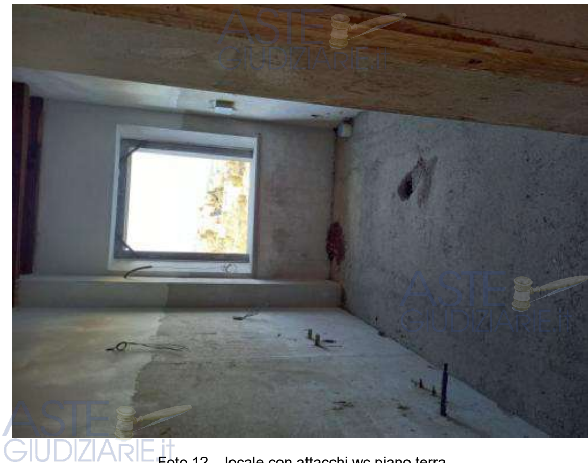
Foto 12 – locale con attacchi wc piano terra
