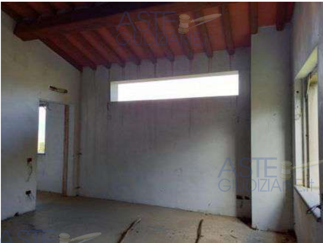
Foto 12 - Locale piano primo
