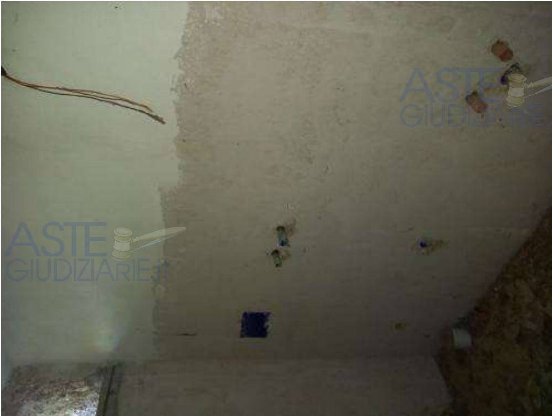
Foto 7 – locale con attacchi wc piano seminterrato
