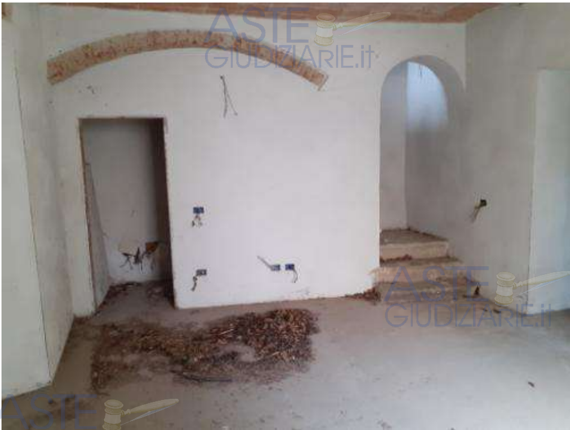
Foto 2 – locale centrale piano seminterrato
