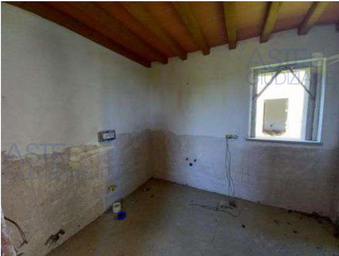
Foto 11 – locale con attacchi wc piano primo
