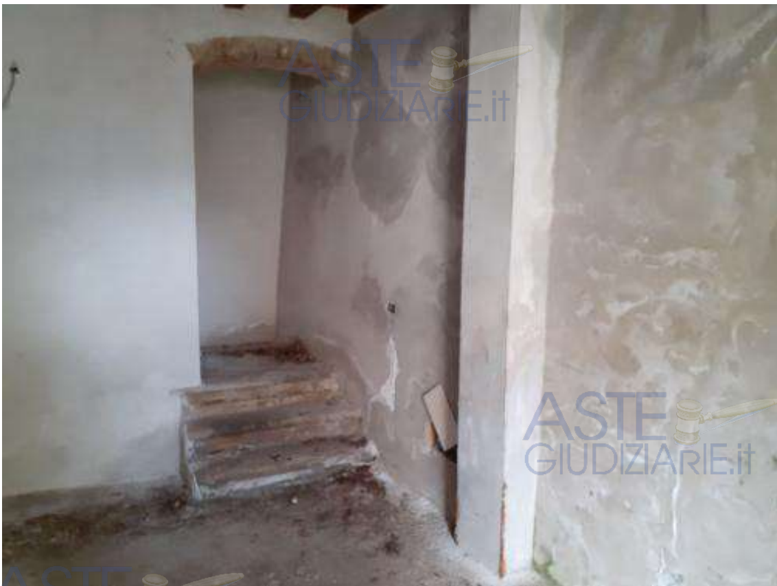
Foto 4 - arrivo scala interna locale piano seminterrato
