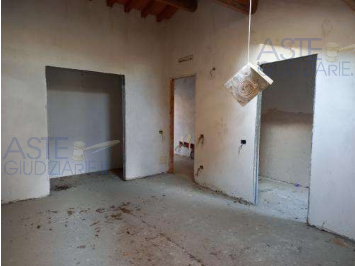
Foto 21 – suddivisione interna piano primo
