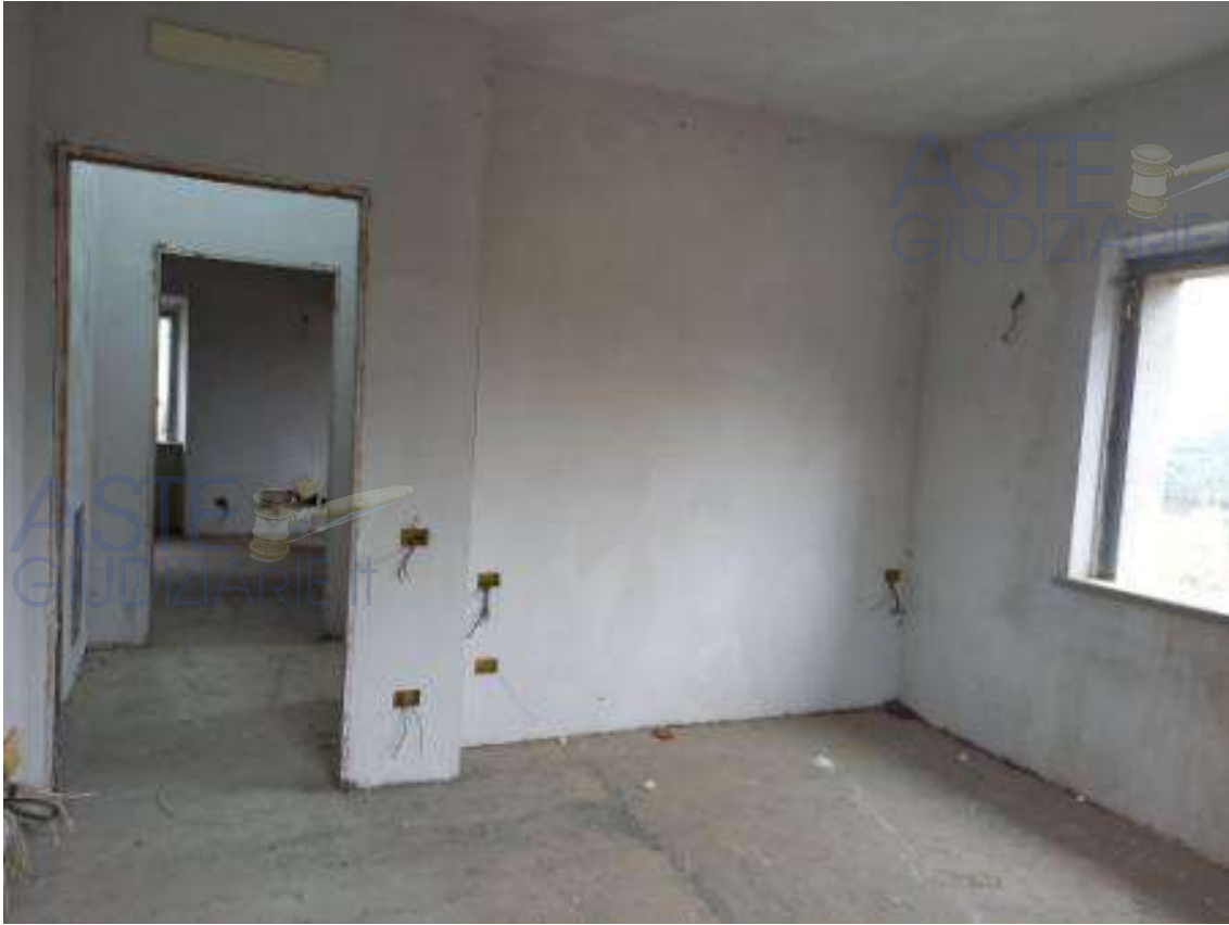
Foto 13 – locale piano primo
