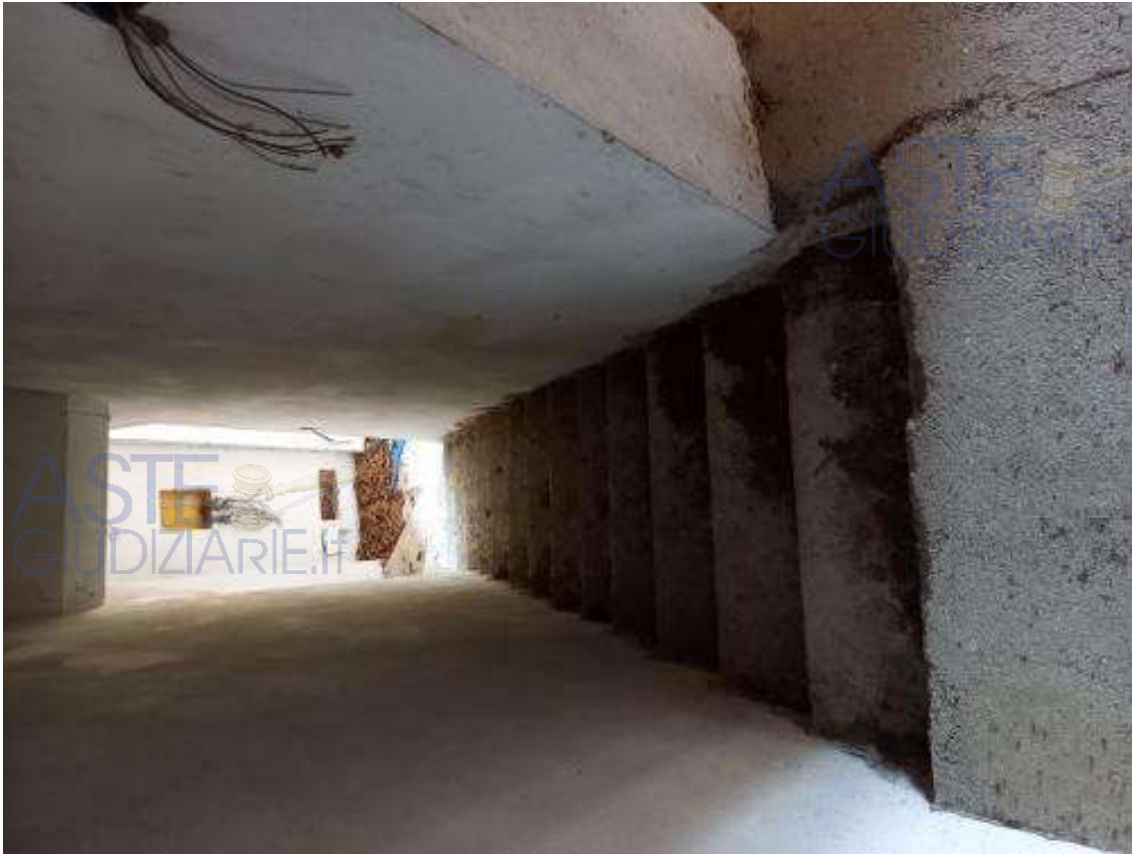
Foto 13 – sbarco scala interna di collegamento piano terra a piano primo
