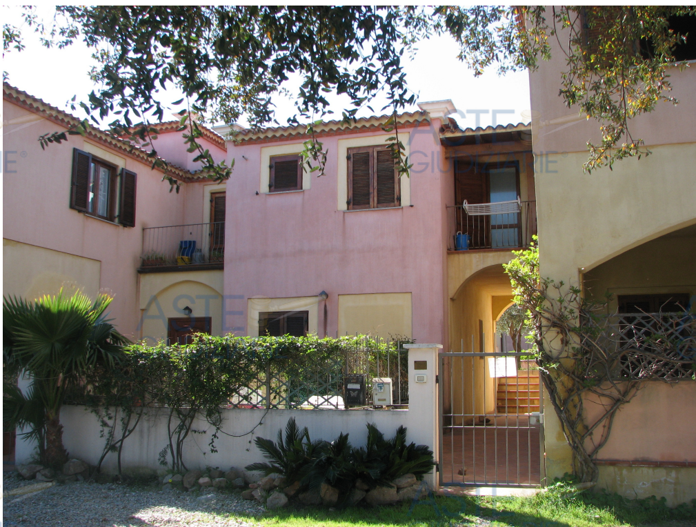
Vista esterna dell'immobile.
