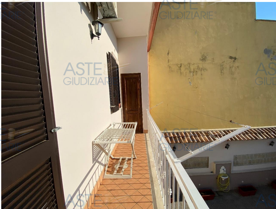
Balcone 2/terrazzo piano primo sub. 4 - lotto 2-
