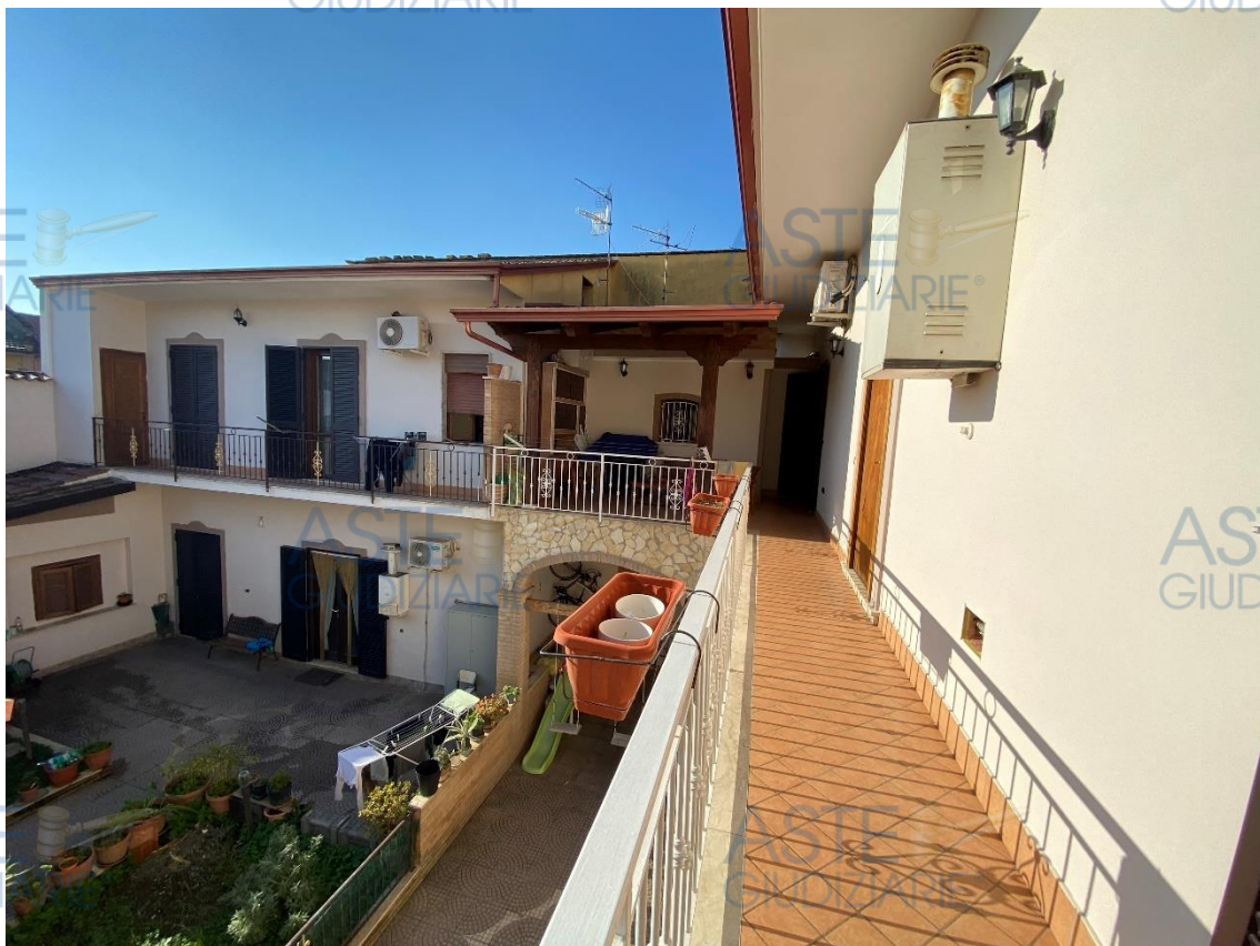
Balcone 2/ terrazzo piano primo sub. 4 lotto 2
