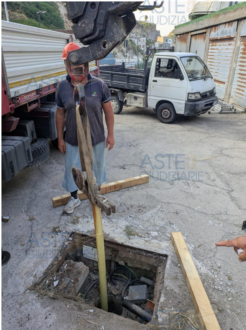
Foto 2 - Procedura di rimozione tubazione
