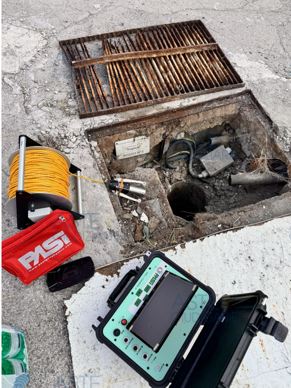
Foto 8 – Strumentazione per Video ispezione in pozzo
