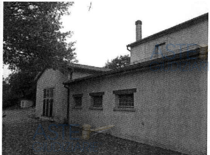
Foto n. 12 – Fabbricato ricadente sulla part. 138 – vista esterna
