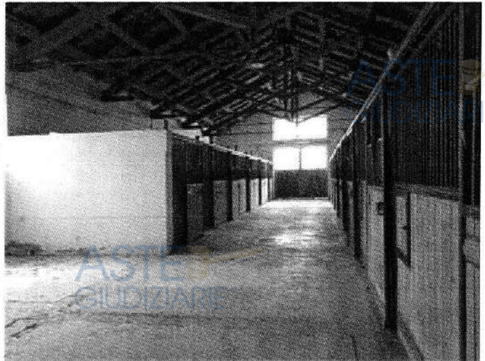
Foto n. 86 – Fabbricato ricadente sulla part. 132 – piano terra
