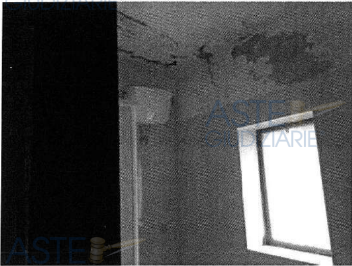
Foto n. 39 - Fabbricato ricadente sulla part. 138 - piano terra
