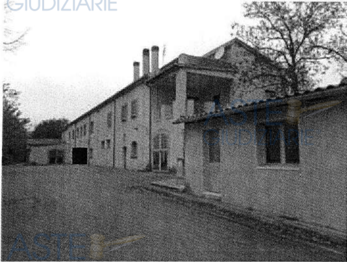
Foto n. 9 – Fabbricato ricadente sulla part. 138 – vista esterna
