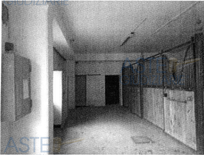
Foto n. 33 – Fabbricato ricadente sulla part. 138 – piano terra
