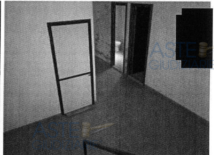
Foto n. 36 – Fabbricato ricadente sulla part. 138 – piano terra
