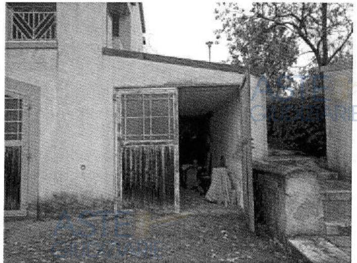
Foto n. 18 – Fabbricato ricadente sulla part. 138 – piano terra
