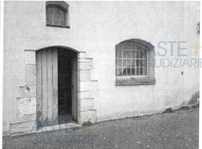
Foto n. 24 – Fabbricato ricadente sulla part. 138 – piano terra
