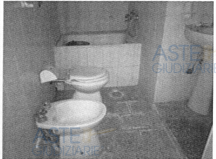
Foto n. 30 - Fabbricato ricadente sulla part. 138 - piano terra
