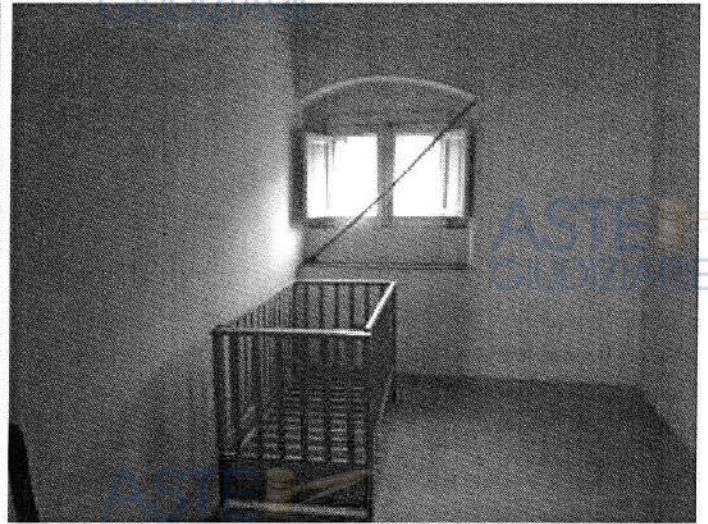
Foto n. 28 - Fabbricato ricadente sulla part. 138 - piano terra
