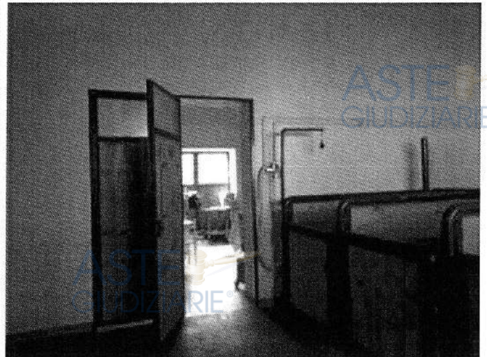
Foto n. 44 - Fabbricato ricadente sulla part. 138 - piano terra
