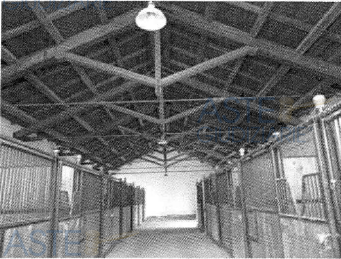
Foto n. 87 – Fabbricato ricadente sulla part. 132 – piano terra
