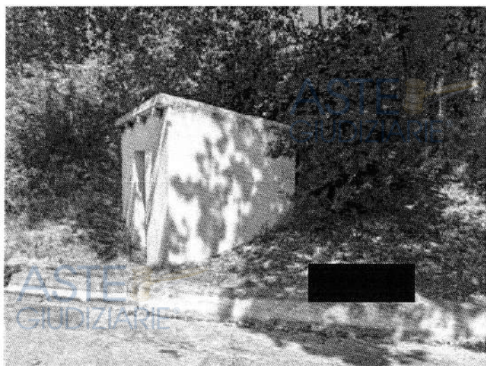
Foto n. 151 – Fabbricato ricadente sulla part. 110
