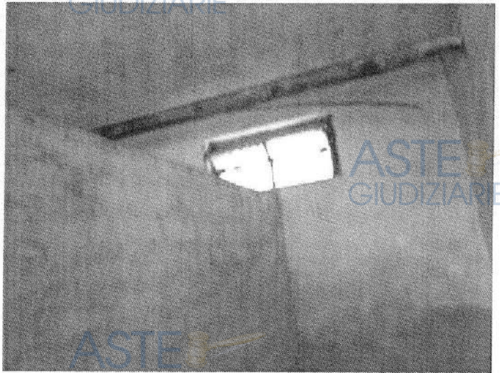
Foto n. 22 – Fabbricato ricadente sulla part. 138 – piano terra
