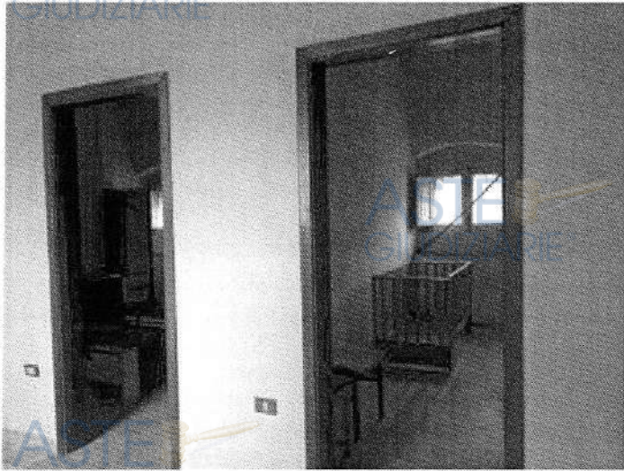
Foto n. 27 - Fabbricato ricadente sulla part. 138 - piano terra
