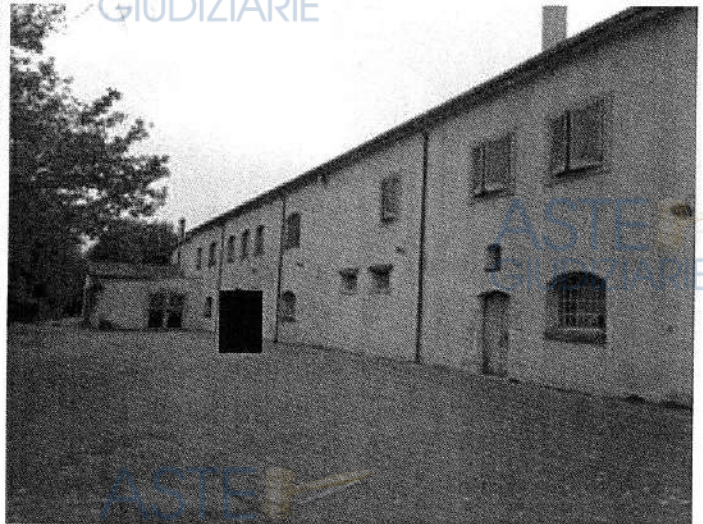
Foto n. 10 – Fabbricato ricadente sulla part. 138 – vista esterna
