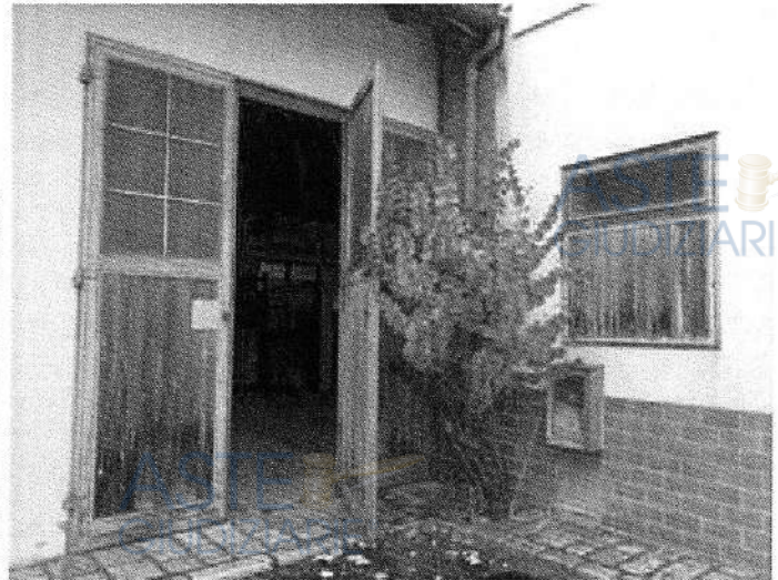
Foto n. 84 – Fabbricato ricadente sulla part. 132 – piano terra
