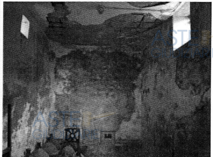
Foto n. 20 – Fabbricato ricadente sulla part. 138 – piano terra
