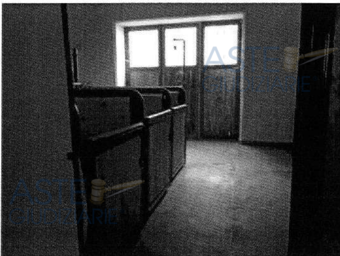
Foto n. 43 - Fabbricato ricadente sulla part. 138 - piano terra
