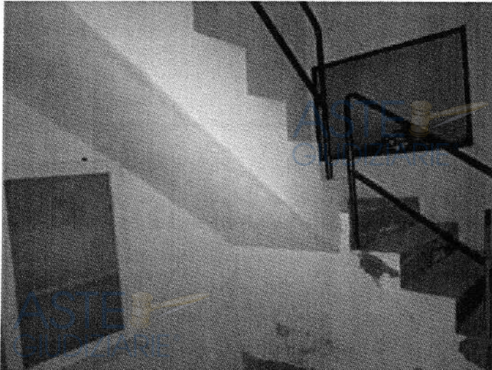
Foto n. 35 – Fabbricato ricadente sulla part. 138 – piano terra
