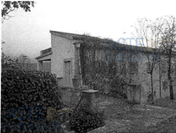
Foto n. 17 – Fabbricato ricadente sulla part. 138 – vista esterna
