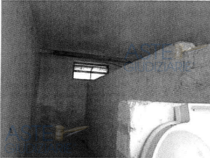
Foto n. 23 – Fabbricato ricadente sulla part. 138 – piano terra
