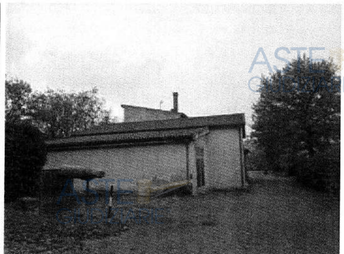
Foto n. 14 – Fabbricato ricadente sulla part. 138 – vista esterna
