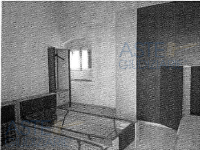
Foto n. 29 - Fabbricato ricadente sulla part. 138 - piano terra
