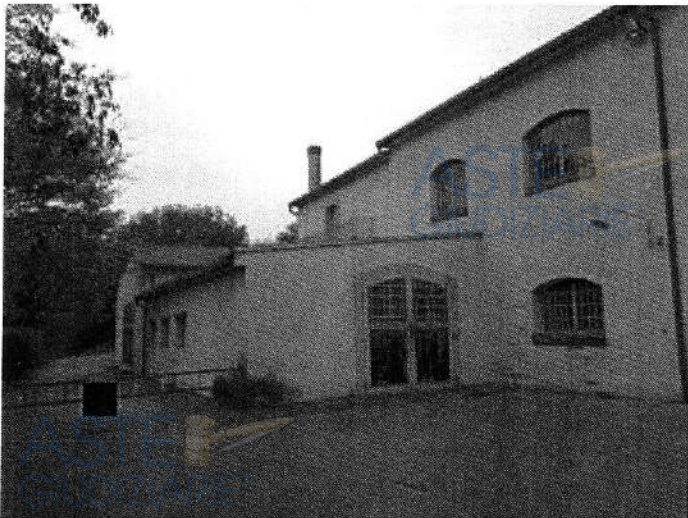
Foto n. 11 – Fabbricato ricadente sulla part. 138 – vista esterna
