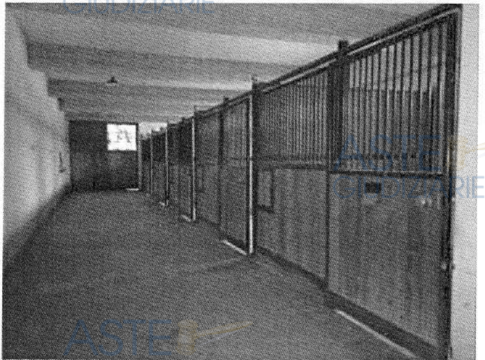
Foto n. 88 – Fabbricato ricadente sulla part. 132 – piano terra
