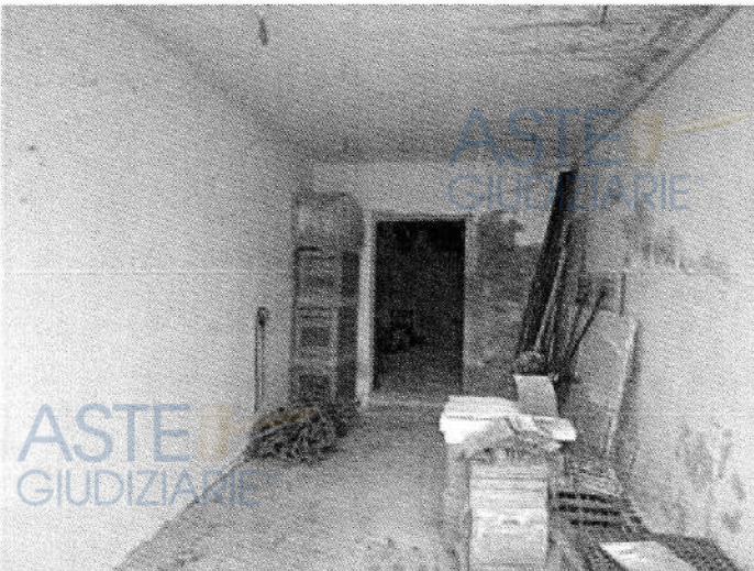
Foto n. 19 – Fabbricato ricadente sulla part. 138 – piano terra
