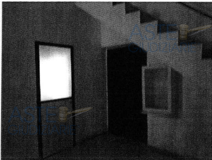
Foto n. 37 – Fabbricato ricadente sulla part. 138 – piano terra
