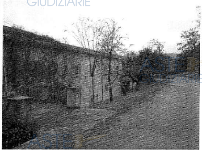
Foto n. 16 – Fabbricato ricadente sulla part. 138 – vista esterna
