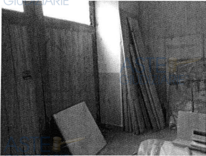
Foto n. 45 – Fabbricato ricadente sulla part. 138 – piano terra
