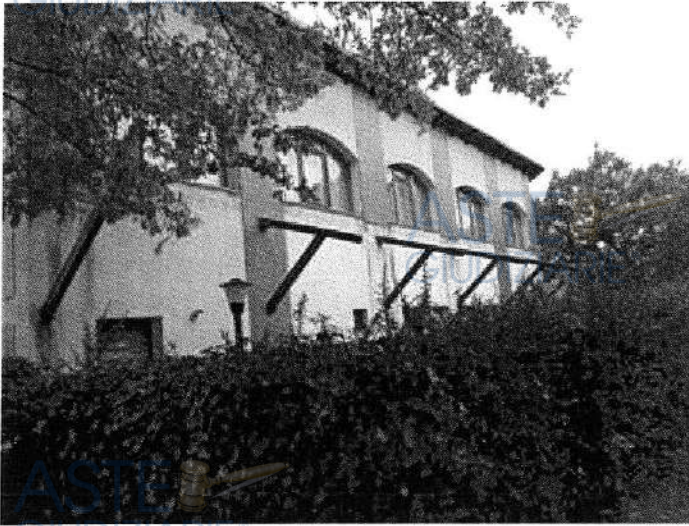
Foto n. 81 – F Fabbricato ricadente sulla part. 132
