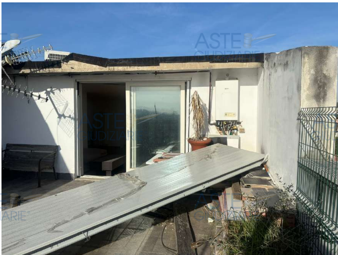
Foto 46 Terrazzo Foglio 10 - Part.896 - Sub.19 Piano quarto
