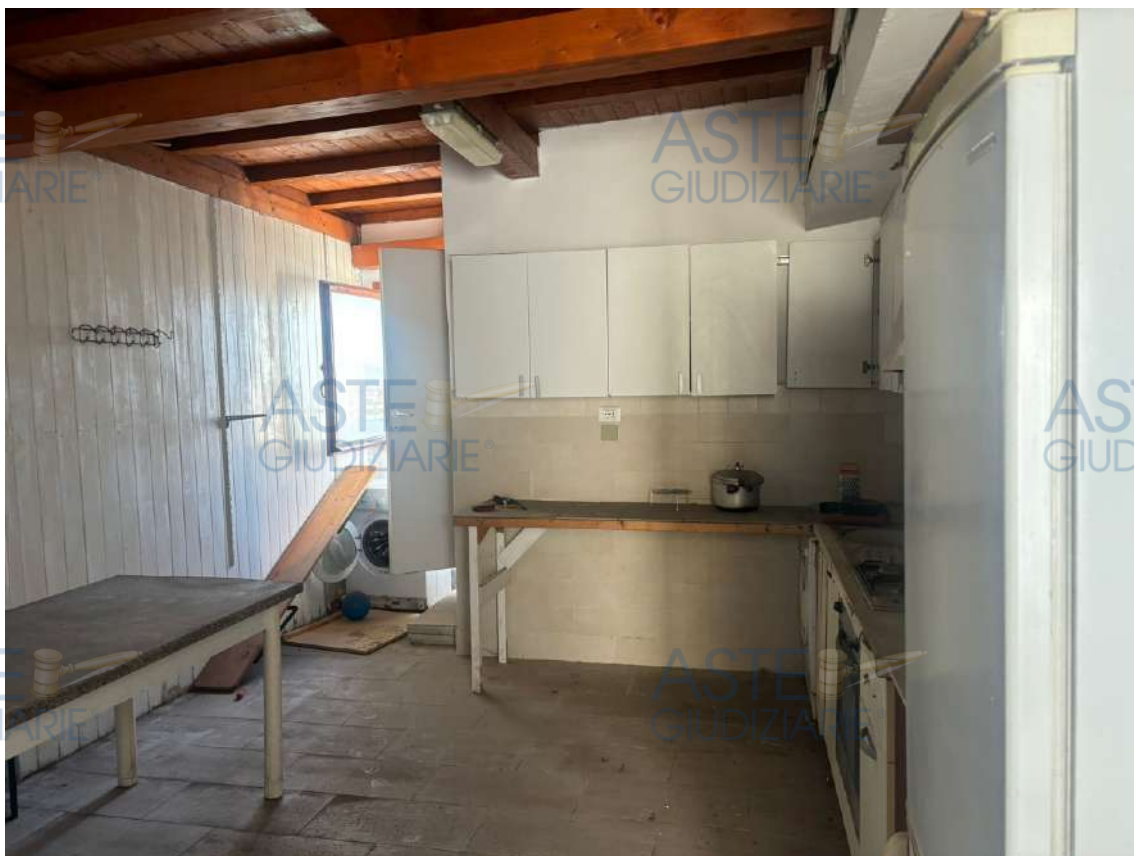
Foto 58 Chiusura balcone Foglio 10 – Part.896 - Sub.19 Piano quarto
