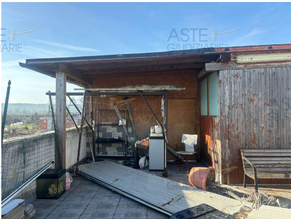
Foto 44 Terrazzo Foglio 10 - Part.896 - Sub.19 Piano quarto
