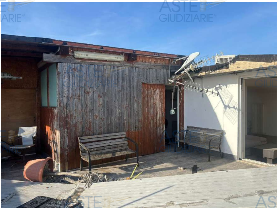
Foto 47 Terrazzo Foglio 10 - Part.896 - Sub.19 Piano quarto
