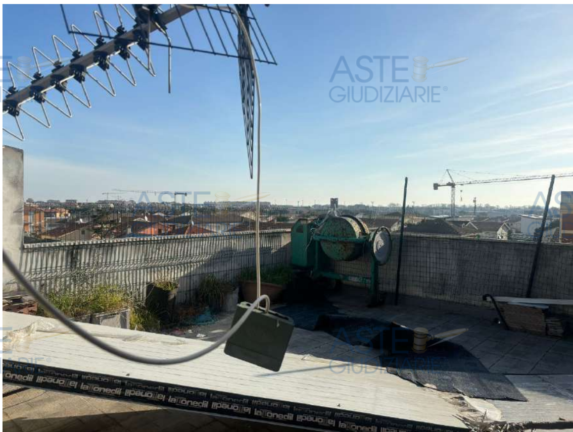
Foto 48 Terrazzo Foglio 10 - Part.896 - Sub.19 Piano quarto
