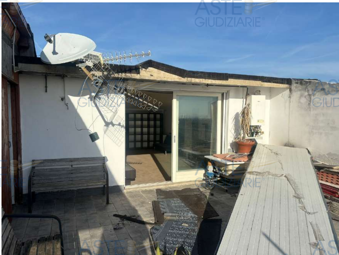
Foto 45 Terrazzo Foglio 10 - Part.896 - Sub.19 Piano quarto
