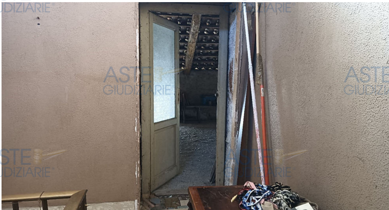
foto n° 17- Bene 13 (piano sottotetto) ingresso dal vano scala
