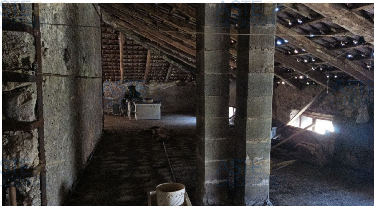
foto n° 20- Bene 13 (piano sottotetto)
