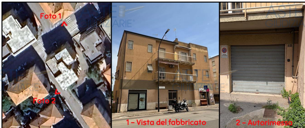
Accesso immobili: ortofoto e vista fabbricato da Nord (accesso vano scala) e da Sud-Ovest (autorimessa)
