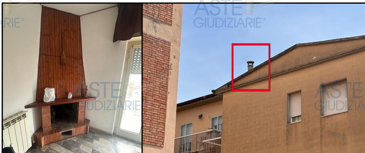
Impianto riscaldamento: camino a legna
