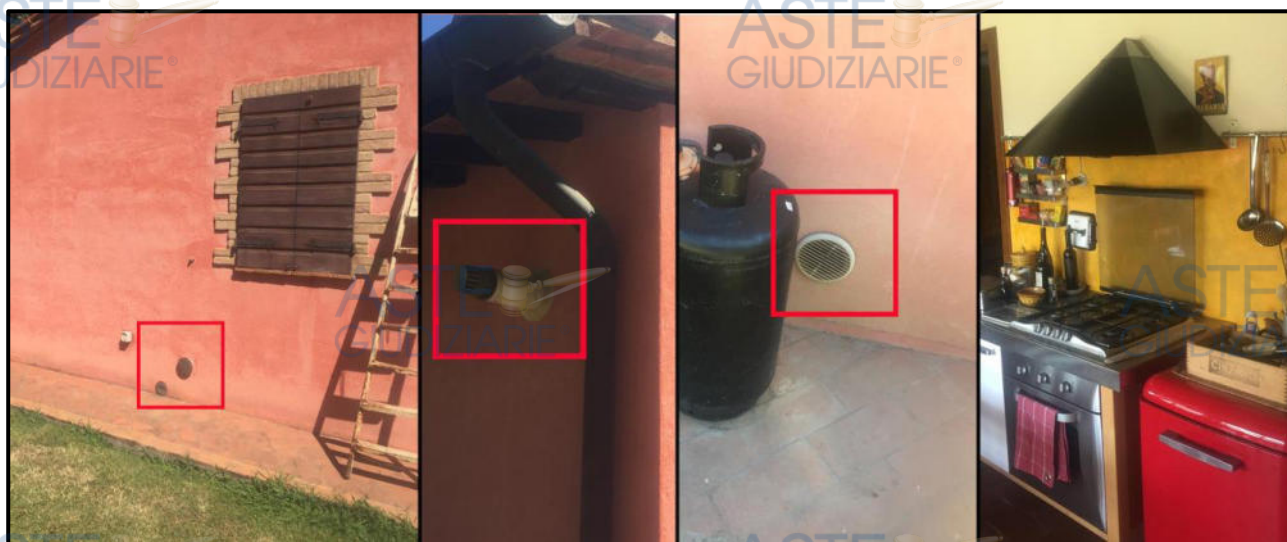
Impianto gas: espulsione fumi ed areazione locali
