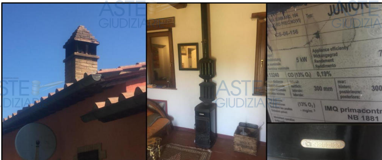
Impianto riscaldamento: stufa a legna con espulsione fumi.
