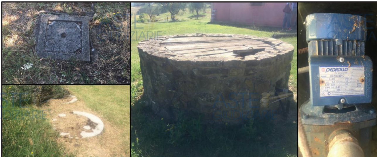
Impianto idrico: pozzetto con contatore, fossa Imhoff, pozzo per irrigazione con elettropompa
