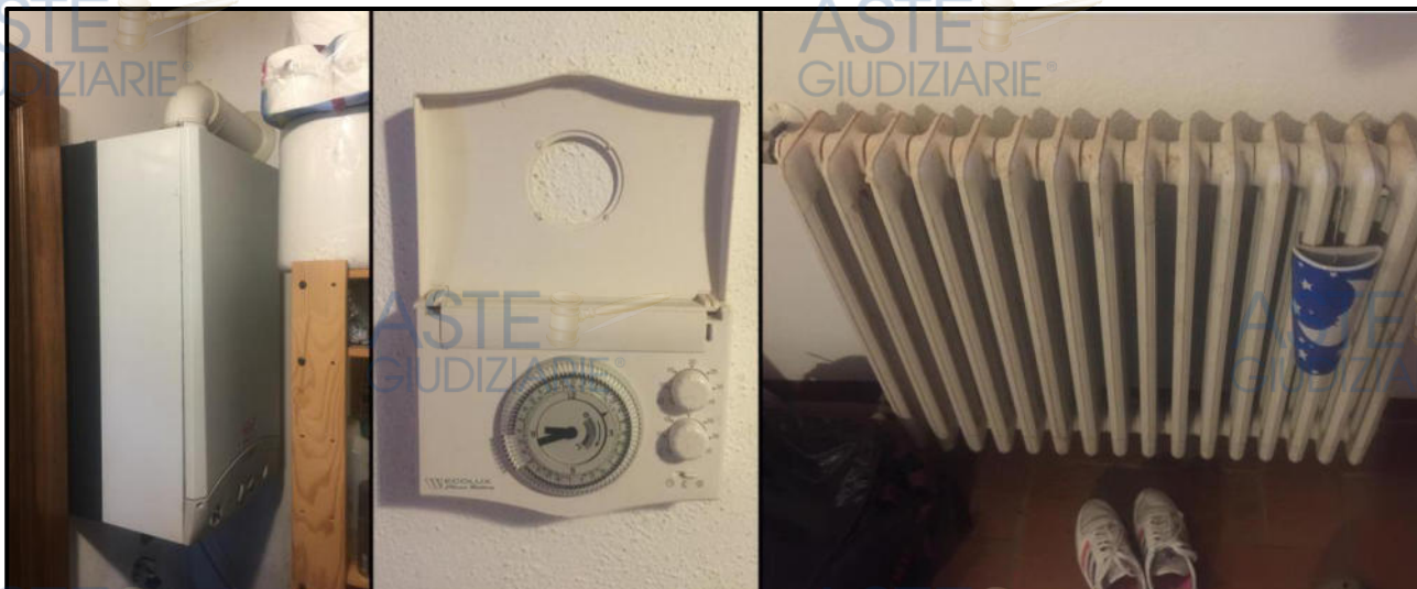
Impianto riscaldamento: caldaia, termostato, radiatore.
