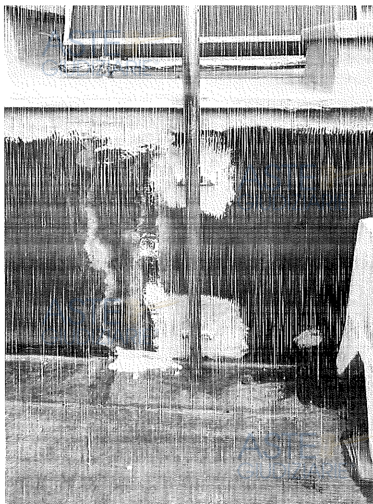
Punti critici impermeabilizzati
