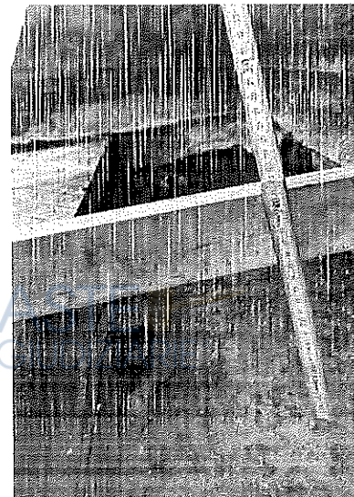
Foto 5 Spessore cm 15 del pacchetto di n. 3 strati isolanti e n. 2 pavimenti
