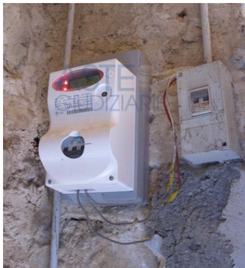
Fig. 22 e 23 – Collocazione contatore Enel e particolare interruttore magnetotermico
