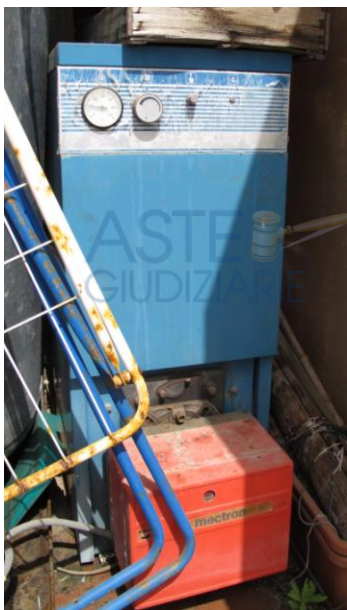
Fig. 13 e 14 – La caldaia e lo scaldacqua elettrico
