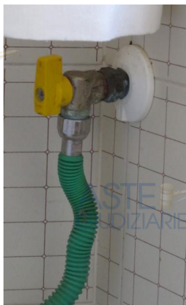
Fig. 20 e 21 – Rubinetto d'intercettazione gpl e collocazione contatore
