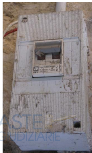
Fig. 22 e 23 – Collocazione contatore Enel e particolare interruttore magnetotermico
