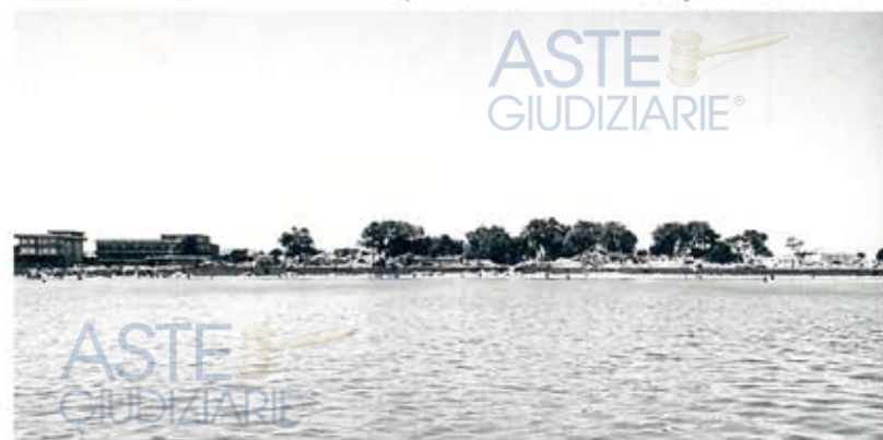
Colonia pavese a Igea Marina: 1984, dopo la totale demolizione (foto Claudio Fabbri)
