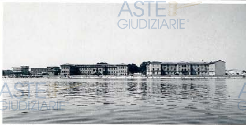
Colonia pavese a Igea Marina: il corpo centrale di collegamento è stato demolito.
