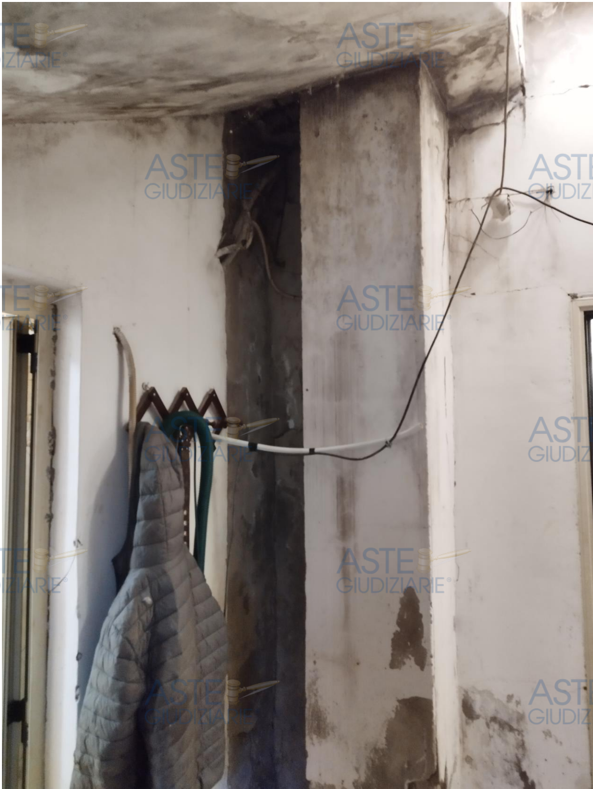
Foto 19: zona retrostante – lesioni e umidità pilastro scala esterna
