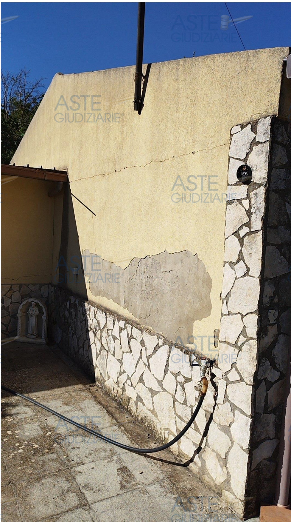
Foto 34: garage/magazzino – facciata esterna
