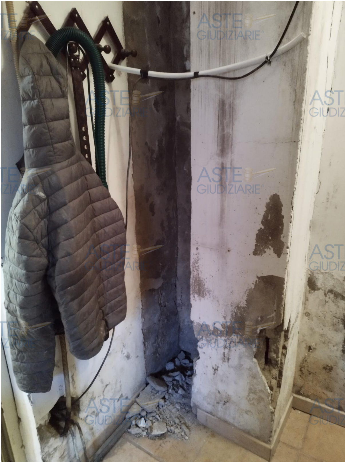
Foto 18: zona retrostante – distacco copriferro e lesioni pilastro scala esterna
