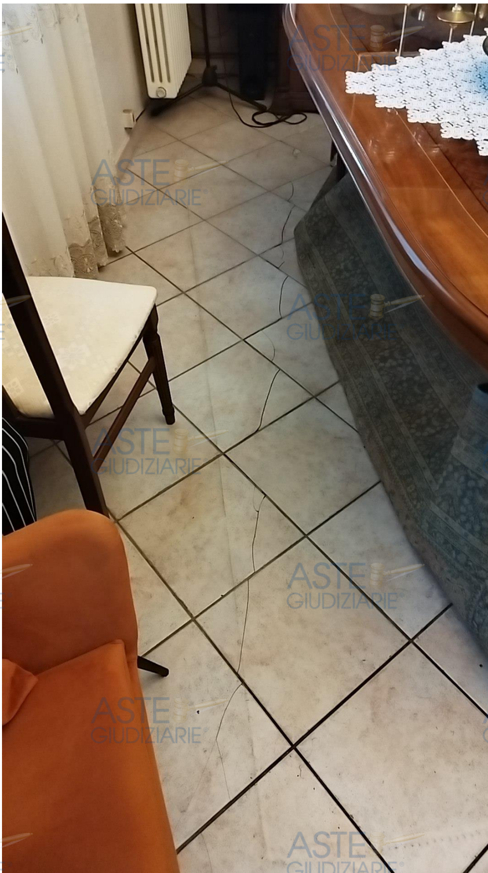
Foto 5: lesioni nella pavimentazione
