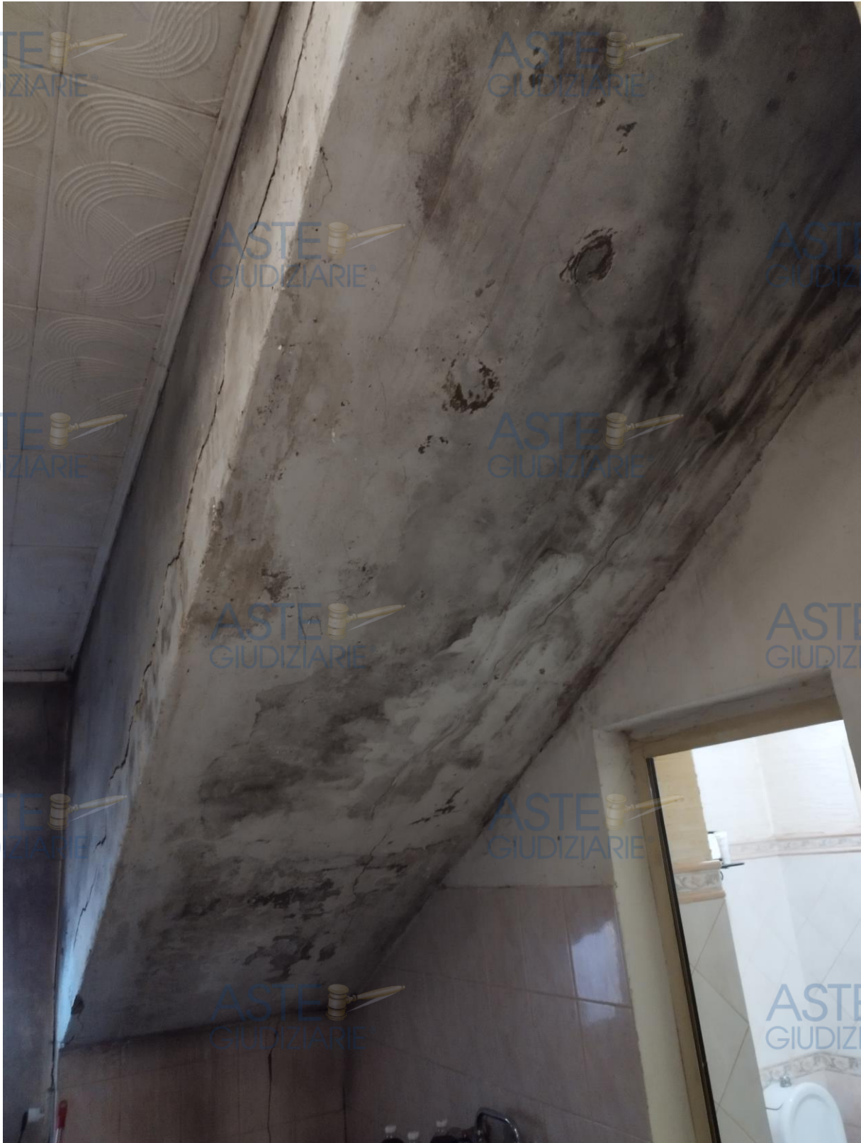
Foto 22: zona retrostante – lesioni e umidità rampa scala esterna
