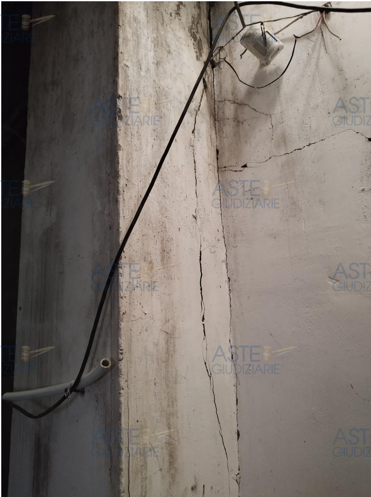
Foto 21: zona retrostante – lesioni e umidità pilastro scala esterna
