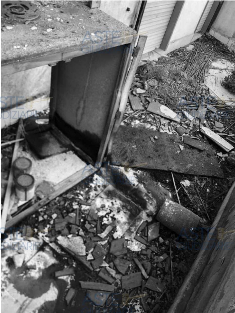
L16-FO-6 – Balcone salone - danni da infiltrazioni idriche per rottura tubazione idraulica
