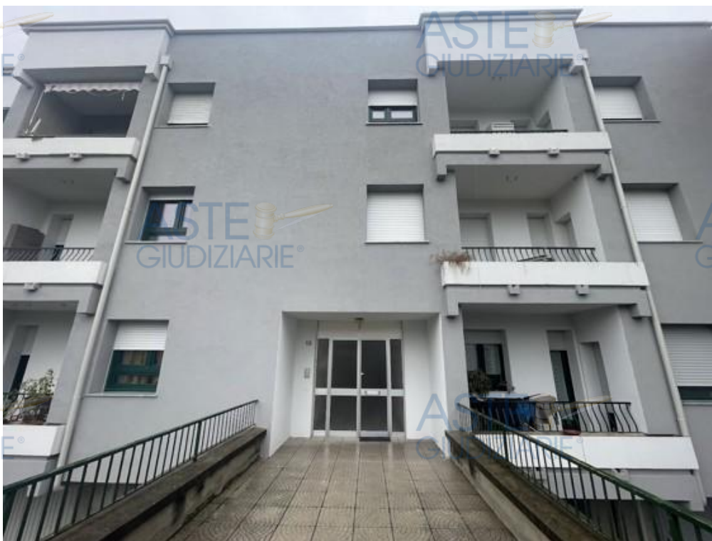
Fotografia A.7 - ZONA INGRESSO CONDOMINIALE CIVICO 13
