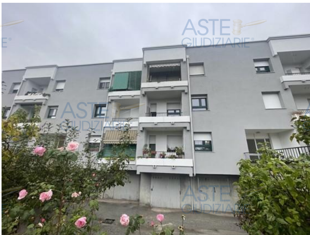
Fotografia A.6 - VISTA PROSPETTO CONDOMINIALE - ZONA OVE E' UBICATO L'APPARTAMENTO OGGETTO DI STIMA
