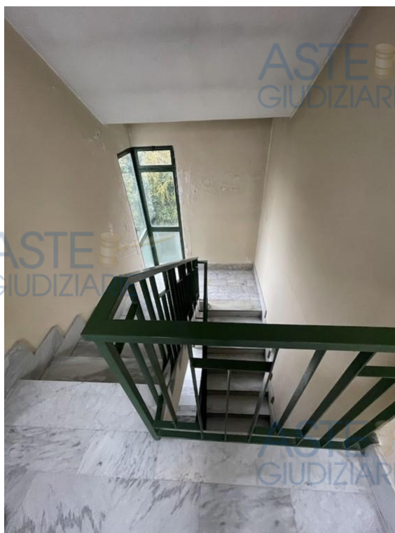
Fotografia A.10 - VANO SCALA CONDOMINIALE
