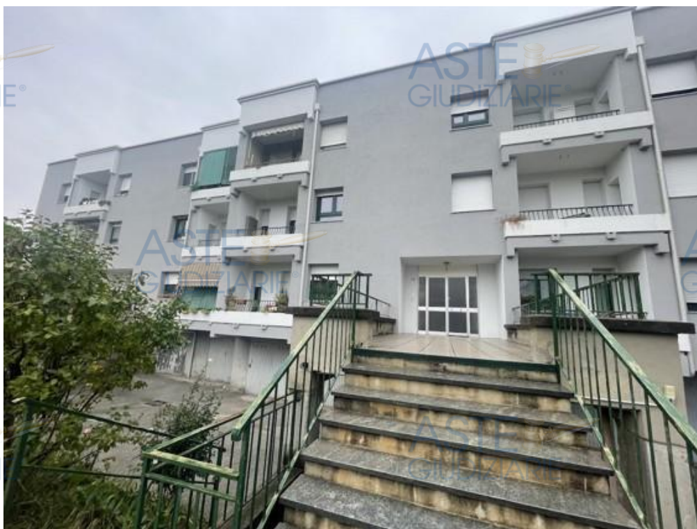
Fotografia A.4 - SCALA DI ACCESSO PIANEROTTOLO AL CIVICO 13
