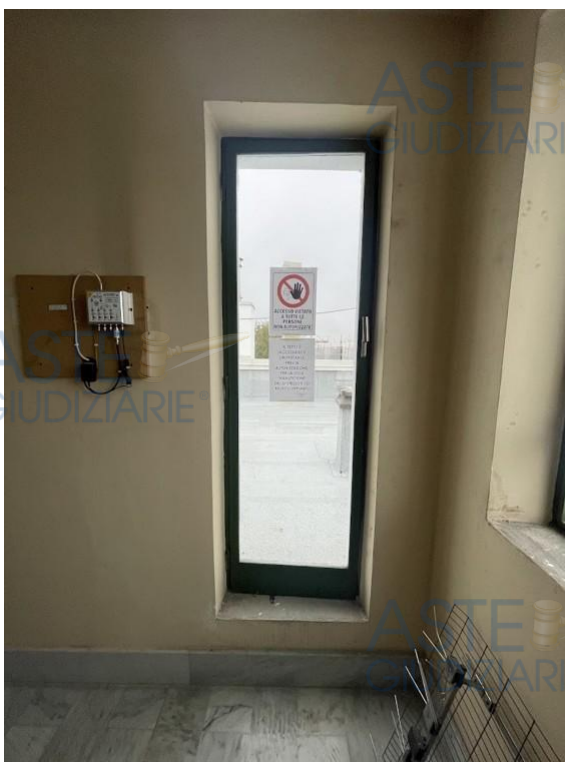
Fotografia A.34 - PORTAFINESTRA DI ACCESSO AL TETTO (TERRAZZAMENTO/LASTRICO SOLARE)
