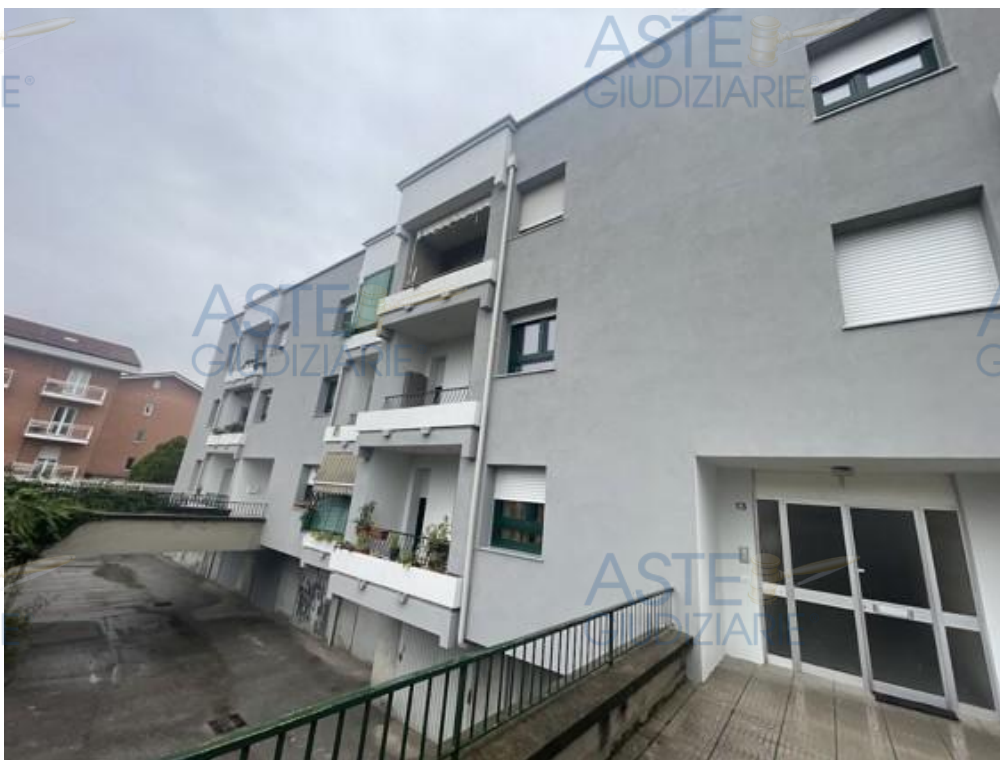
Fotografia A.5 - VISTE ESTERNE ZONA ACCESSO CONDOMINIALE CIVICO 13
