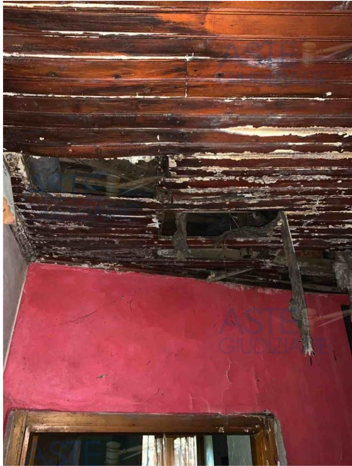
Particolare con infiltrazioni dal tetto nel disimpegno al P.1
