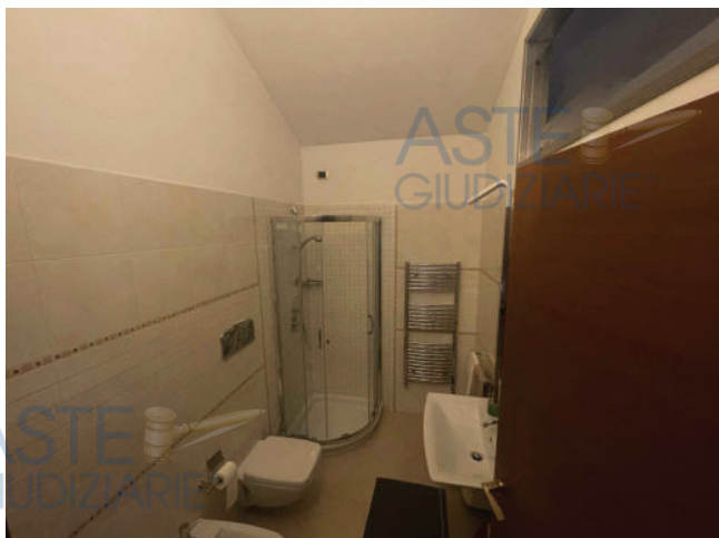
Foto 3 - Realizzazione nuovo bagno
