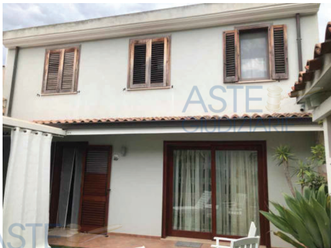
Foto 1 - Difficoltà bucatore da C.E.633 / 2004 Vista Esterna
