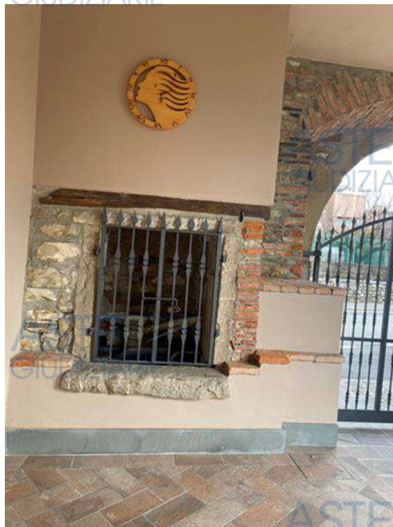
Pozzo chiuso con inferriata per motivi di sicurezza
