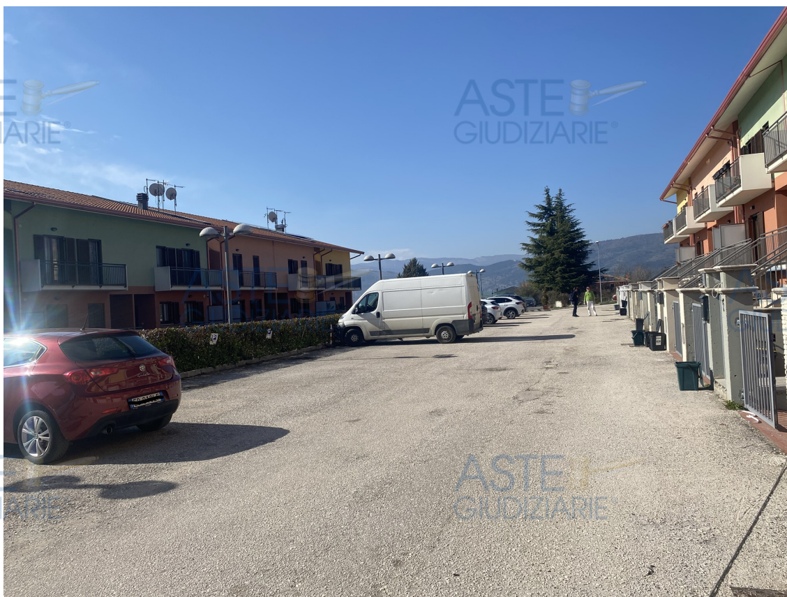
Foto 1: Vista d'insieme della p.la 2490 destinata a Viabilità Interna a servizio dei posti auto e degli accessi alle abitazioni.
