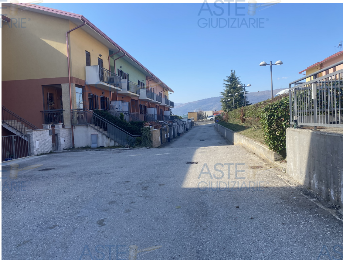
Foto 2: Vista d'insieme della p.la 2490 destinata a Viabilità Interna a servizio dei posti auto e degli accessi alle abitazioni.
