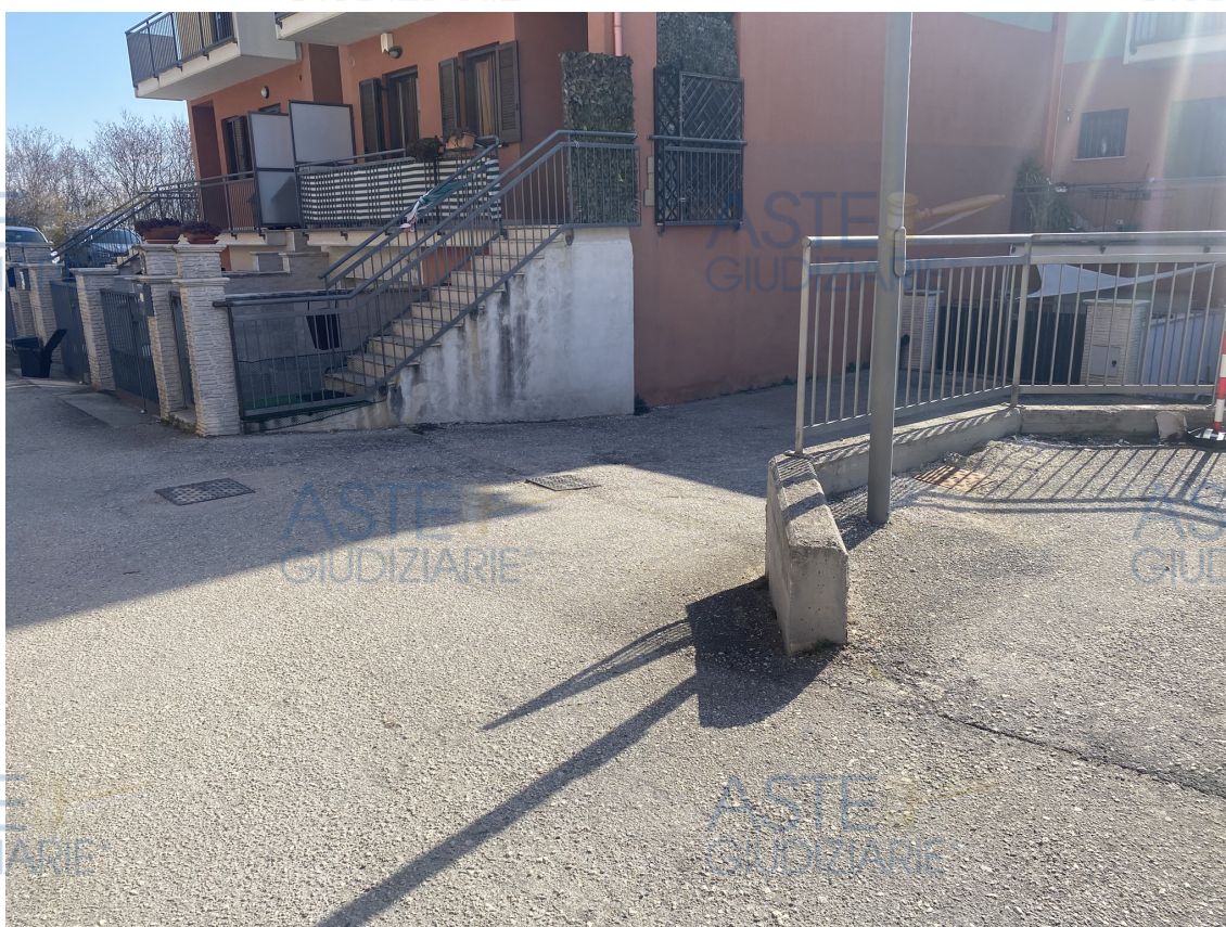
Foto 5: Vista d'insieme della p.lla 2489 destinata a viabilità interna.
