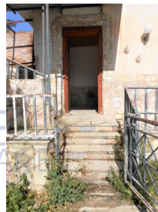
4. Il portoncino d'ingresso dalla corte
