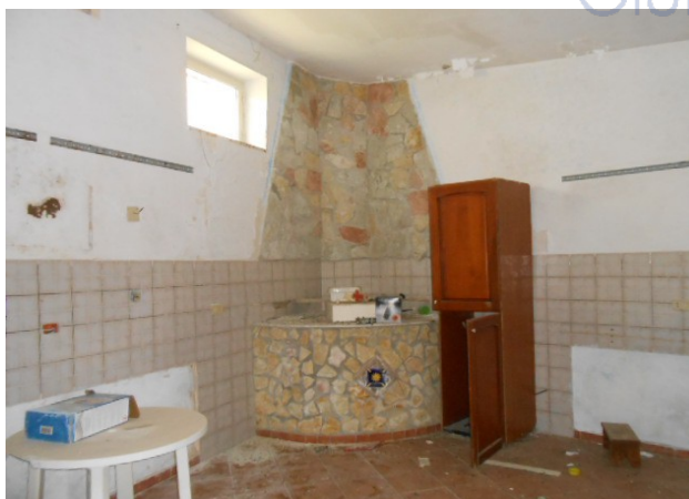
21. Ampliamento Nord-Ovest, interno
