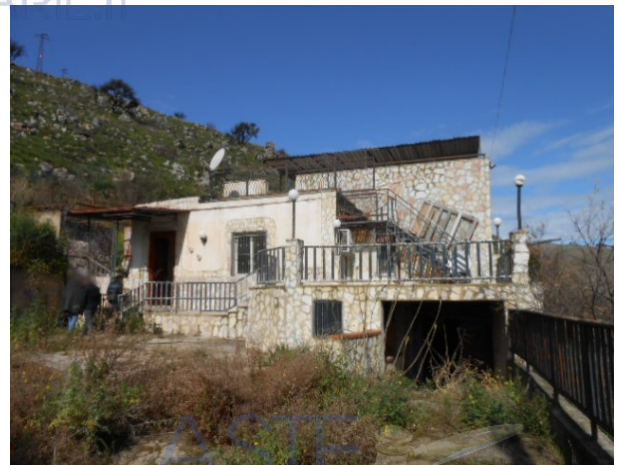
20. Il villino visto dalla corte esclusiva. A destra l'accesso al magazzino o deposito/cantina al piano sottostrada (S1)
