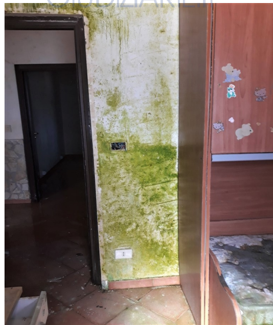
8. Villino originario. Diffuse muffe umide nelle pareti
