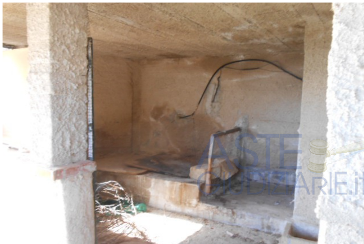
24. Piano sottostrada, il vuoto strutturale
