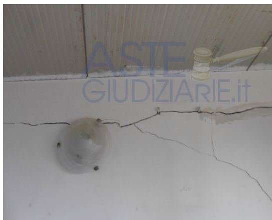
16. Ampliamento lato Nord, grave frattura macroscopica
