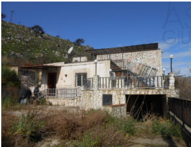
1. Prospetto Sud visto dall'interno della corte
