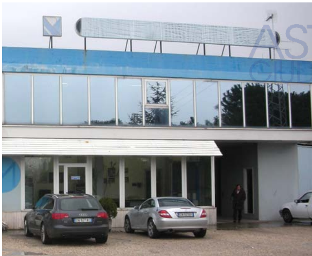
FOTO 2: VISTA UFFICI ED AREA ESPOSITIVA DALL'ESTERNO
