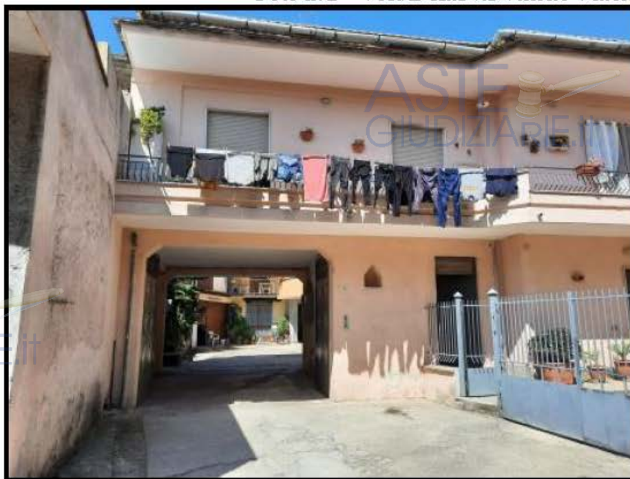
Foto n. 2 – Veduta dalla via Vittorio Veneto
