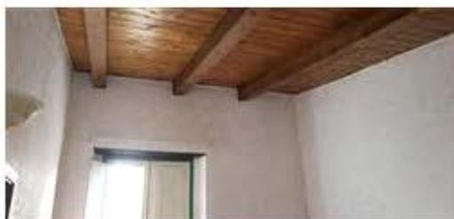
Vista interna dell'abitazione (nella camera da letto) da cui si rileva il nuovo solaio di copertura e l'assenza del solaio di sottotetto
