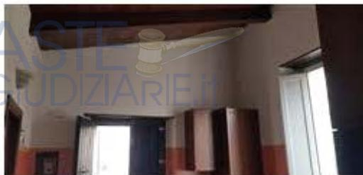
Vista interna dell'abitazione (nella cucina) da cui si rileva il nuovo solaio di copertura e l'assenza del solaio di sottotetto
