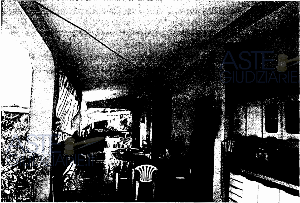
Vista del portico al piano primo dell'abitazione
