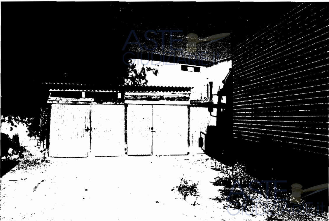
Vista dei depositi non autorizzati
