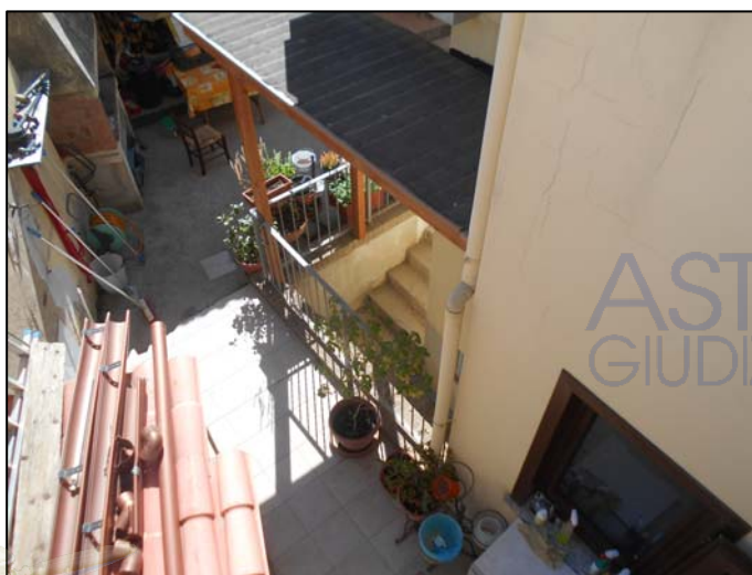
FIGURA 2 – Cortile e accesso cantina interrata.
