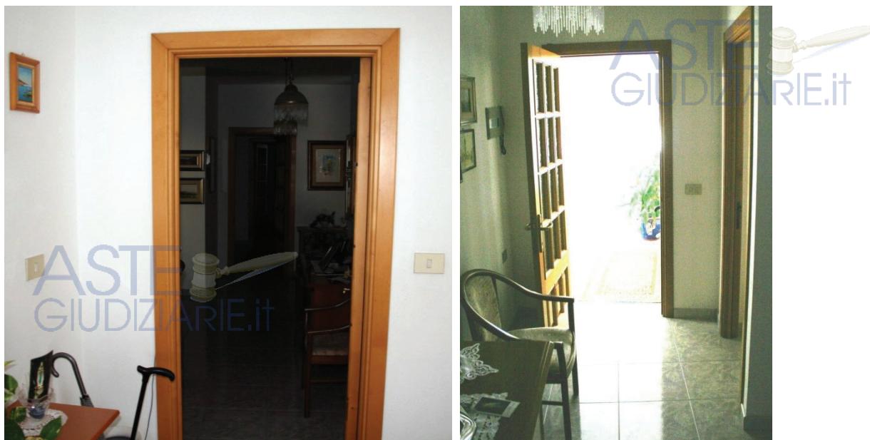
Foto 052 e 053 – Ingresso/Uscita unità immobiliare
