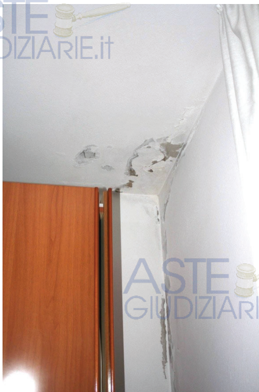
Foto 060 e 061 – Camera n.1 e particolare infiltrazione acqua piovana
