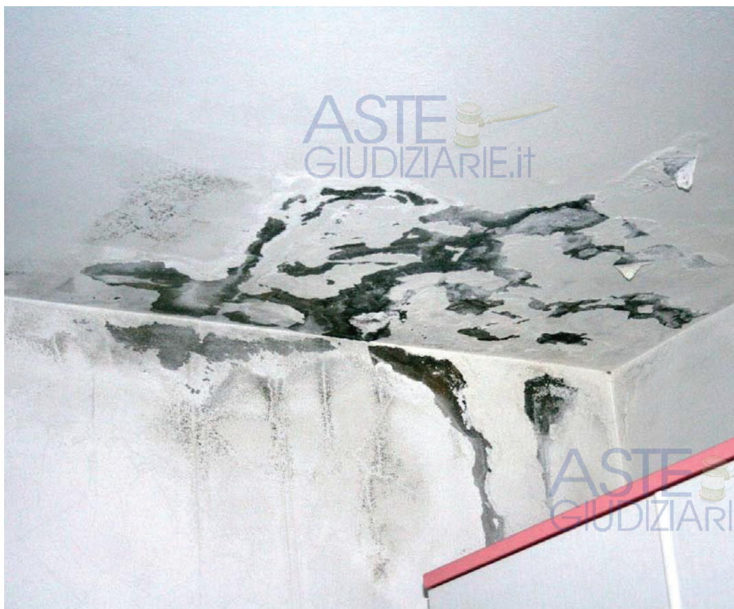
Foto 063 – Camera n.2, particolare infiltrazione acqua piovana
