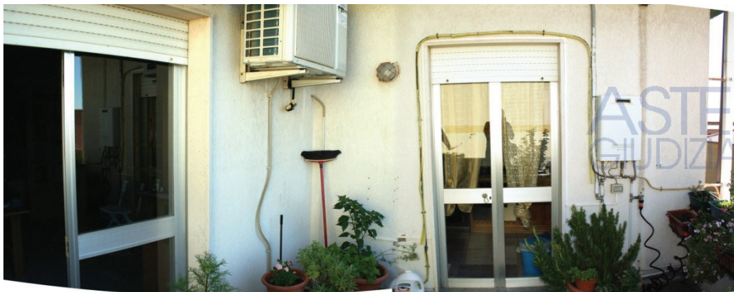
Foto 070 – Terrazza, vista panoramica degli ingressi di soggiorno e cucina
