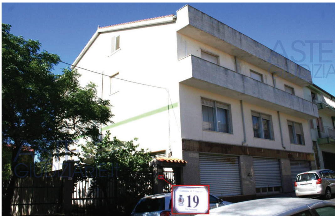
Foto 011 – Prospetto via Stazione
