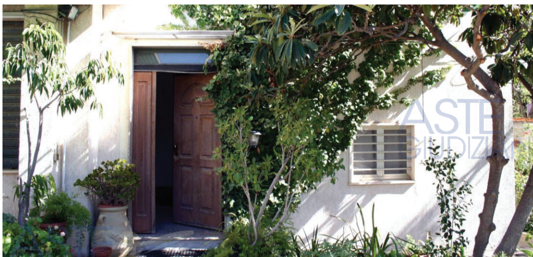
Foto 014 – Prospetto Sud - Ingresso vano scala
