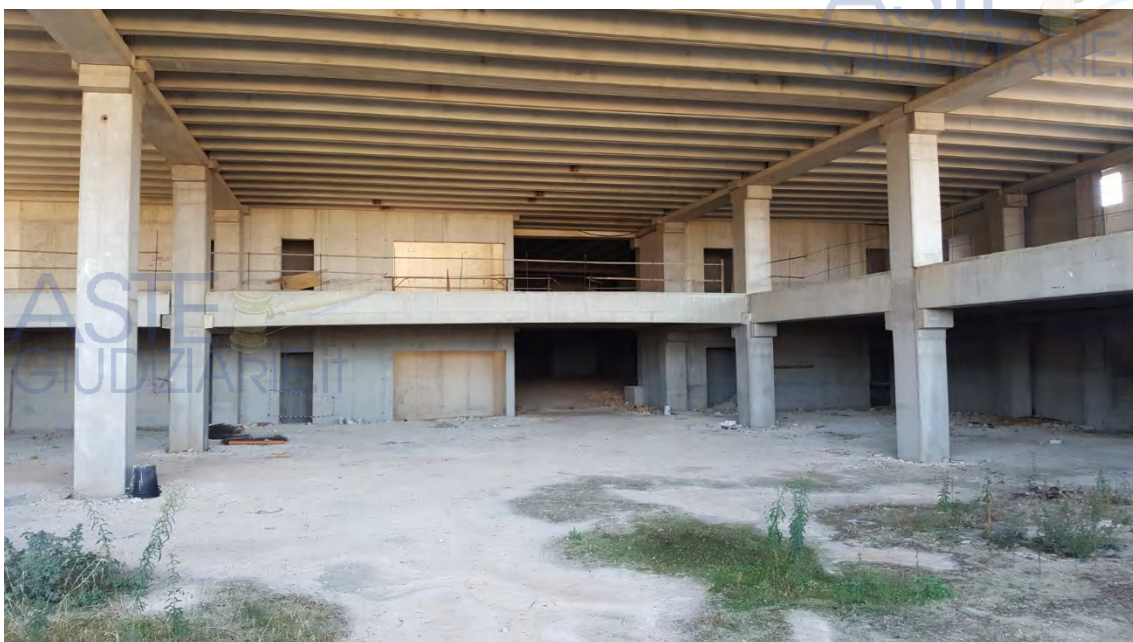
Foto n.2: Vista parziale delle aree poste ai livelli entrotterra dell'edificio alberghiero, nel segmento destinato a sala conferenze.
