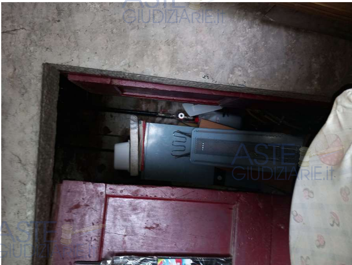
ripostiglio piano terreno
