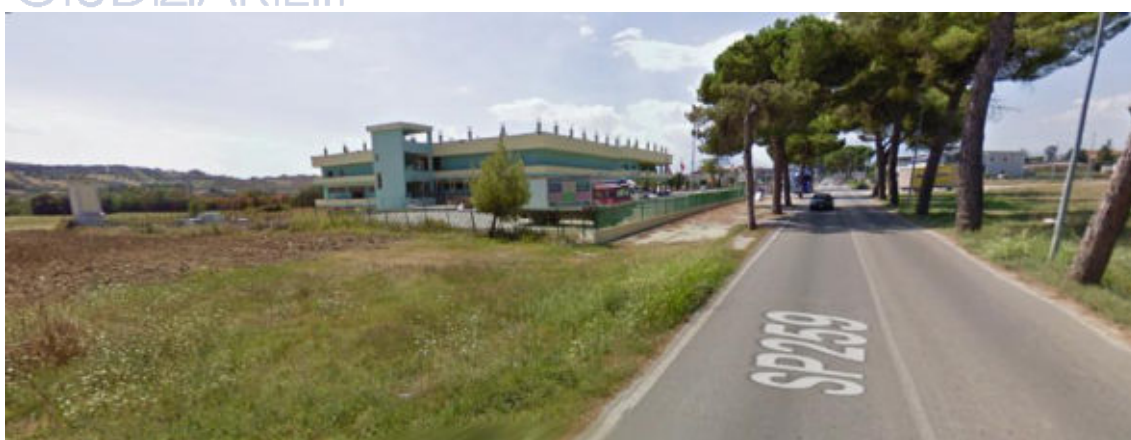
foto n. 2 – Vista Edificio Commerciale da SP259, lato Nord-Est
