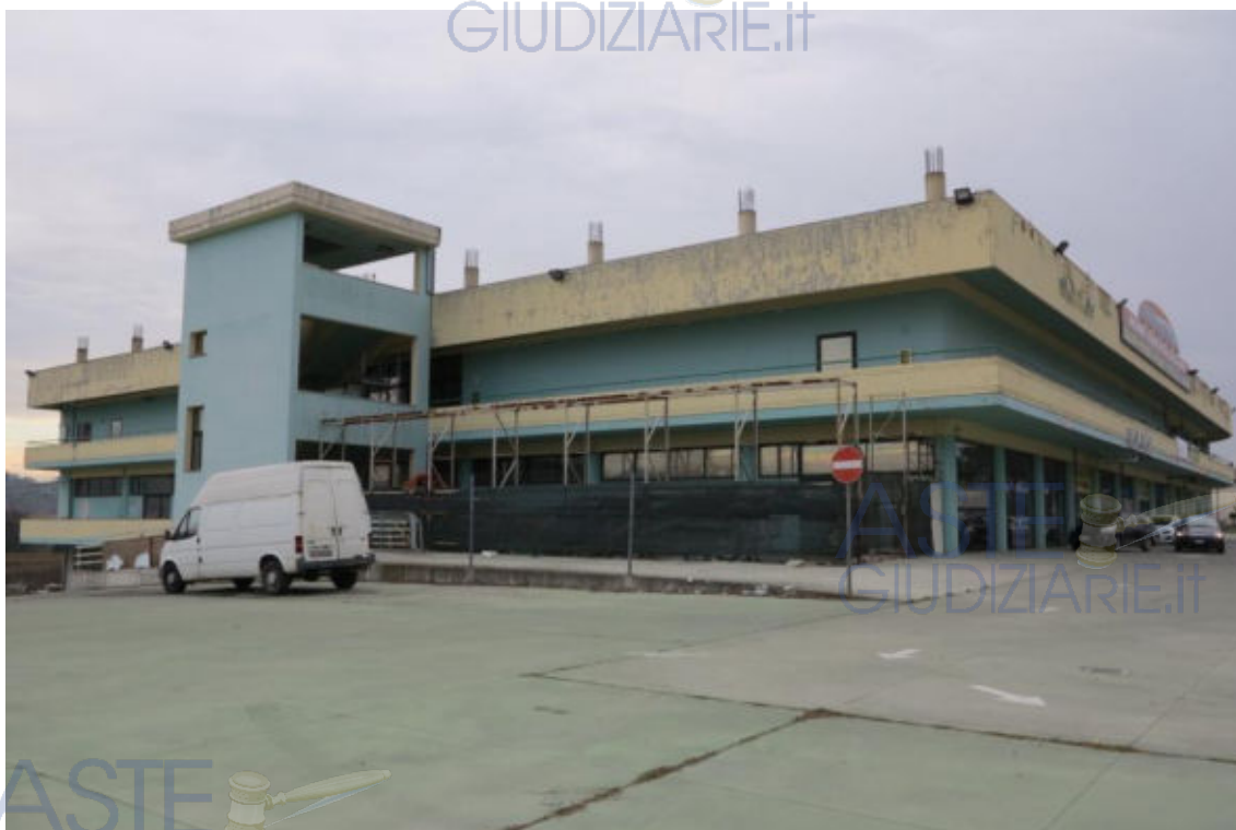
foto n. 3 – Vista Edificio Commerciale lato Nord-Est
