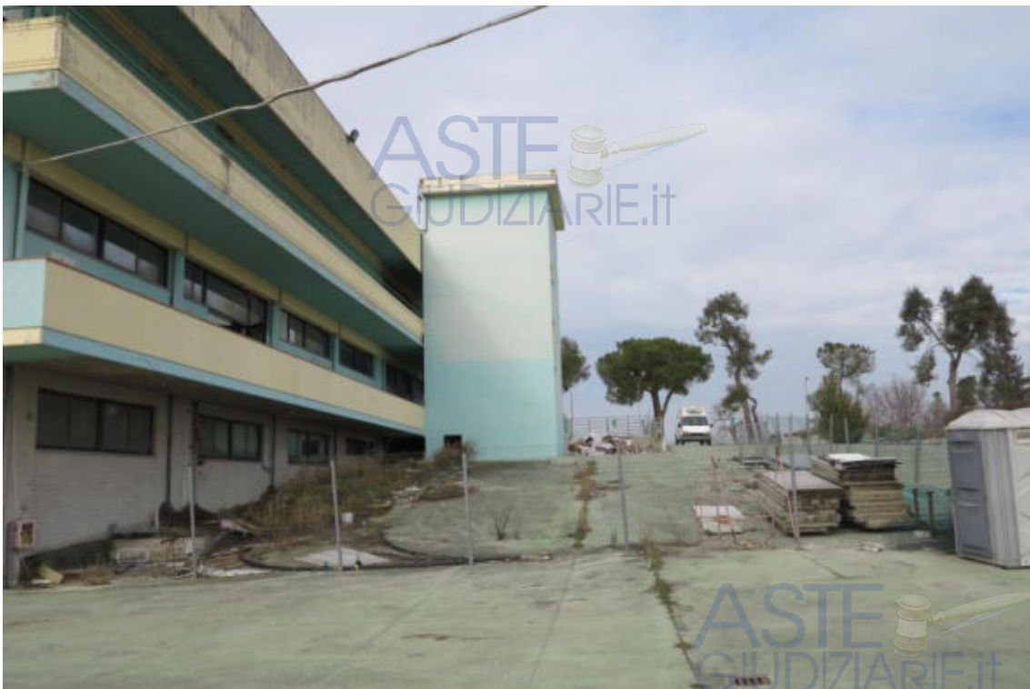
foto n. 11 – Vista lato Est
