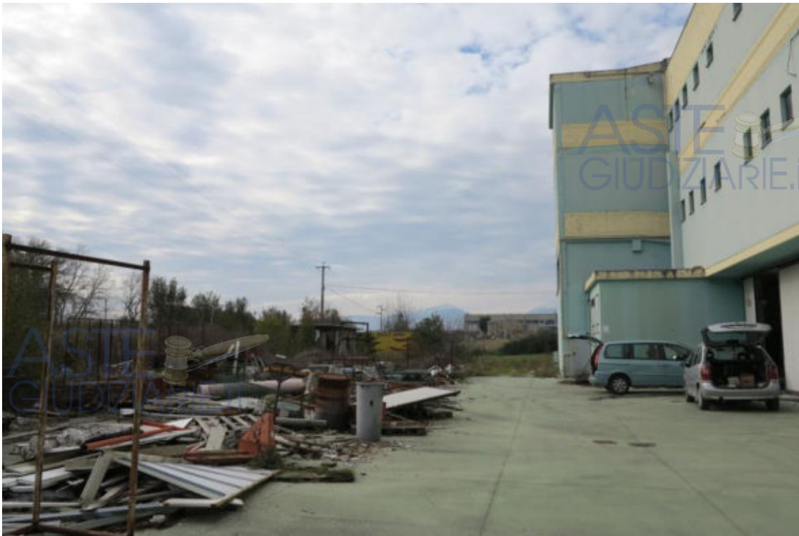
foto n. 10 – Area esterna lato Sud
