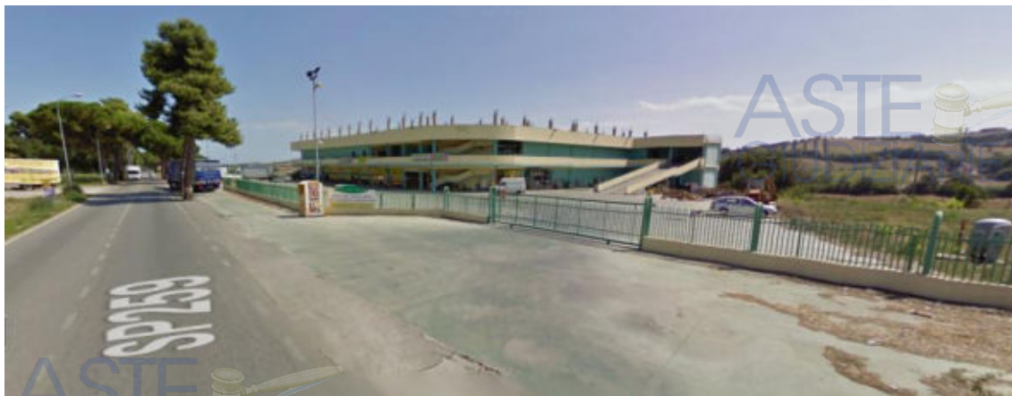
foto n. 1 – Vista Edificio Commerciale da SP259, lato Nord-Ovest
