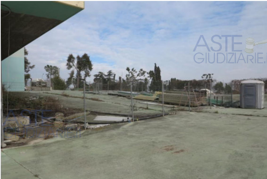
foto n. 12 – Vista lato Est
