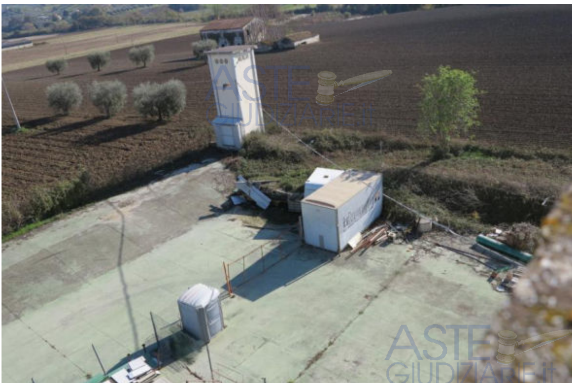
foto n. 13 – Vista lato Est – Cabina Enel
