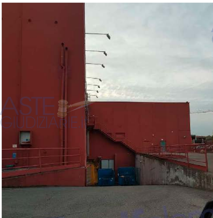
Ingresso piano interrato lato Est.
