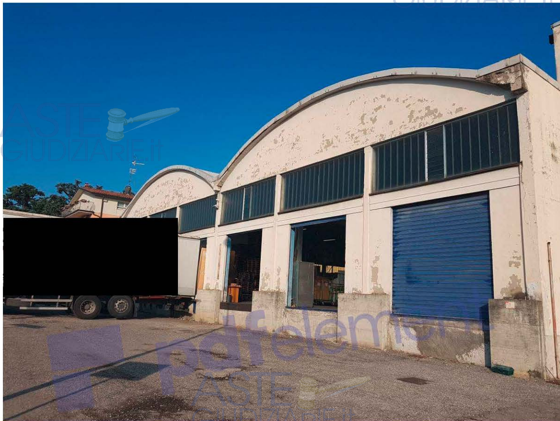
Prospetto su Via Rovato – zona magazzino aree di carico/scarico
